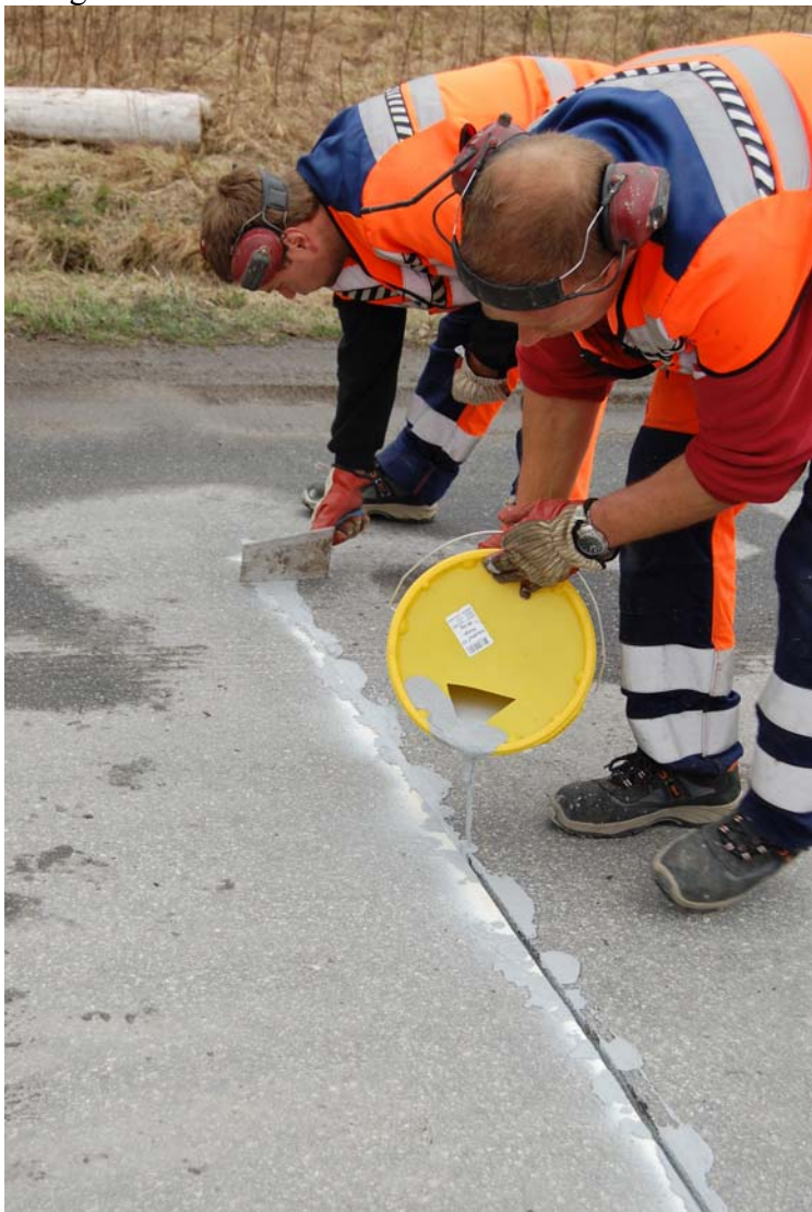
Figur V24.6. Sporene fylles igjen etter nedlegging av kabler på Fv. i Hedmark, april 2009.
