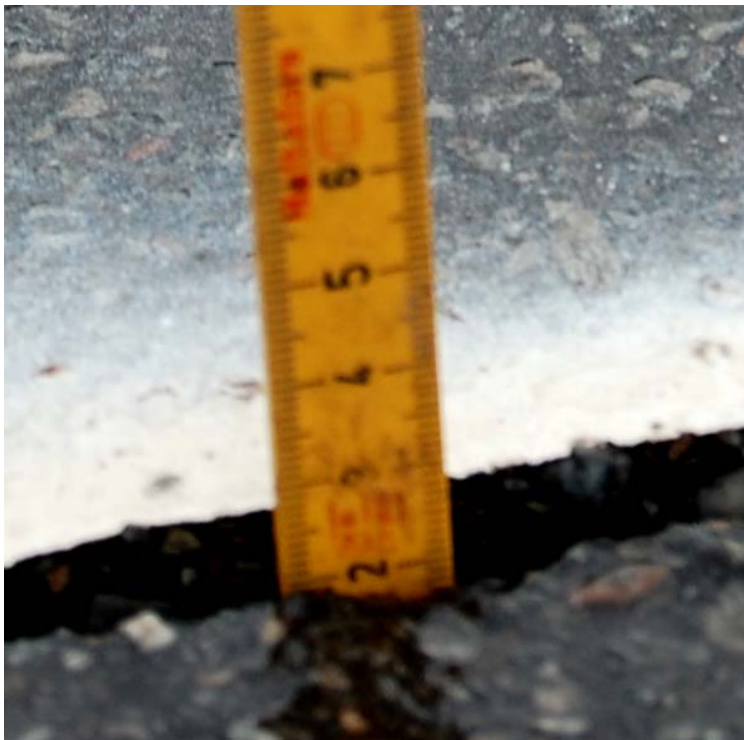
Figur V24.4. To cm dype spor til nedlegging av kabler på Fv. i Hedmark, april 2009.
