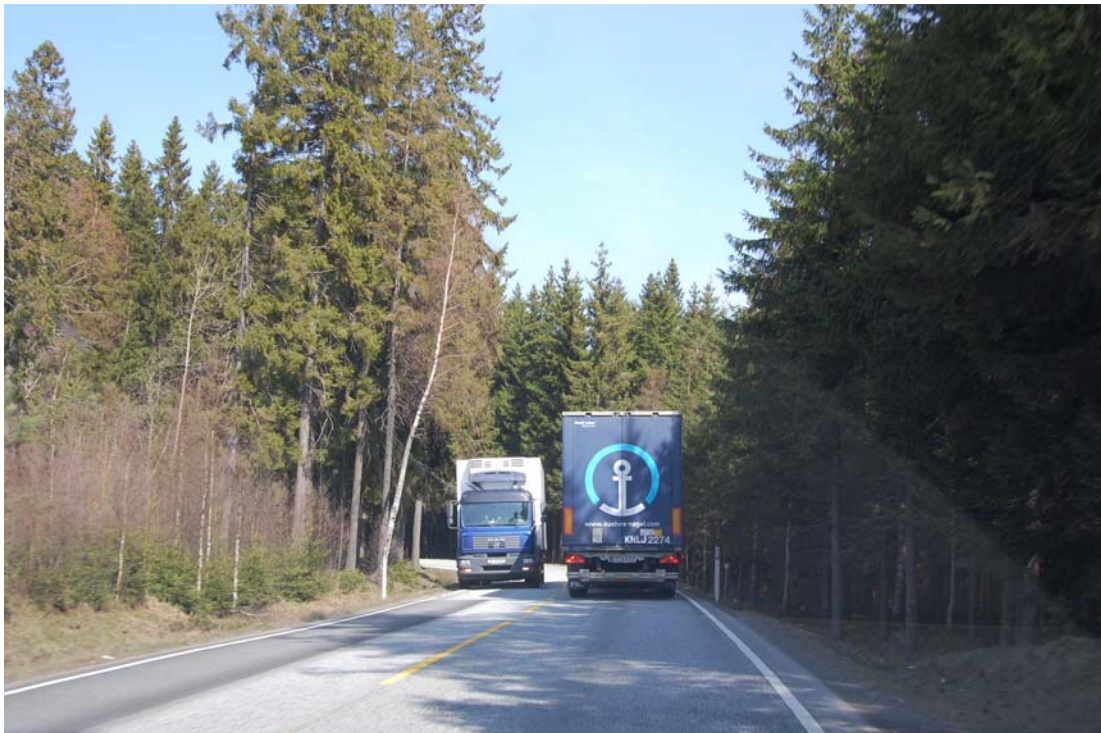
Figur 7.2 frv 120 i Østfold. Hastighetsreduksjon som følge av smal vegbredde i kombinasjon med sving. Foto: Knut Nygård
