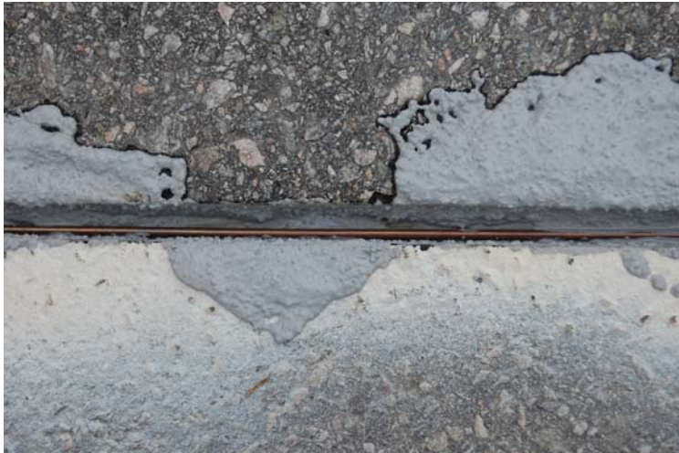
Figur V24.5. Kabel for registrering av akslelast og totalvekt på Fv. i Hedmark, april 2009.
