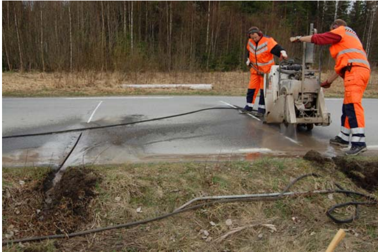
Figur V24.3. Fresing av spor i asfaltdekket på Fv. i Hedmark, april 2009.
