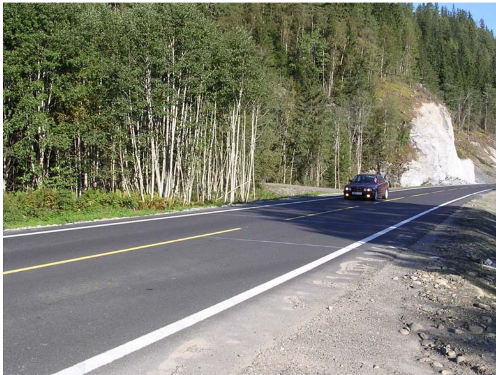
EV 6 Sør-Trøndelag på strekningen Støren-Oppdal. Punktet i nord, bildet tatt med kilometreringsretningen (retning Støren).
