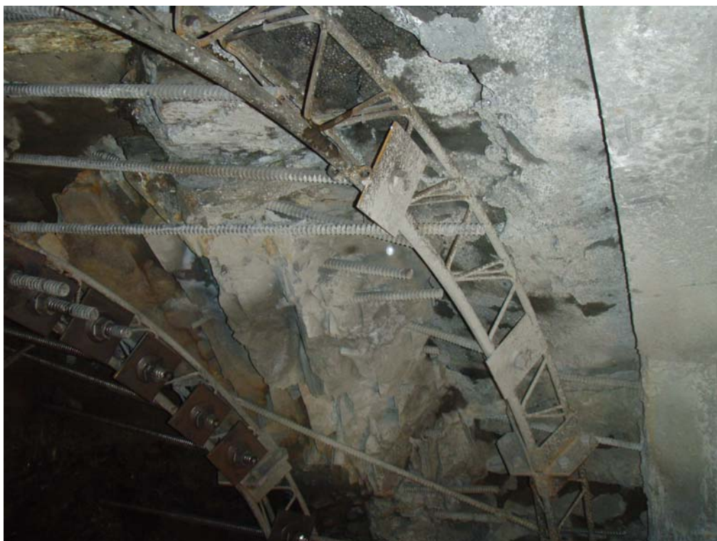
Figur C.5 Sikring med prefabrikerte gitterbuer, Akersgata, Oslo (foto: O. Haugen).
