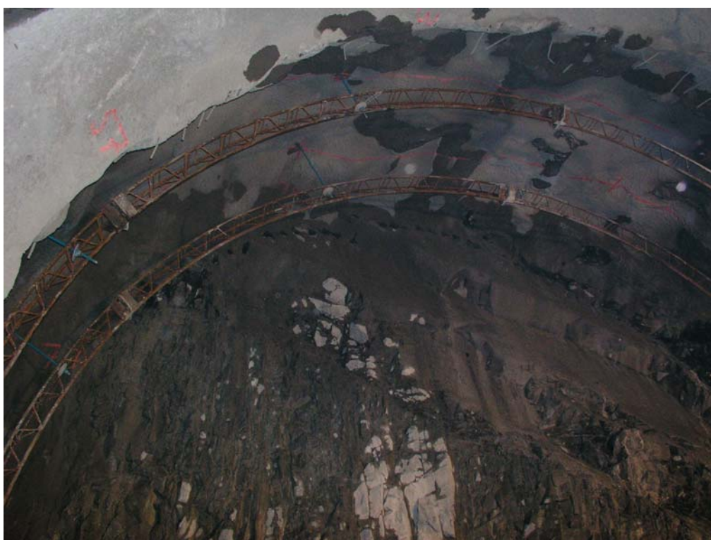
Figur C.6 Sikring med prefabrikerte gitterbuer i T-baneringen, Oslo (foto: O. Haugen).
