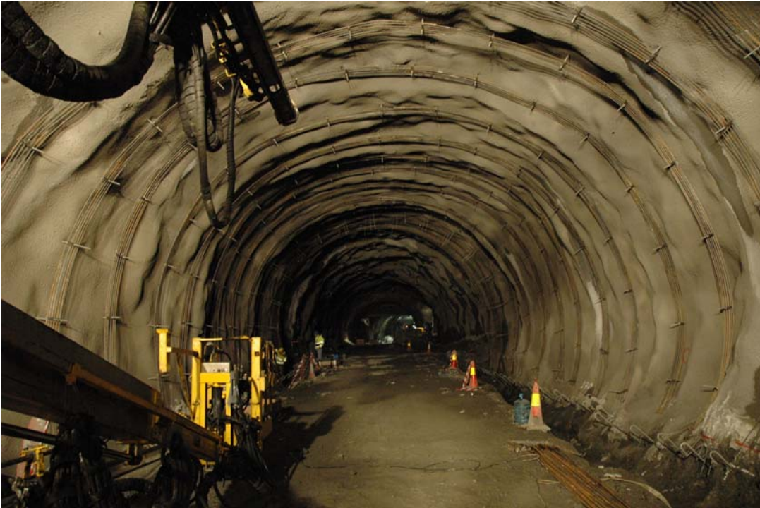
Figur C.3 Sikring med armerte sprøytebetongbuer i Grønliatunnelen 2008 (foto: A. Kveen).
