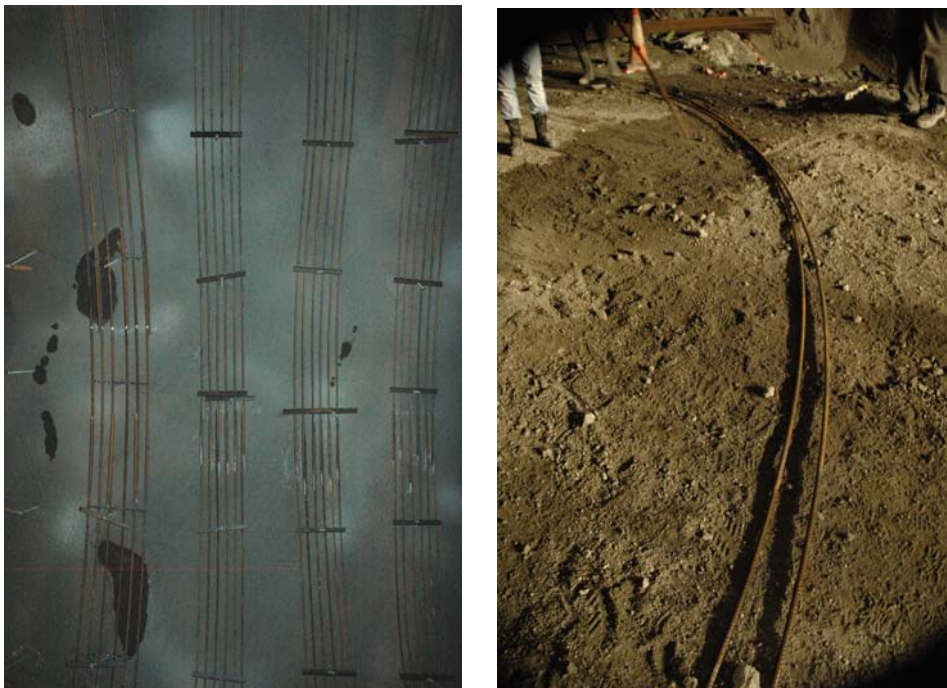
Figur C.2 Fra montering av armerte sprøytebetongbuer i Grønliatunnelen 2008 (foto: A. Kveen). Bildet til venstre viser armeringsjern for fire buer: en med \varnothing 20 mm lengst til venstre og tre med \varnothing 16 mm. Armeringsjern \varnothing 20 mm som er forhåndsbøyd gir et bedre profil og er foretrukket løsning. Bildet til høyre viser forhåndsbøyd armeringsjern \varnothing 20 mm.
