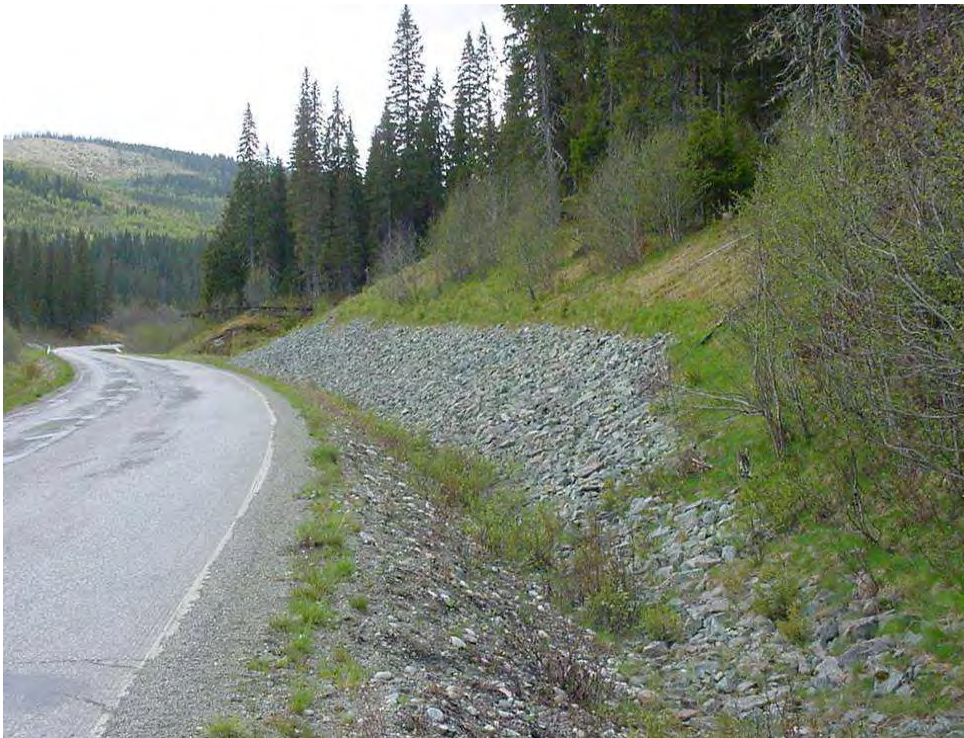
Figur 3-2- 26 Masseutskifting i skråningsfot (Gartland i Nord-Trøndelag, Foto: Kjell Eriksen).
