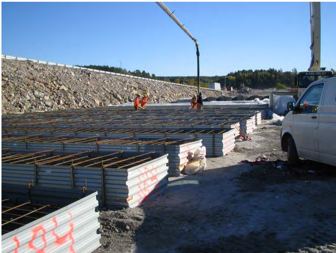
Figur 1-5- 18 Støping av betongstriper over peler (foto: Yngvar Hanson)
