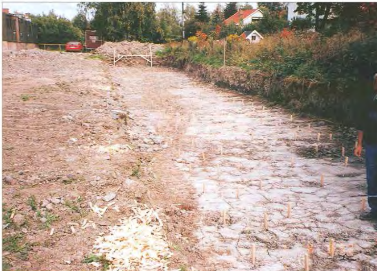
Figur 1-7- 11 Bildet viser ryddet areal hvor hardt topplag er gravd ut og pelepunktene markert med stikk
