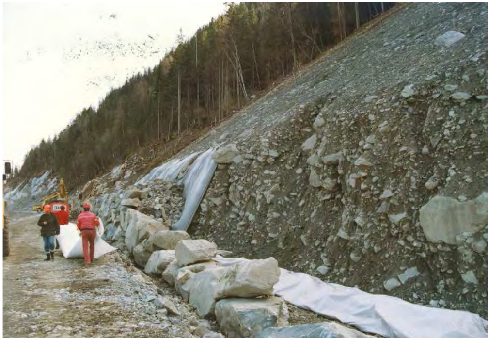
Figur 3-3- 8 Tinnsjøvegen, Telemark. Erosjonssikring av skjæring i ur med fiberduk før permanent sikring med tørrmur. (Foto: Emil Gyøry, Telemark).
