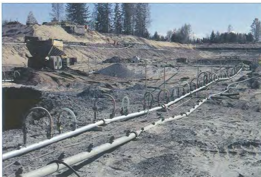
Figur 1-9- 1 Anlegg for grunnvannsenkning
