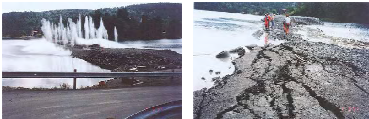
Figur 1-3- 7 Eksempel på ettersprengning av fylling lagt ut med Flekkefjordmetoden (Foto: Frestad/Pedersen)
