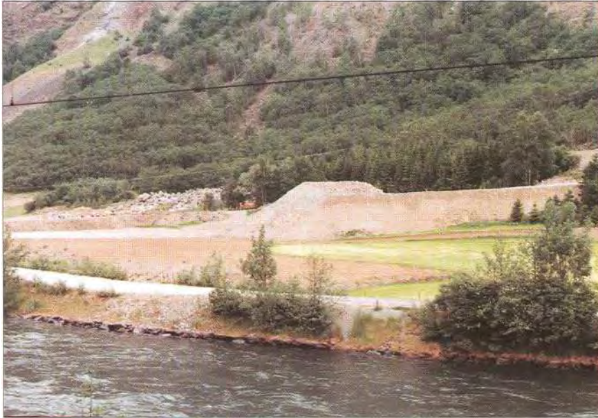
Figur 1-1- 7 Tilløpsfylling, med forbelastning, for Brekke bru i Flåm (Foto: Frode Oset).
