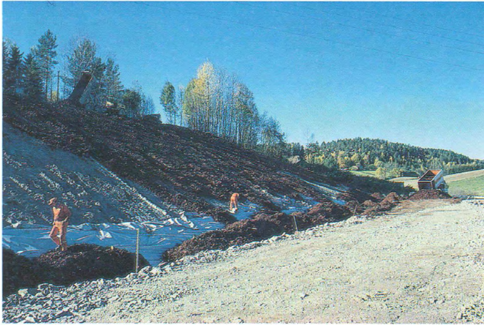
Figur 3-2- 23 Legging av barkoverflate på siltskråning ved rv 36 i Telemark sommeren 1984, (Foto: Birger Aase).
