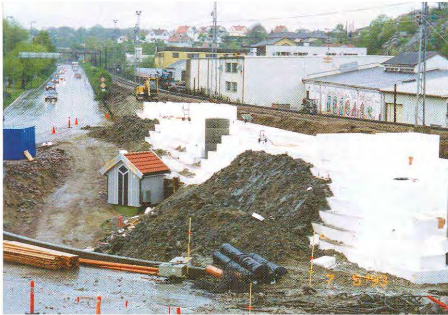
Figur 2-4- 7 EPS-fylling (Foto: K.Brattvang, Statens vegvesen Østfold)
