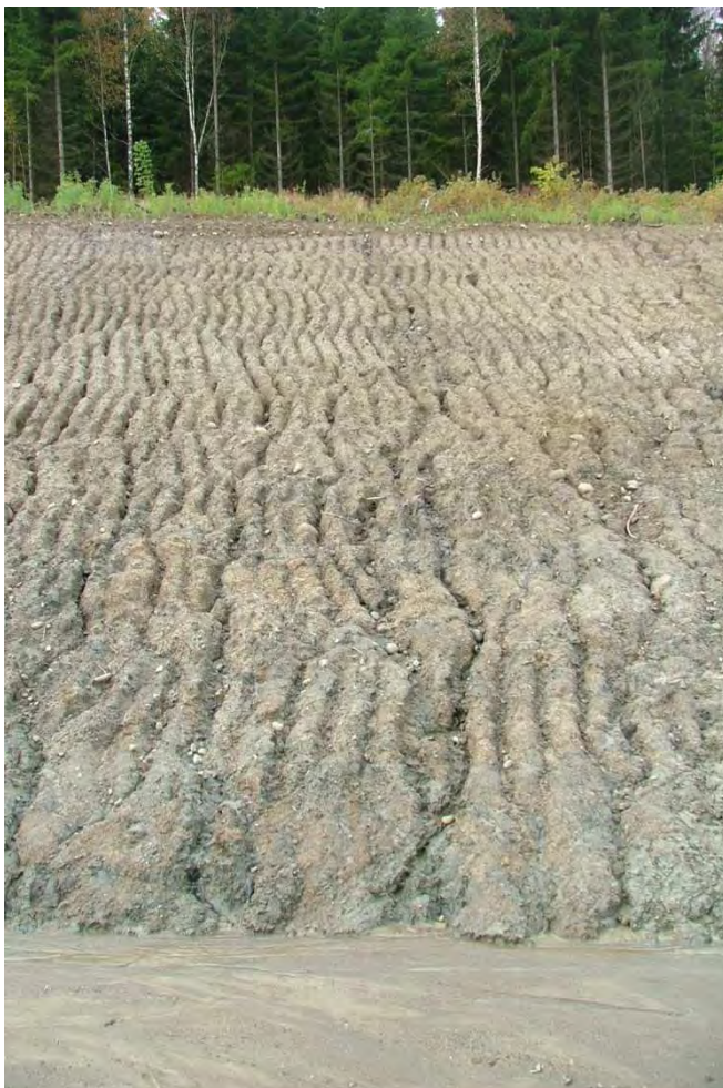
Figur 3-2- 6 Eksempel på overflateerosjon (Foto: Kristine Flesjø, Teknologivdelingen).
