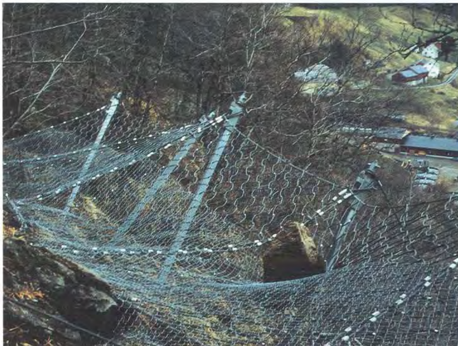
Figur 3-1- 36 Steinsprang i rasgjerde (Foto: Veglaboratoriet)
