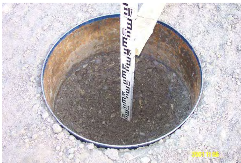
Figur 2-4- 26 Prøvetaking av komprimert skumglass (Foto: Kjell Eriksen, Statens vegvesen)
