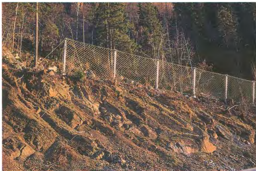
Figur 3-1- 6 Fleksibelt rasgjerde (Foto: Veglaboratoriet).
