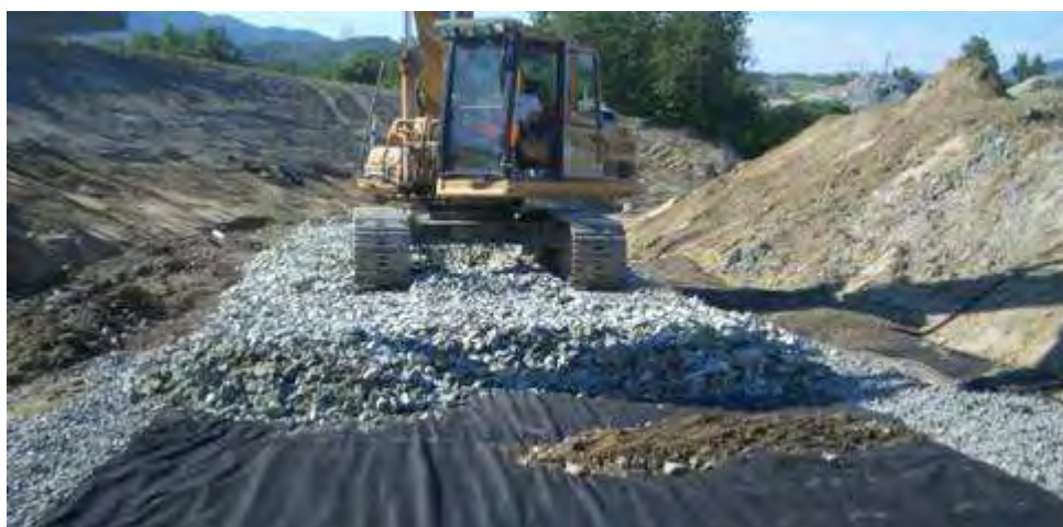
Figur 2-4- 23 Utlegging og komprimering av skumglass med lett gravemaskin(Foto: Melhusprosjektet).
