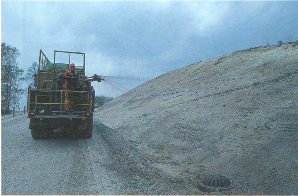
Figur 3-2- 25 Tilsåing med sprøytevogn direkte på skråningsoverflaten, (Foto: Birger Aase).
