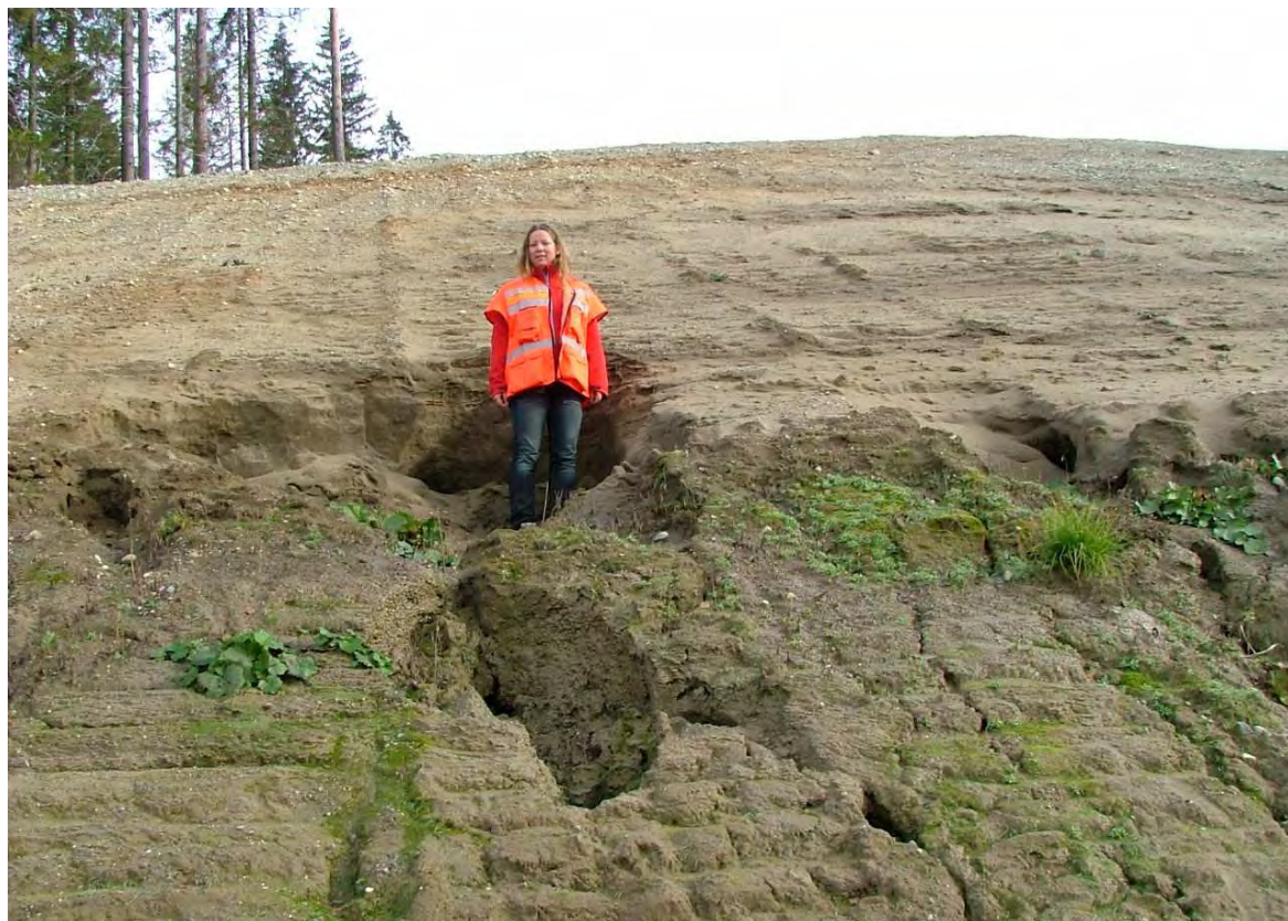
Figur 3-2- 7 Eksempel på grunnvannserosjon (Foto: Thorbjørn Hansen, Region øst).
