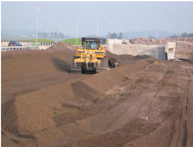
Figur 2-4- 3 Utlekking av lettklinkerfylling for E18 ved Gulli (Foto: Jon Hauge)
