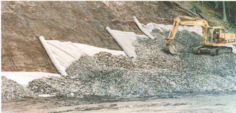
Figur 2-3- 1 Dersom grunnen består av erosjonsømfintlige materialer (silt - sand) kan det være nødvendig å sikre grunnen mot erosjon med lag av grov grus/pukk på fiberduk for å hindre utvasking av masser fra skråningen inn i fyllingen. (Foto: Nils Rygg, Veglaboratoriet).
