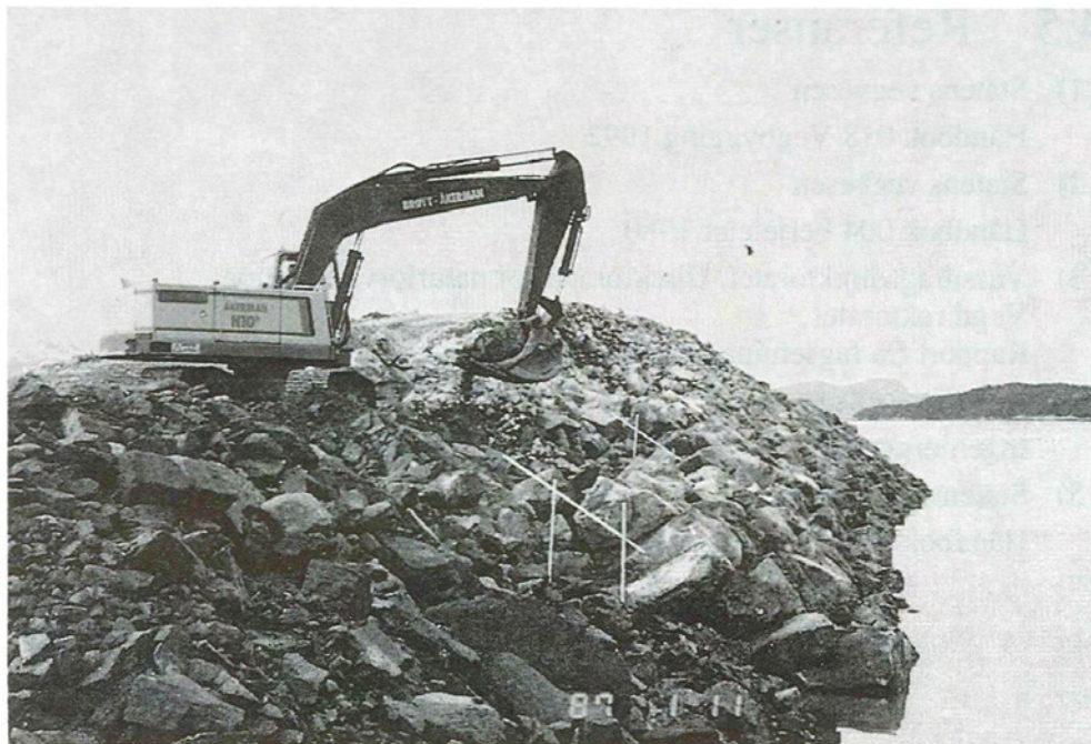
Figur 3-4- 12 Utlegging av steinplastring (Foto: O. Pladsen).
