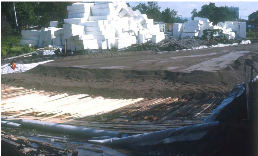
Figur 1-4- 1 Bruk av bakhon som armering under fylling i Fornebukrysset (Foto: Roald Aabøe)
