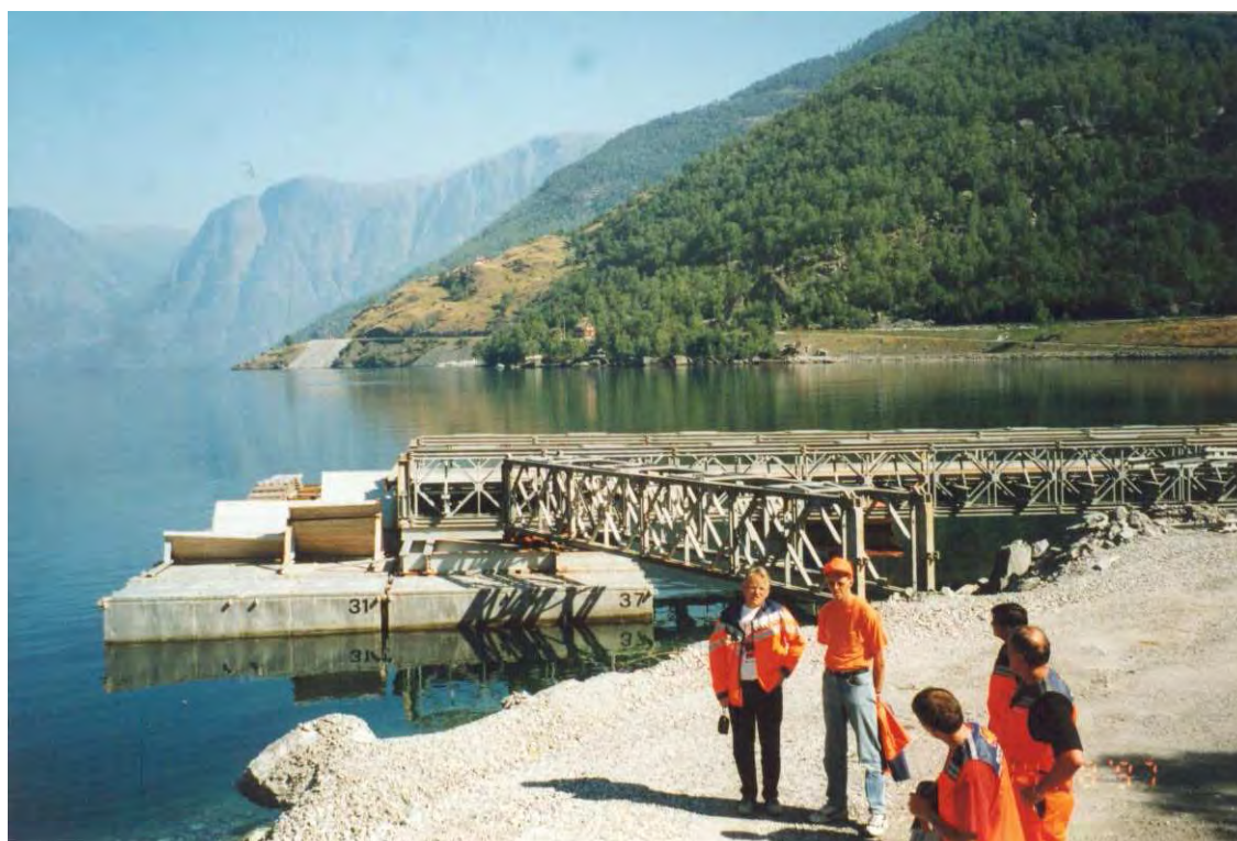
Figur 1-3- 9 Utfylling i sjø med bruk av Bailey bru og flåter (Foto: Frode Oset)
