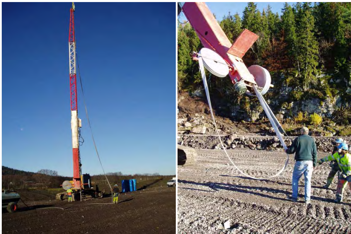
Figur 1-6- 8 Bildet viser rigg og rullen med vertikal dren montert. Legg merke til vannslangen som er koblet til riggen for spyling av stikkeren. (E18 Kopstad – Gulli 2004 – Foto: C.E. Dahl)
