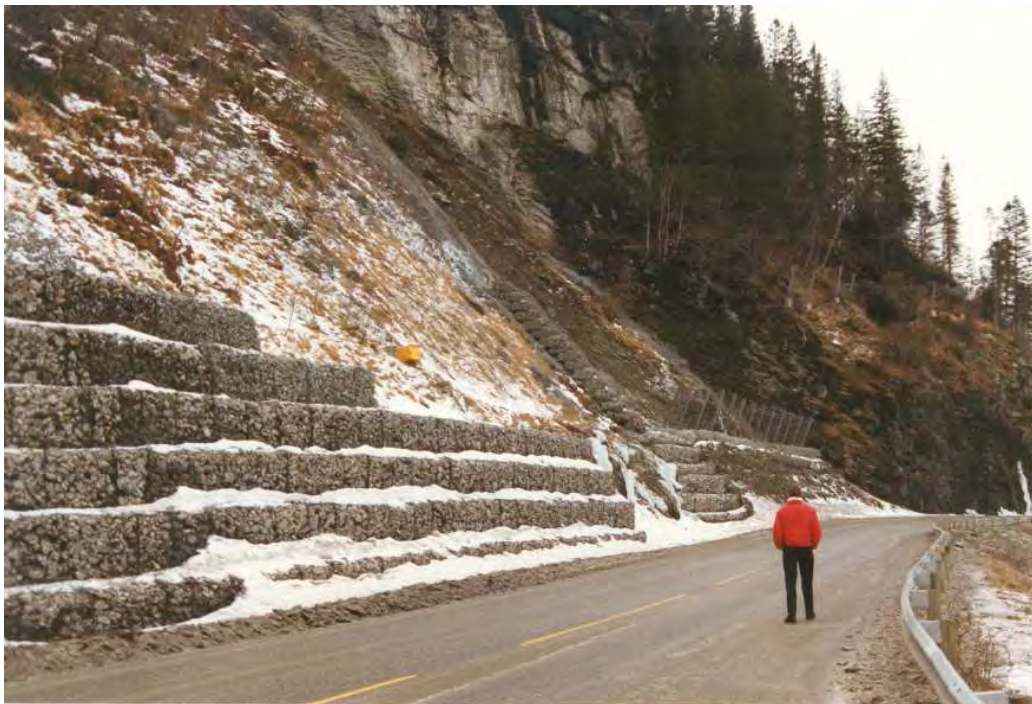
Figur 3-3- 10 Sikring av rasskråning i ur med gabioner og ubåtnett på Rv 715 ved Løften. Fanggjerde på topp av gabionmur for å sikre mot steinsprang (Foto: O.P.Wangen).
