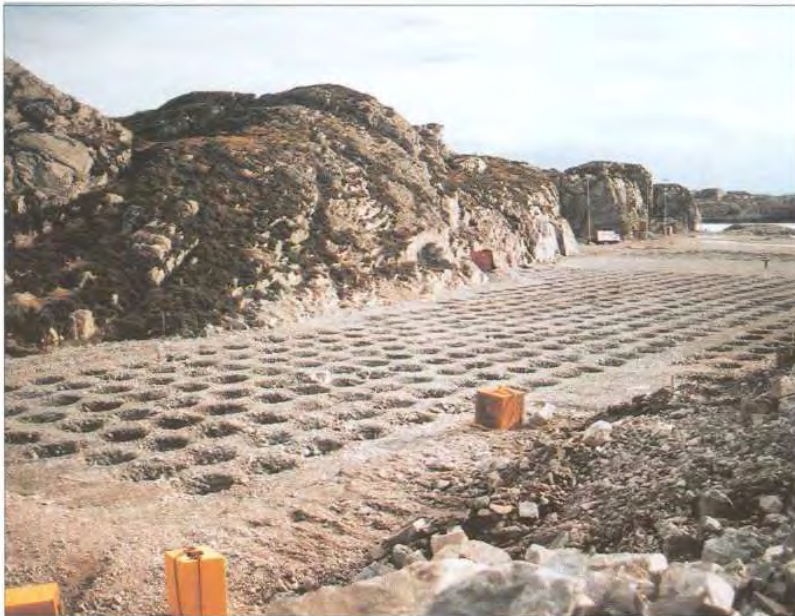
Figur 1-11- 2 Dypkomprimering, Kollsnes. (Foto: Noteby)
