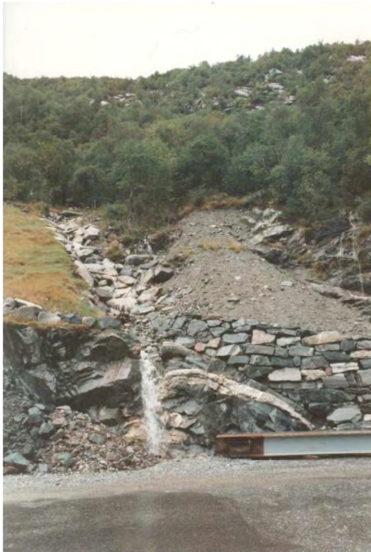
Figur 3-3- 11 Høyanger Sogn og Fjordane. Erosjonssikring av vannsig i ur med steinsetting. (Foto: O. P. Wangen).
