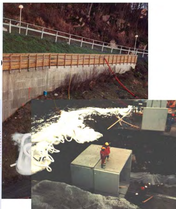
Figur 1-10- 8 Frysestabilisering av løsmasser over tunnelpåhugg under støttemur, Hamang, Akershus. (Foto A-L. Berggren)
