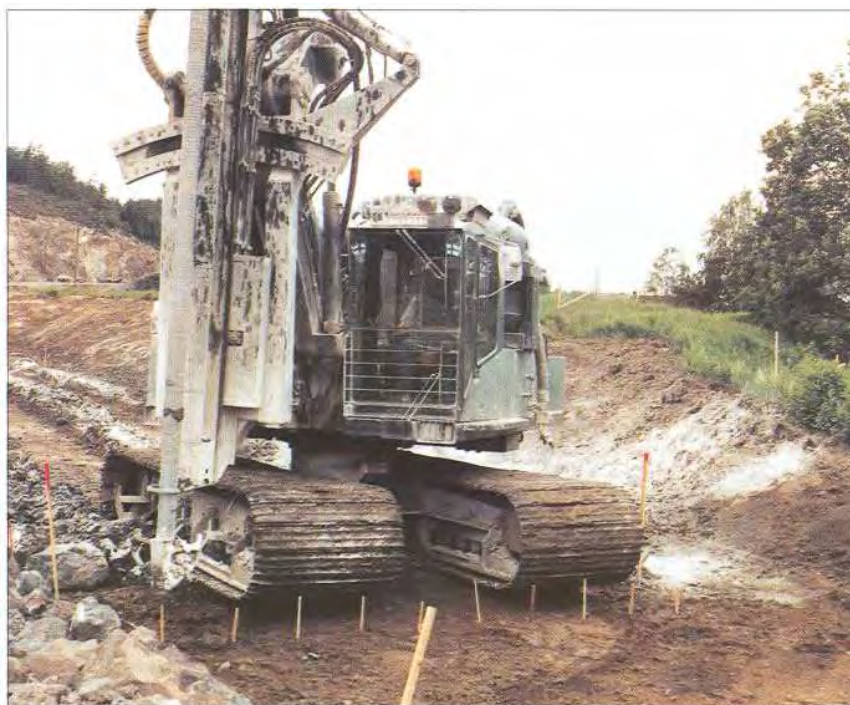
Figur 1-7- 1 Rigg som setter kalkpeler for E18 i Tvedestrand
