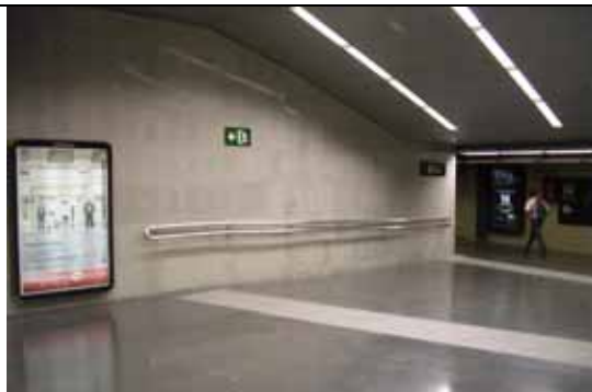
Bilde 46 Metro Barcelona. Eksempel på bred nedramping i fotgjengerareal med doble håndlister og markering av start og slutt på rampen. (Legg merke til at belysningen understreker gangretning)
