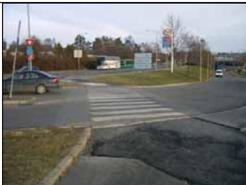
Bilde 35 Alnabru, Oslo. Opphøyet gangfelt i gangveg/fortau over innkjøring til kjøpesenter. Overgangen til kjøreareal er markert med svak nivåforskjell. Her bør det også være varselfelt.
