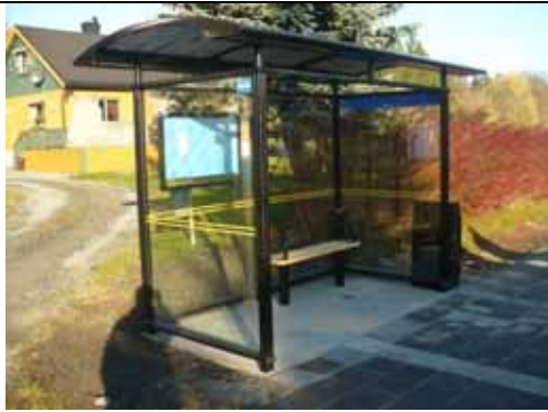
Bilde 57 Porsgrunn, Mule. Lehus med benk med armlene, plass til rullestol, kontrastmerking, oppmerksomhetsfelt til påstigning og steinheller på arealet foran lehuset.
