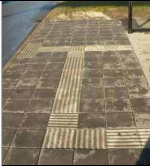
Bilde 60 Porsgrunn. Detalj av ledelinjer og belegg på holdeplass
