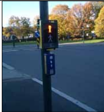
Bilde 33 Oslo, Bispegata. Signalanlegg med signal på samme side som man venter (PUFFIN-anlegg).
