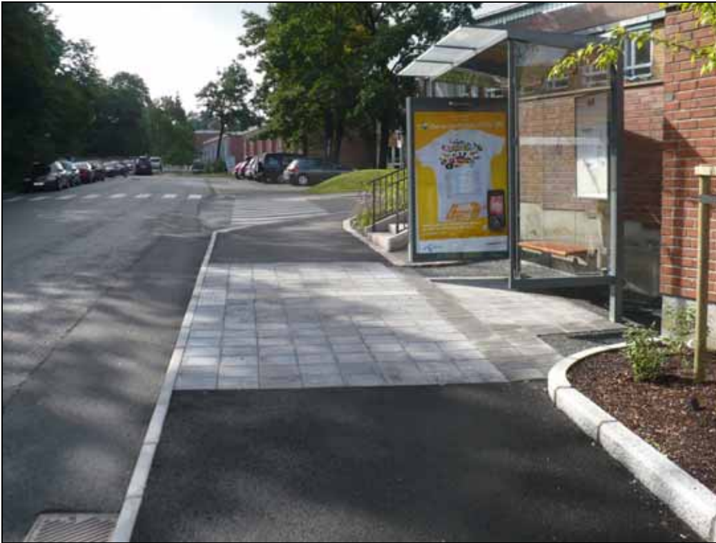
Bilde 51 Holdeplass ved Porsgrunn sykehus
