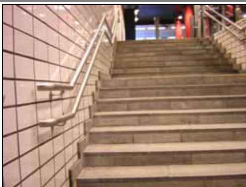
Bilde 45 Oslo S. Riktig utformet håndlist i to høyder som begynner før trinnene.
