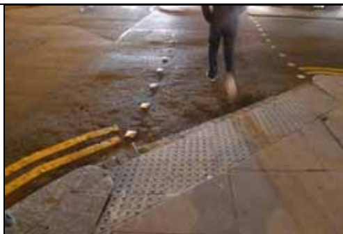
Bilde 29 London, Storbritannia. Varselfelt og sidekant angir riktig retning i et svært skrått gangfelt. I Norge ville vi ha merket opp gangfeltet, og ikke benyttet taktile metallplater/refleksplater til å angi dette.
