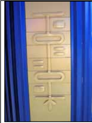
Bilde 32 Oslo, Stortingsgata. Taktil angivelse av gatekryssing på boksen på signalanlegget.
