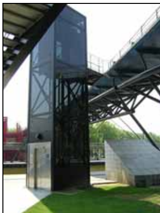
Bilde 50 Paris Frankrike. Heis ved gangbro.
