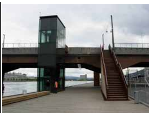
Bilde 49 Drammen. Heis i den svært populære forbindelsen langs elva.
