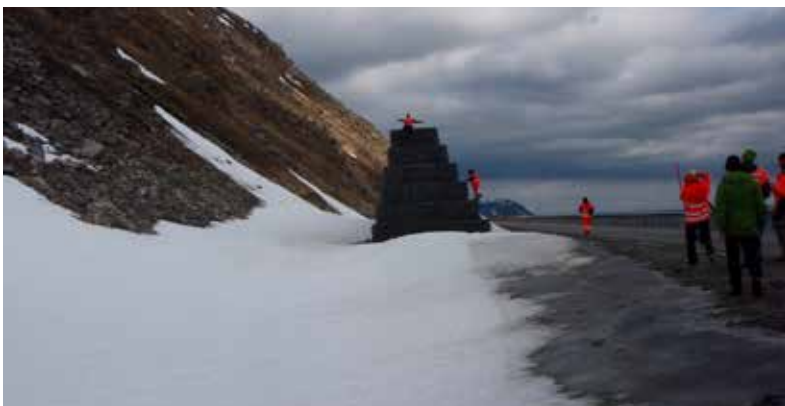
Fig 8.33. Bruk av bred grøft for å fange opp mindre skred. I bakgrunnen er det satt opp en fangvoll av gabionnett, hvor skredene kommer med større mektighet. Fv. 889 Havøysund, Finnmark. Foto H.Norem
