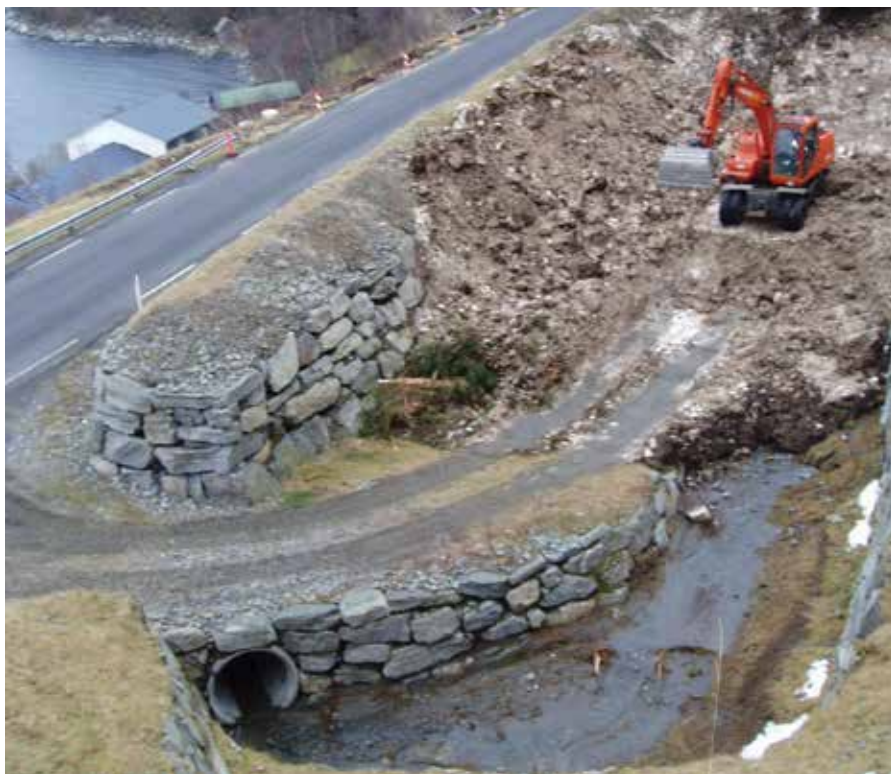
Figur 8.27 Kombinert buet voll og fangvoll hvor innløpet til reserve stikkrenne er plassert til side for vollen og beskyttet for å bli tettet av skredmasser. E39, Storegjølet, Møre og Romsdal. Foto: H. Norem
