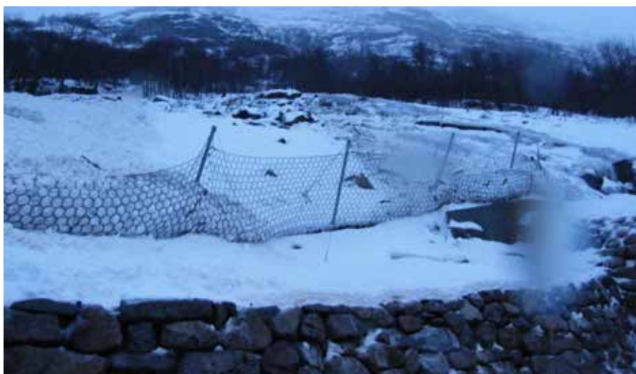
Figur 8.13 Eksempel på bruk av nett for å fange opp mindre snø- og sørpeskred. Foto: S.H. Frækaland
