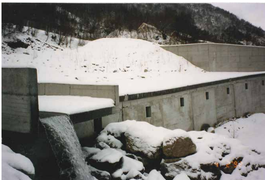
Figur 8.8 Eksempel på skredoverbygg hvor vannet føres over taket av overbygget i en vannrenne og hvor området nedenfor vannrenna er erosjonssikret. Årsnesfonna, Fv 41 Hjørundfjorden, Møre og Romsdal. Foto: H. Norem
