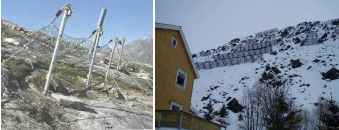
Figur 8.11 Eksempler på støtteforbygninger mot snøskred. Til venstre nettkonstruksjon og til høyre forbygning av stål. Foto: J. O. Larsen og H. Norem
