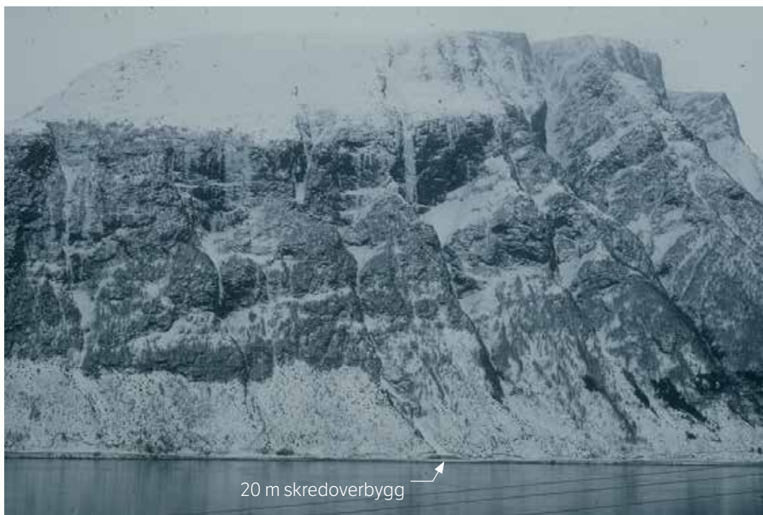
Fig 9.3. Ved valg av prioritering er det viktig å sikre lengre vegstrekninger som er utsatt for skred som utløses under like værforhold. Langs denne vegen er det bygget et 20 m langt skredoverbygg. Dette ble prioritert fordi det skjedde en ulykke på dette stedet. Med hensyn til framkommelighet og redusert stengningstid har en oppnådd svært lite med å sikre bare et skredløp. Fv 40 Dalsfjorden, Møre og Romsdal. (Foto: H. Norem)
