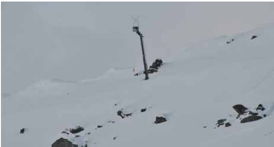
Figur 8.40 Wysse-tårn for senking av sprengstoff mot snøoverflaten og fjernstyrt detonering. Foto: Wysse AG
