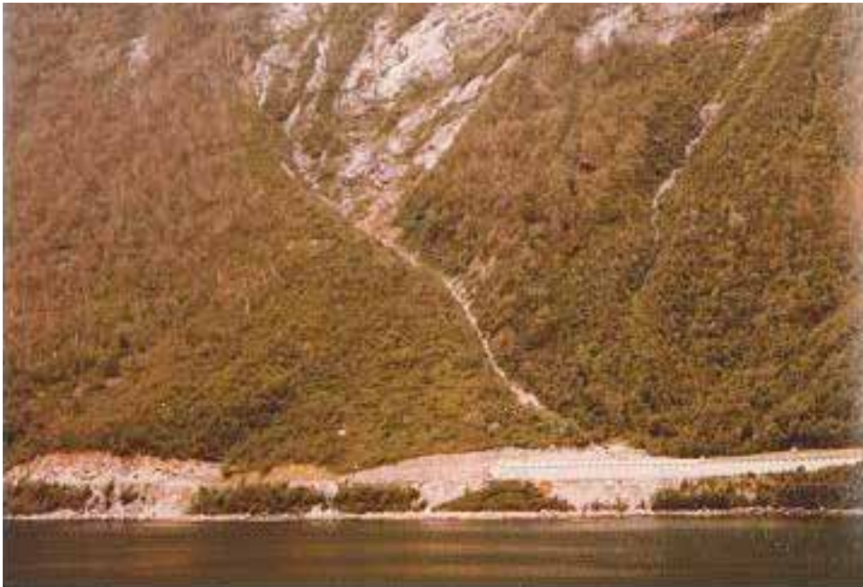
Figur 5.9 Foto av fjellside hvor en rygg i terrenget styrer de tunge skredmassene mot overbygget, mens større skred og snøskydelen av skredene går rett fram og sperrer vegen på venstre side av overbygget, fv 655 Bustene, Møre og Romsdal. Foto: H. Norem
