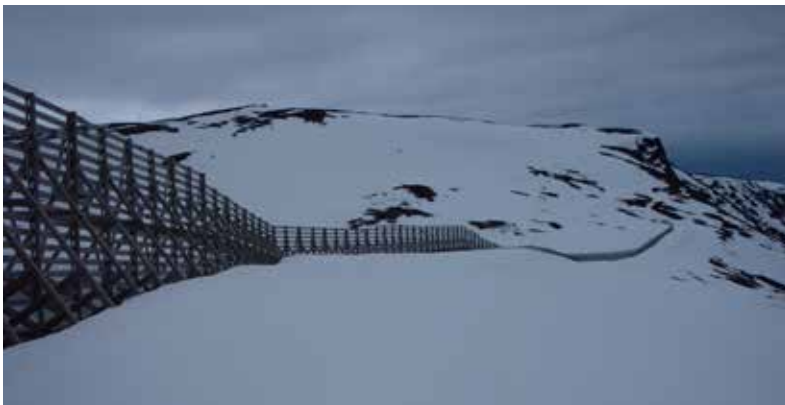
Figur 8.35 Snøskjermer montert for å samle snø på lovart side av skredområdet. Fv.173, Nordvågen, Finnmark. Foto H. Norem
