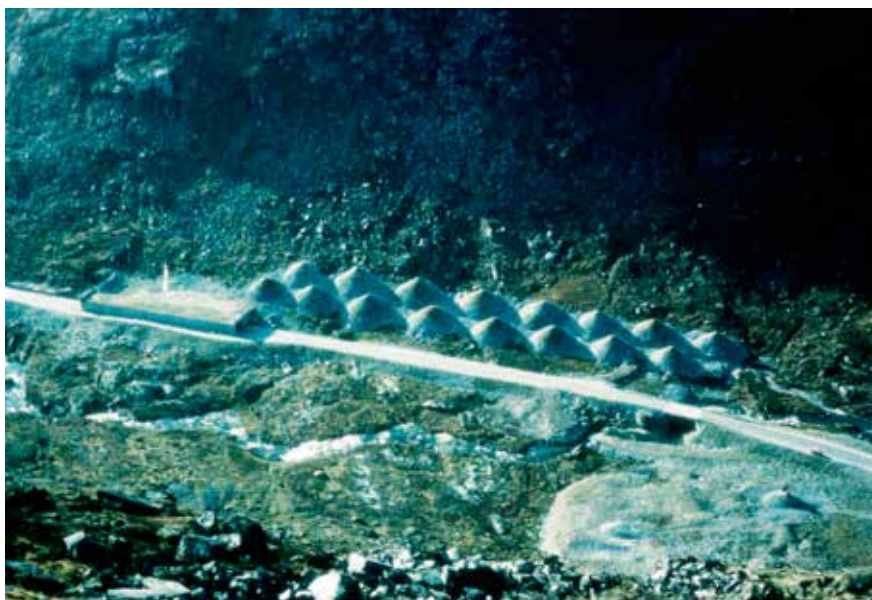
Figur 8.15 Eksempel på bruk av bremseskjegler. Rv 15, Strynefjellsvegen. Foto H: Norem
