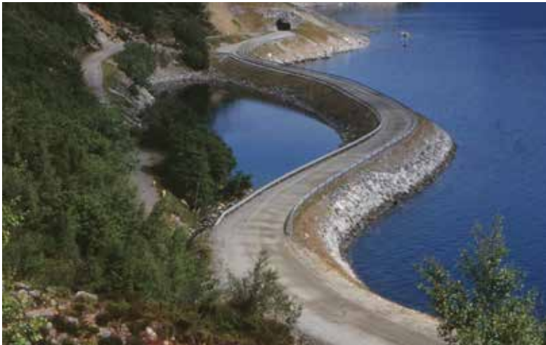
Figur 8.34 Ved å flytte vegen ut på en fylling i sjøen oppnår en å få stor avstand mellom vegen og den skredfarlige fjellsida. Breidefonn, fv.65, Hjørundfjorden, Møre og Romsdalen. Foto: Harald Norem
