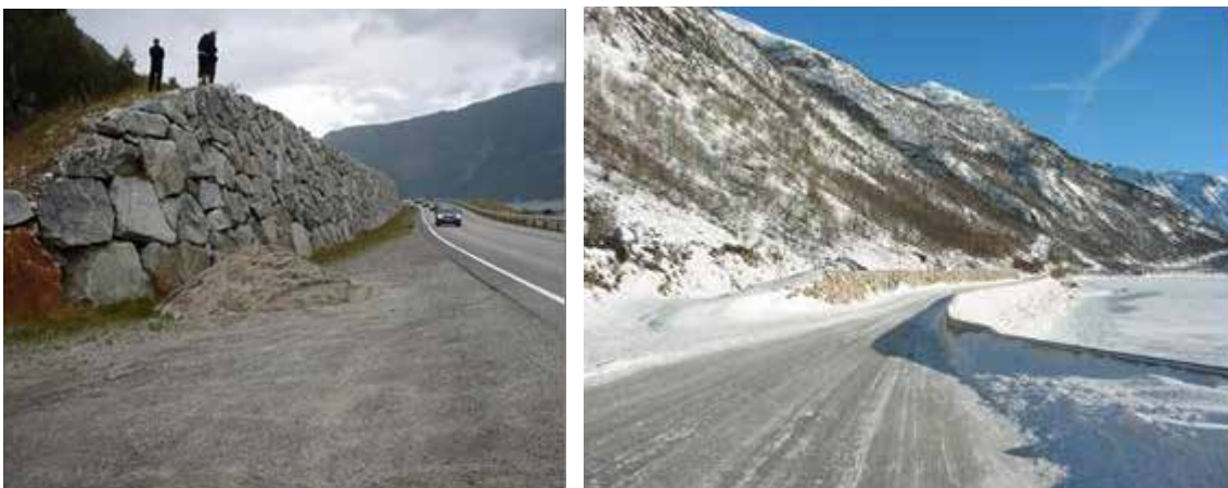
Figur 8.31 Eksempler på bruk av fangvoller for å løfte skredtrykket. Det venstre bildet er fra rv.7, Eidfjord, hvor vollen utelukkende er bygget for fonntrykket, da faste skredmasser sjelden når fram til vegen. Det høyre bildet er fra fv. 362, Sandvikskreda, Vinje hvor vollen fungerer både som en fangvoll mot de faste skredmassene og for å heve fonntrykket. Foto: H. Norem
