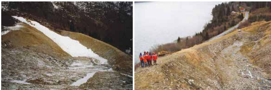
Figur 8.21 Eksempel på ledevoll for sikring mot snøskred og sørpeskred. Vollkrona er dessverre ikke bygget med jamn stigning i øvre delen av vollen, og på dette partiet har skred gått over vollen. Vinkelen mellom skredet og vegen er også for stor til at vollen gir en god sikringseffekt. rv. 13. Sandvika, Sogn og Fjordane. Foto: Harald Norem
