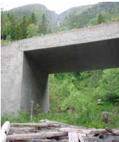
Figur 8.10 Eksempel på bru bygd som sikringstiltak mot skred. Bruløsningen er kombinert med geofonanlegg for å varsle trafikantene mot å bli utsatt for snøskydelen av skredet og mot eventuelle store skred. Fv 37, Bryneberget, Tinnsjøvegen, Telemark. Foto: H. Norem
