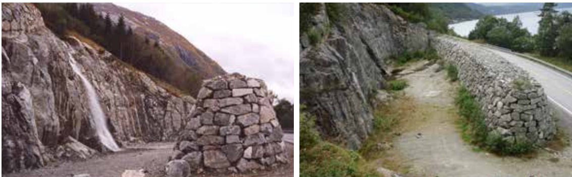
Figur 8.29 Foto av fangvoll med bratt tørrmur på begge sider, Rv. 7, Indre Rotagjelet, Hordaland. Foto: H. Norem
