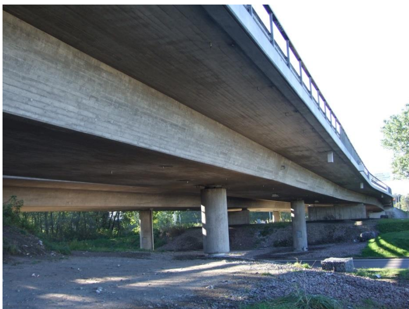
Figur 41B. Vägbro nr 14-884-3, Hjalmar Brantings väg.
