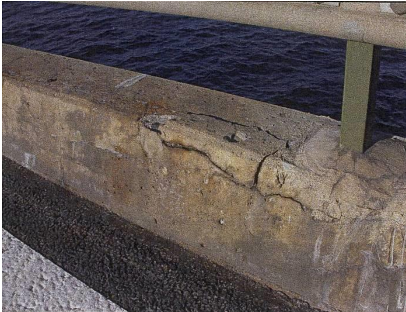
Figur 16B. Kantbalk Ölandsbron
