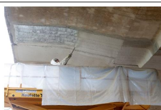
Figur 33. Plattorna täcktes med ett bruk.
