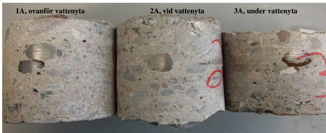
Figur 29B. Utseendet hos armeringen i uttagna betongkärnor
