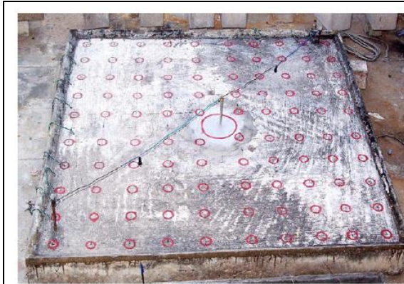
Figur 26. Betongblocket med armering och anod i mitten av blocket.
