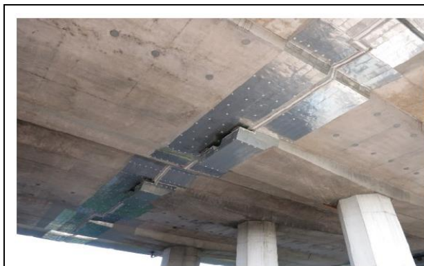
Figur 32. Monterade zinkplattor på betongen.
