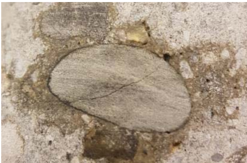
Figur 2 sprukket tilslag med tilsynelatende ASR rundt (dette bildet er av kjerne M6 som ikke ble sendt inn til tynnslip). Ligner ASR men revnen går undersliggt på tværs af bjergartensstruktur. Kan du se revner ud i pasta?
