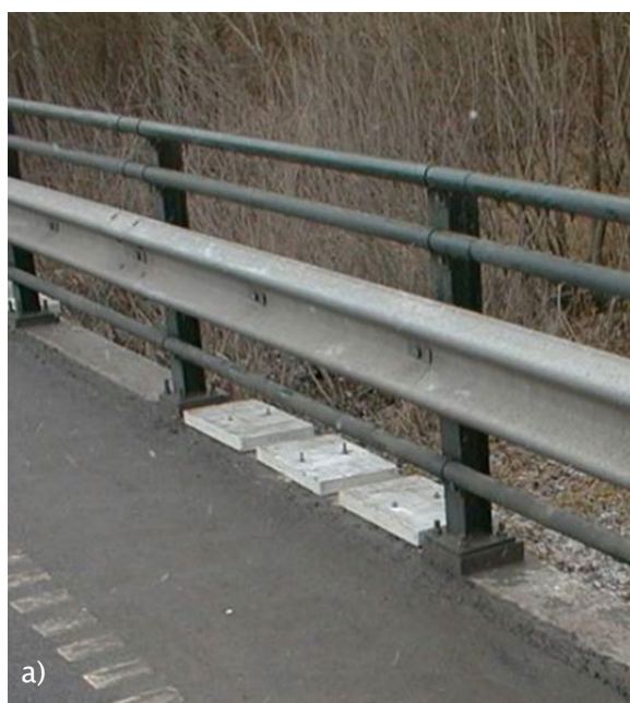
Figur 1 a) Plater montert på kantdrager, b) skisse av metallplate som ble festet til platene. Foto og skisse: Claus K. Larsen, Statens vegvesen.
