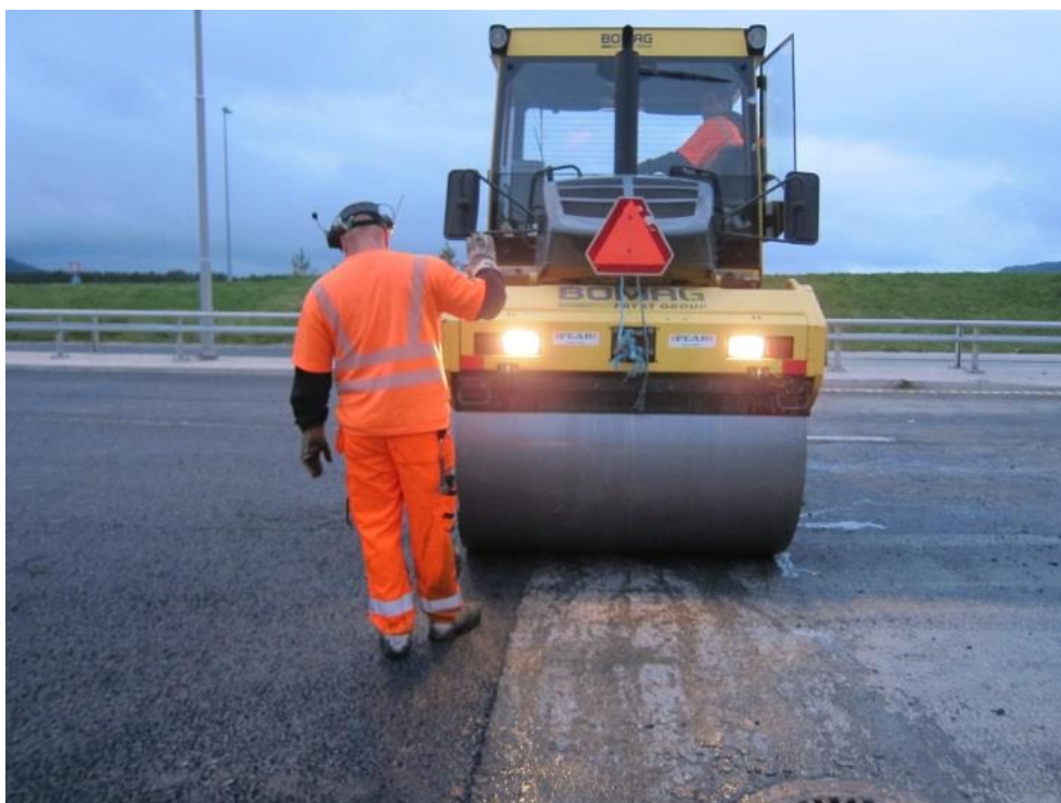
Figur 42 - Komprimering av tverrskjøt. Foto: Ragnhild Oksavik Lockertsen
