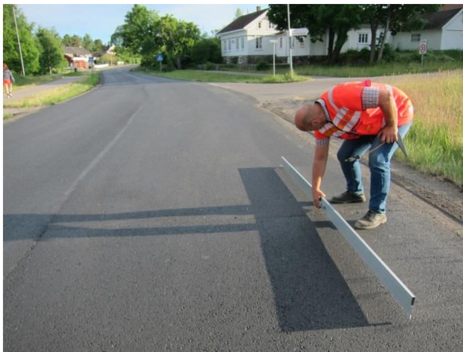
Figur 43 - Kontroll av tverrsjøt med 3 meter rettholt. Foto: Ragnhild Oksavik Lockertsen
