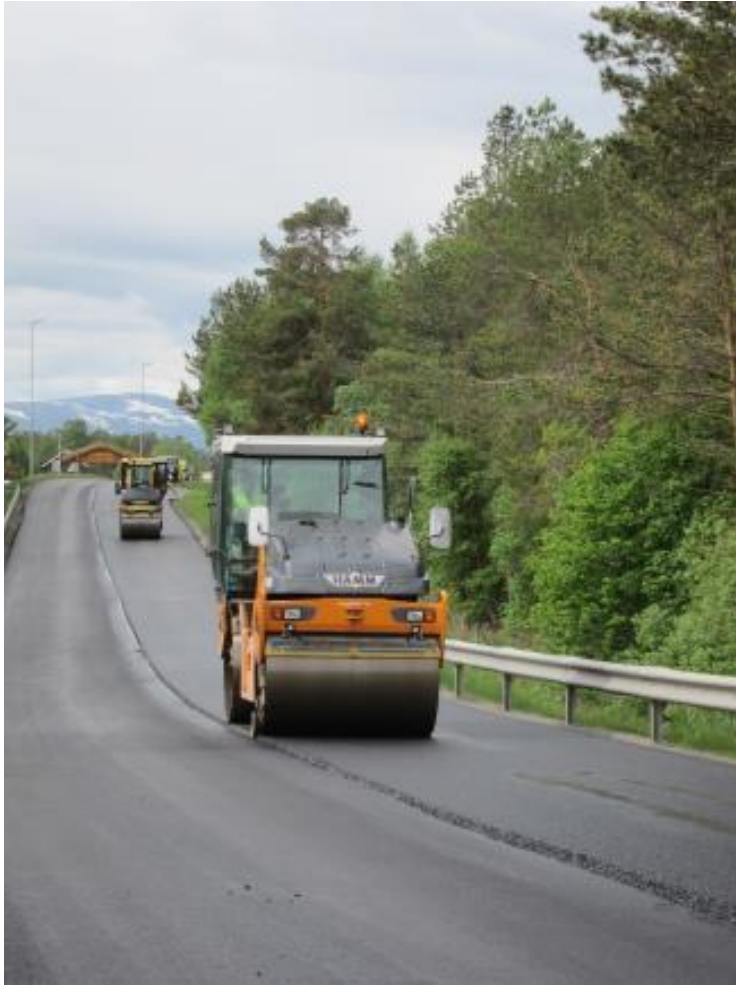
Figur 4 - Komprimering av nylagt asfaltdekke. Foto: Ragnhild Oksavik Lockertsen
