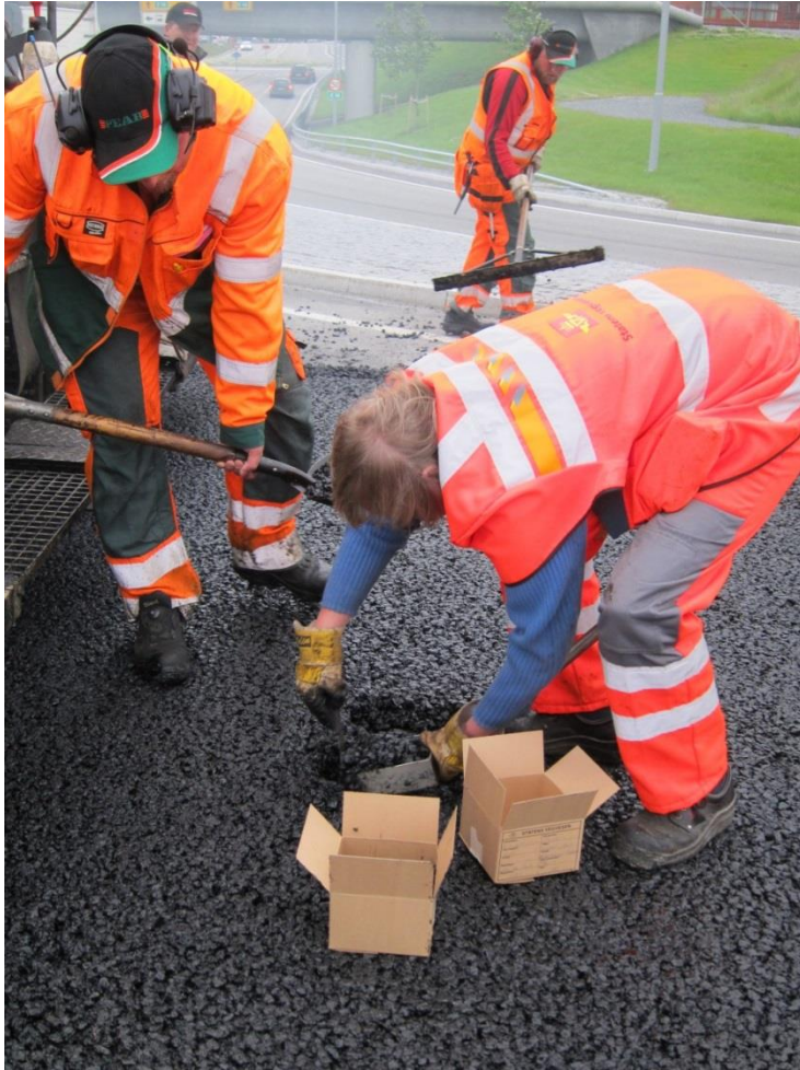
Figur 41 - Uttak av masseprøver. Foto: Ragnhild Oksavik Lockertsen
