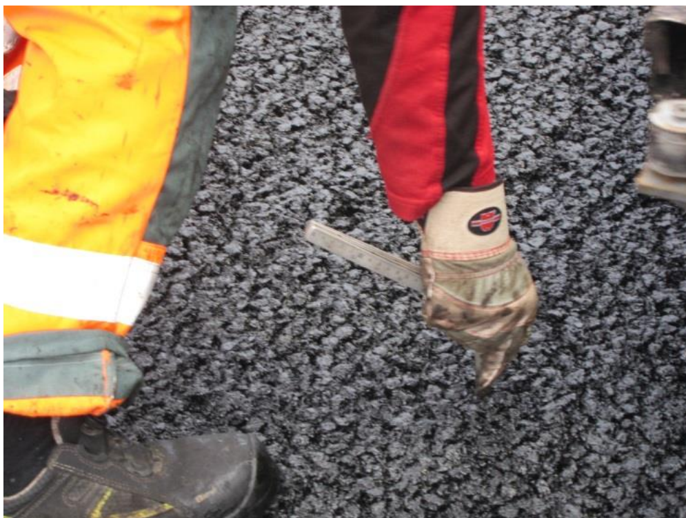
Figur 38 - Måling av dekketykkelse. Foto: Ragnhild Oksavik Lockertsen
