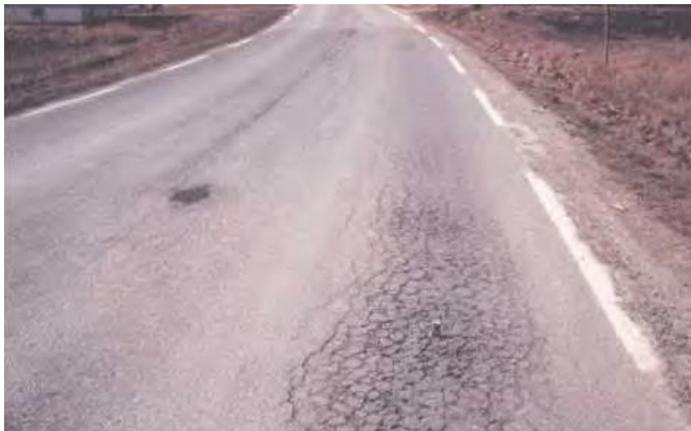
Figur 10 - Smårutet krakelering [11:36]
