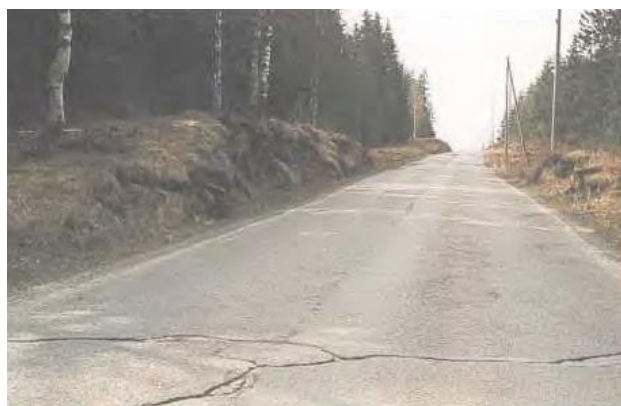
Figur 9 - Tversgående telesprekk [11:31]
