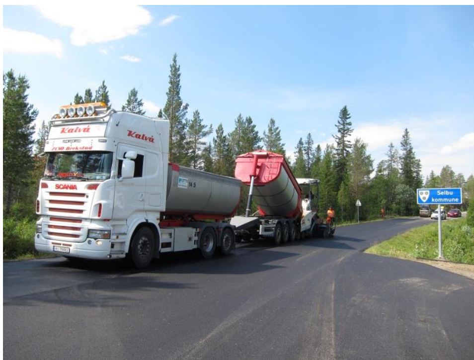
Figur 34 - Transport av asfalt. Foto: Ragnhild Oksavik Lockertsen
