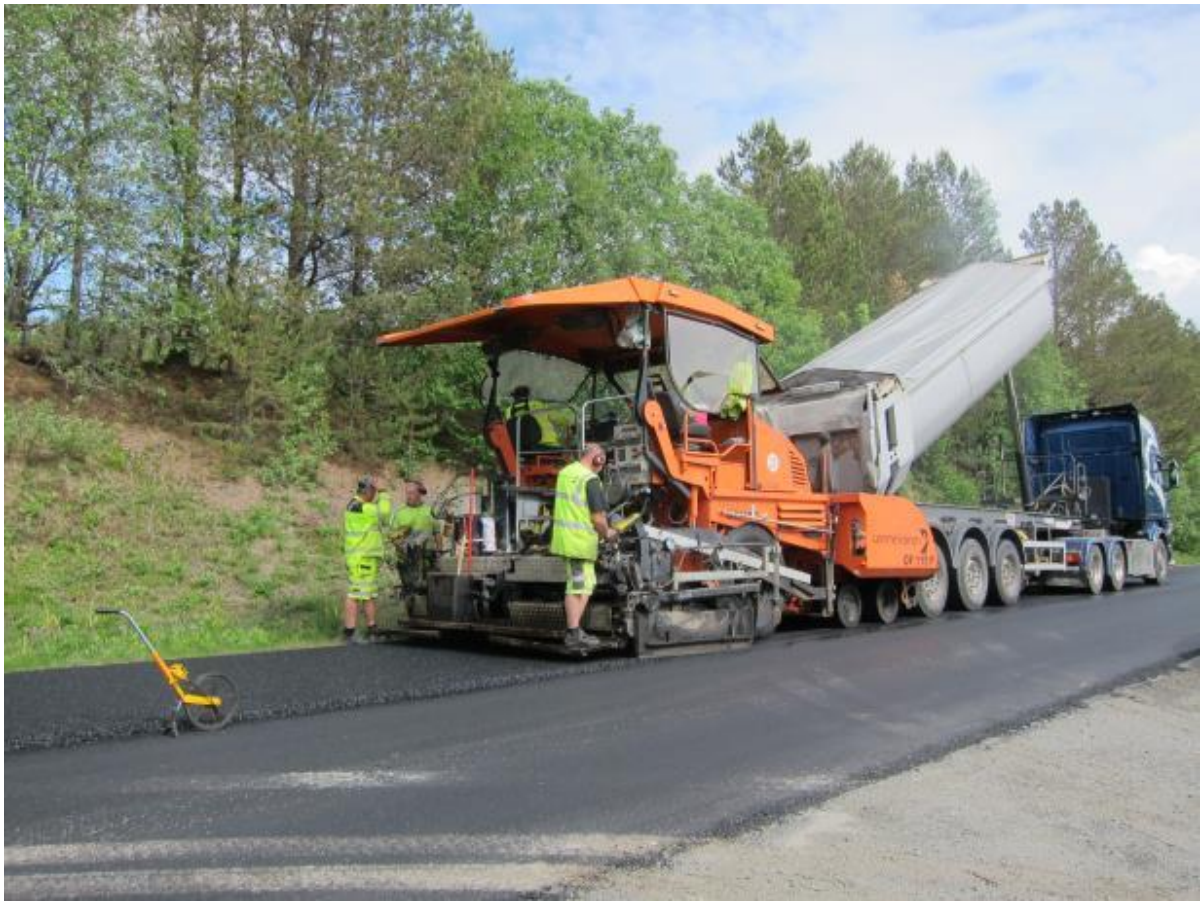
Figur 3 - Utlegging av asfalt. Foto: Ragnhild Oksavik Lockertsen
