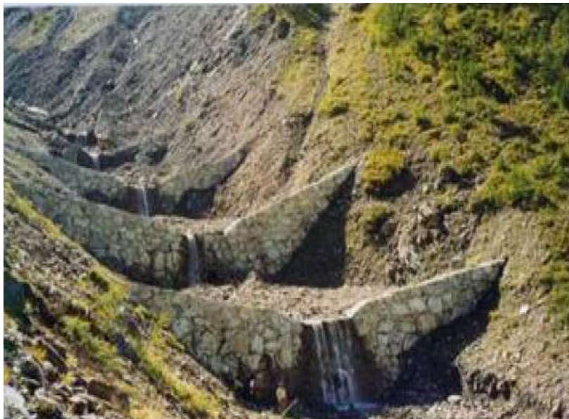
Figur 3.3: Lukkede kontrolldammer i funksjonell kjede (figur - IRASMOS, 2008).
