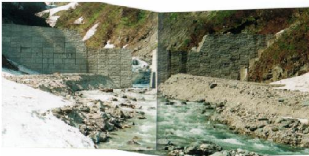
Figur 5.12: Spaltdam etter flomskred, viser erosjonsproblemet. Foto: Mizuyama (2008)
