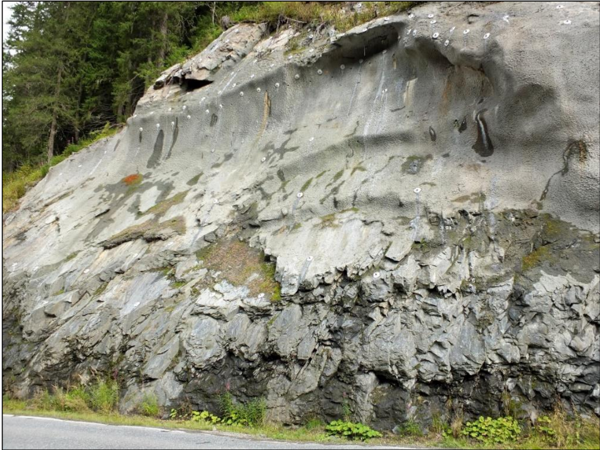
Figur 1.4 Utrasingsområdet etter sikring med boltar og sprøytebetong (Foto: Gunne Håland).
