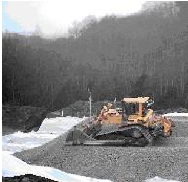
Figur 2.6: Utlegging av skumglass
