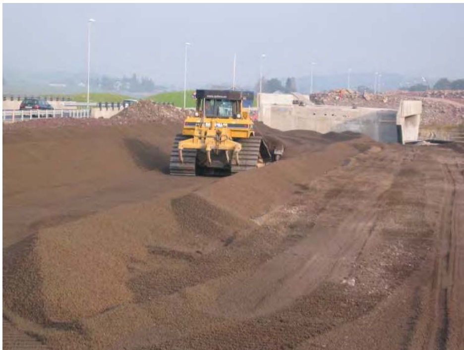
Figur 2.2: Utlegging av lettklinkerfylling
