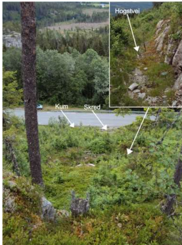
Figur 8.20 Utsyn utover skredområdet med plasseringen av fv. 33, hogstvei og kum i forhold til skredet.
