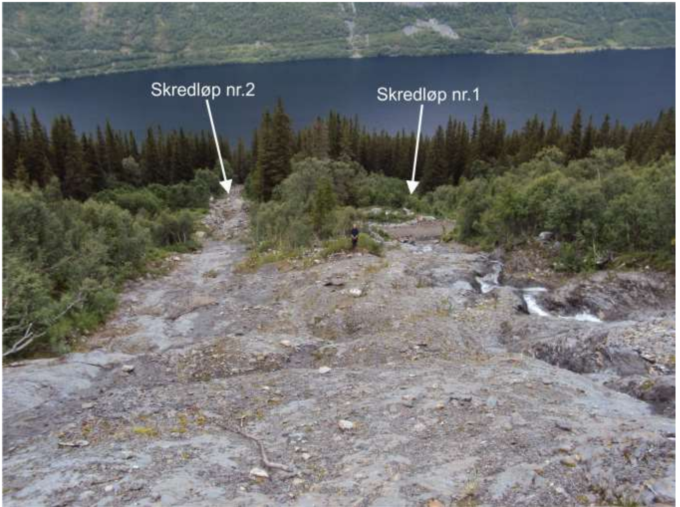
Figur 8.50 Oversiktsbilde som viser hvor skredløpet splittes i et østlig skredløp nr. 1 og et vestlig skredløp nr. 2 . 30 m nedenfor splittepunktet krysser skredløpene skogsbilvei 2 (person mellom skredløpene er skala).
