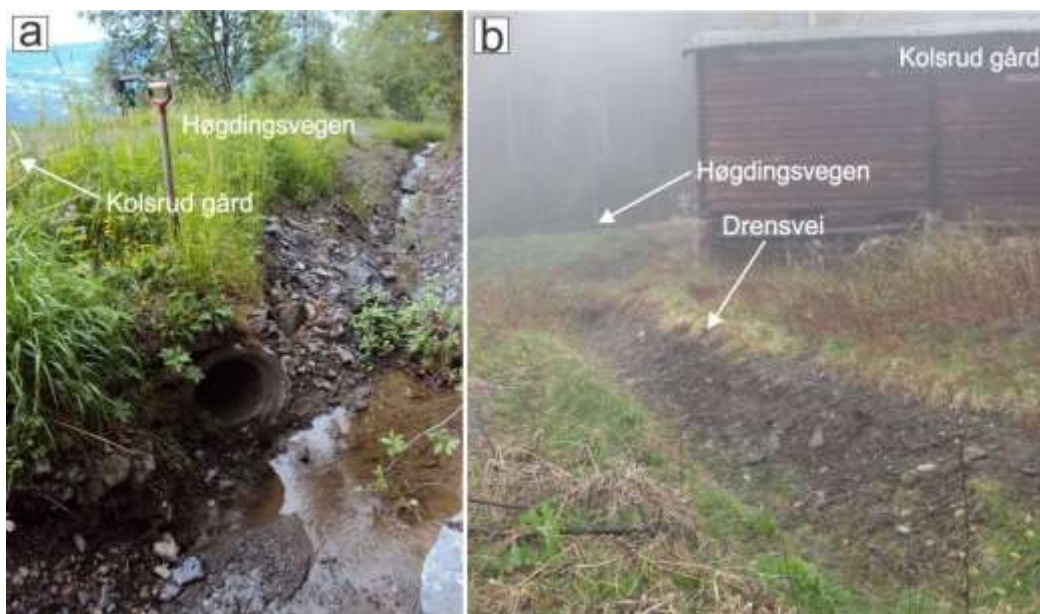
Figur 8.37 Detaljer i området ovenfor skredet. a) Ovenfor Kolsrud gård er Høgdingsvegen. Vann dreneres langs med veien i en grøft, men også under veien i en stikkrenne som frakter vannet videre ut på jordet nedenfor gården (se figur over for nærmere lokasjon).
