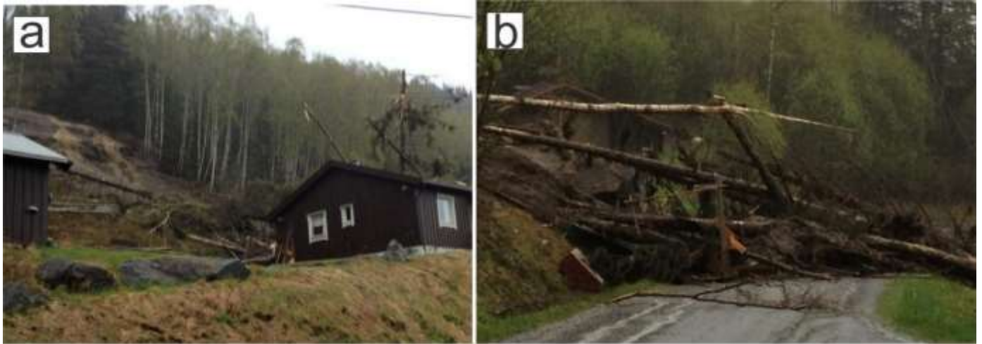
Figur 8.21 a) Det øverste og første av de fire husene som ble truffet av jordskredet i Aurdal med nr. 99/20 og b) noe av avsetningene på veien nedenfor dette huset (oa.no, 2013, pd.no, 2013).
