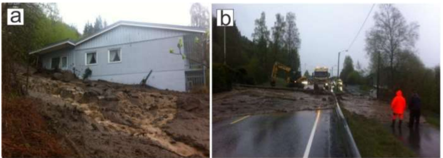
Figur 8.22 a) Det nederste og siste av de fire husene som ble truffet av jordskredet i Aurdal med nr. 99/36 og b) E16 rett nedenfor dette huset. Her består skredet for det meste av vann og finstoff (Valdres, 2013a).
