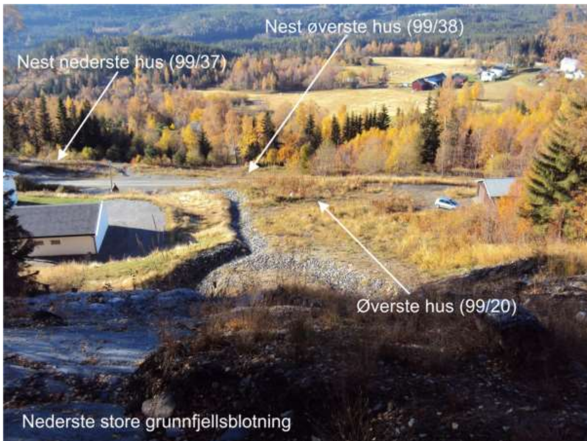
Figur 8.36 Utsyn utover nederste del av skredet fra den nedre store grunnfjellsblotning. De tre husene 99/20, 99/37 og 99/38 er fjernet og det er opprettet nytt dreneringsmønster fra nederste store grunnfjellsblotning og ned til E16.
