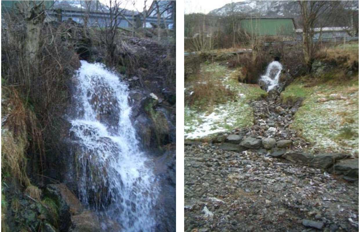
Figur 6-10 Bekkeutløp nedstrøms kommunal veg. Bildet til høyre viser erosjonsskadene pådratt etter flommen
