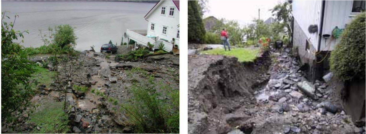
Figur 6-7 Utvasking av masse og undergraving av bolighus
