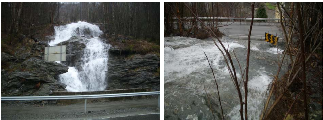
Figur 6-8 Sikring mot vann- og steinsprut fra Grautåbekken ved hjelp av trafikkskilt
