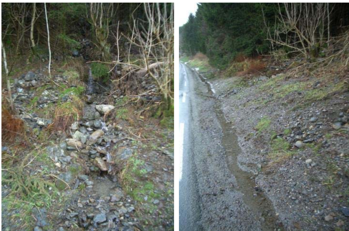
Figur 6-18 Bekkeløp oppstrøms riksveg. Bildet til høyre viser grøft langs riksveg
