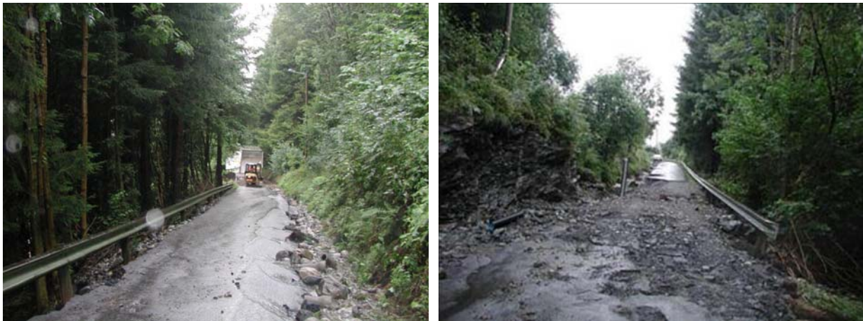
Figur 6-6 Sandsvegen ødelagt av flom (Skaar, 2005)
