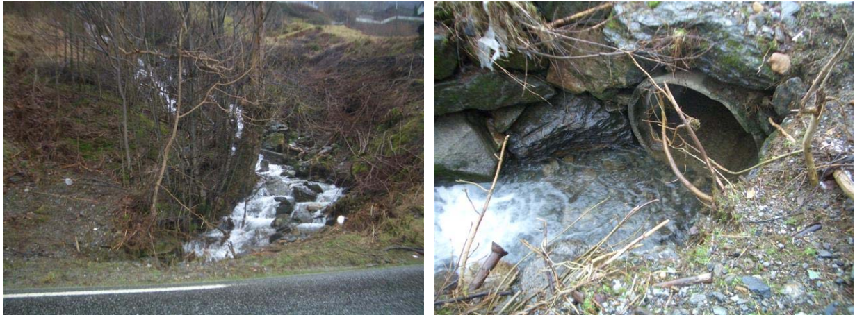
Figur 6-15 Bekkeløp og innløp for stikkrenne under riksveg
