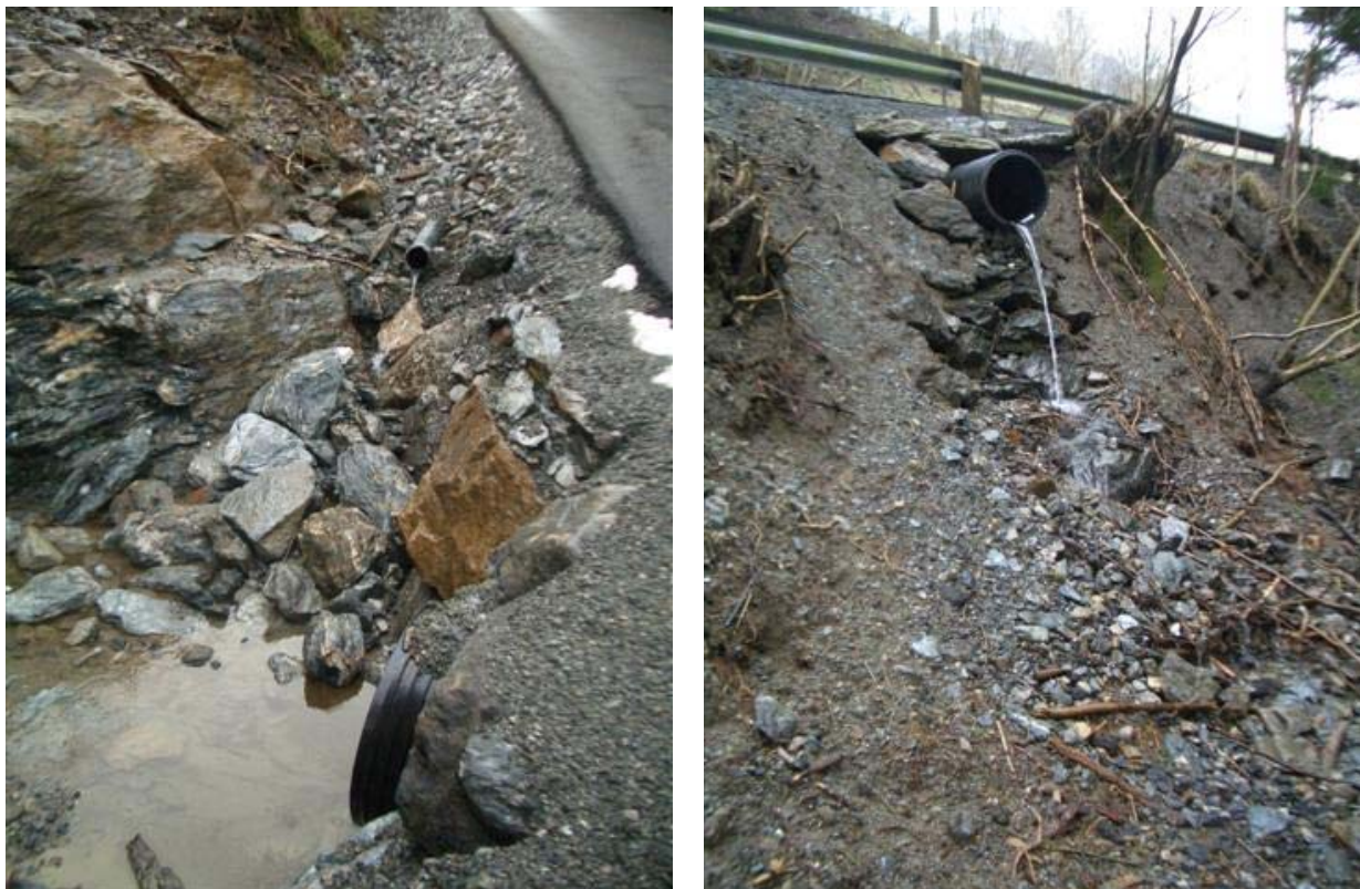
Figur 6-17 Innløp og utløp for stikkrenne på kommunal veg
