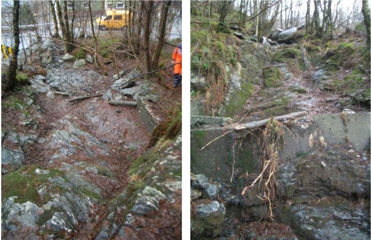
Figur 6-24 Det "gamle" bekkeleie ligger brakk
