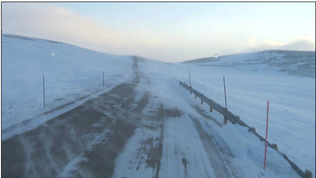
Figur 34 Fonndannelse med W-skinnekkverk
