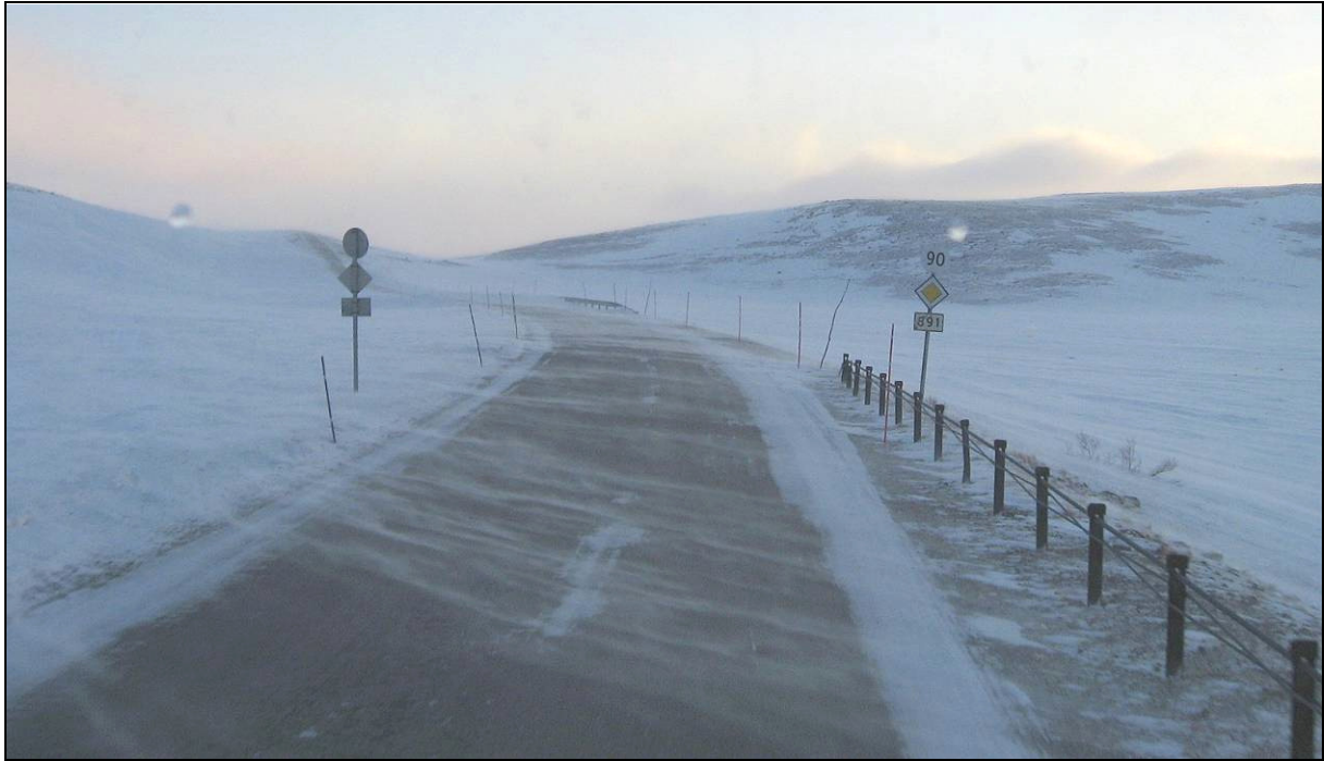
Figur 33 Fonndannelse med kabelrekkverk
