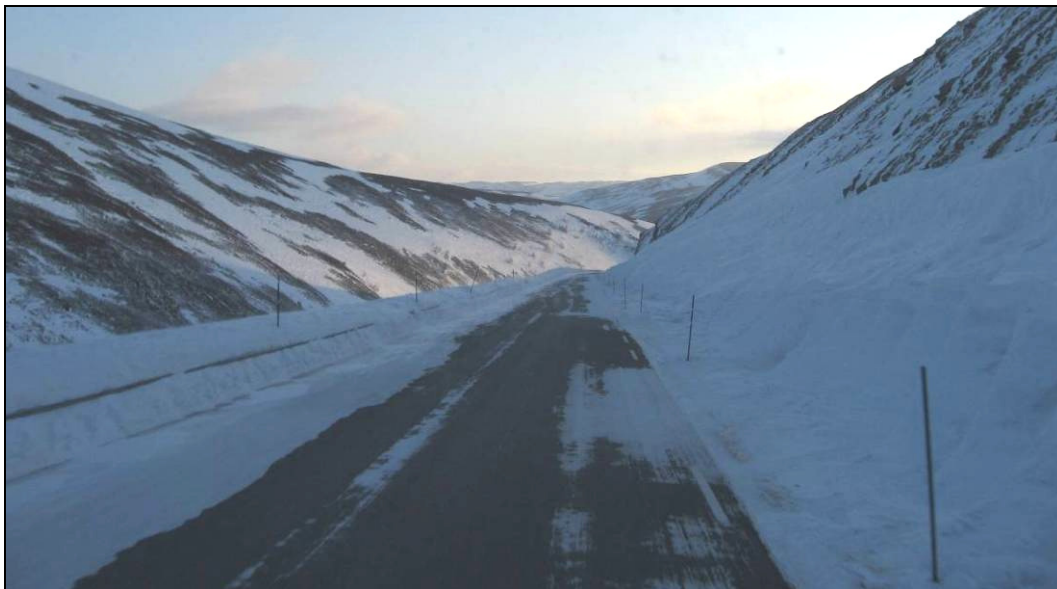
Figur 19 Halvskjæring i Annelvdalen
