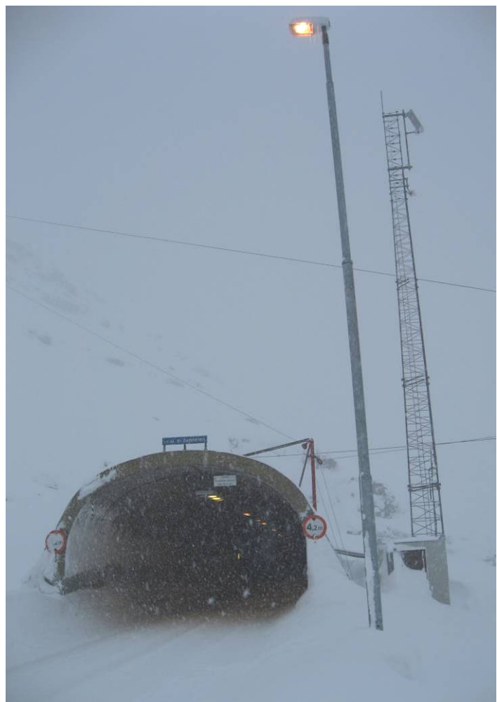
Figur 5 Tunnelportalen ved Peparsteinen
