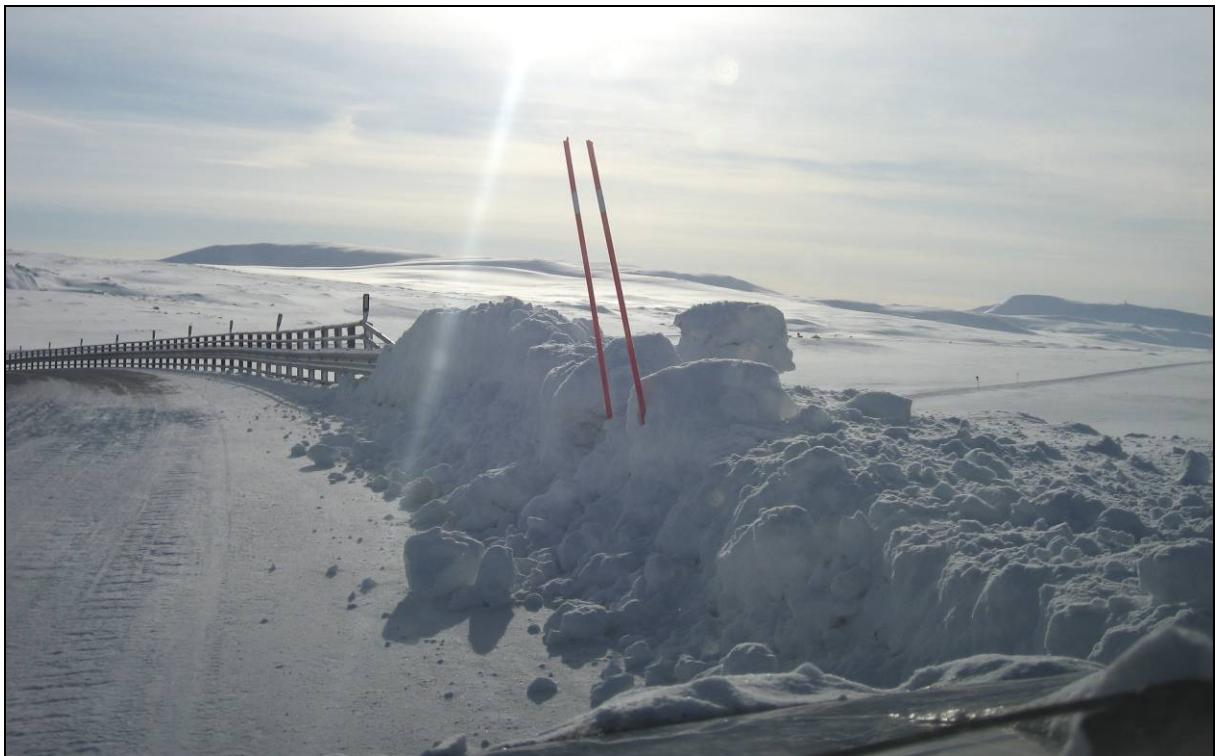
Figur 15 Rekkverksavslutning ved bro
