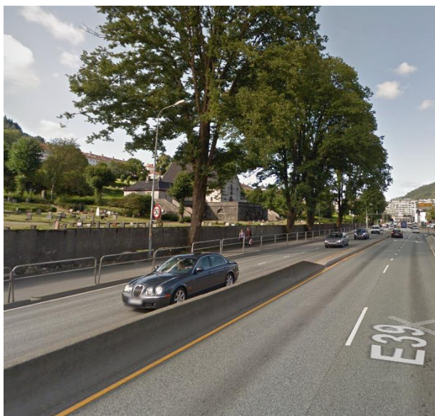
Figur 36: Eksisterende trerekke langs vestsida av Fjøsangerveien som må fjernast (38)
