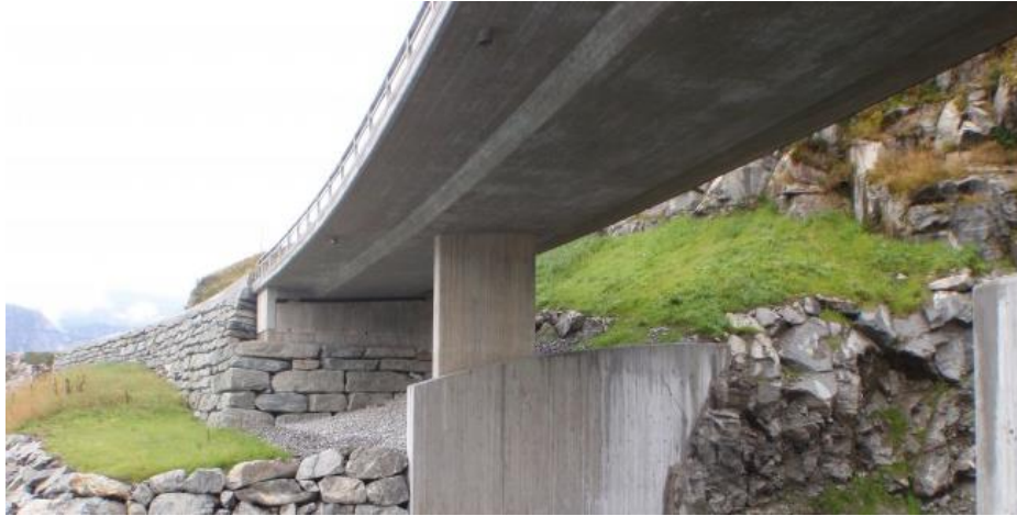
Figur 22: Storagjelet bru, køyrebru i Hardanger, betongplatebru (35)
