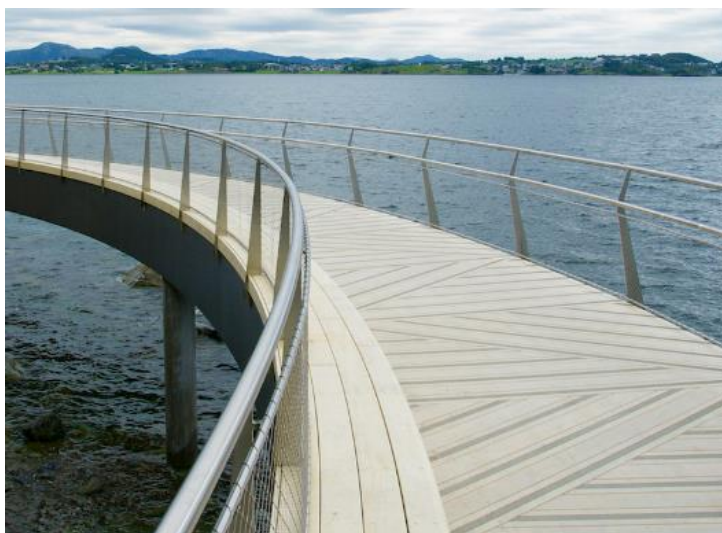
Figur 30: Rekkverk på Håhammaren bru i Stavanger (41)
