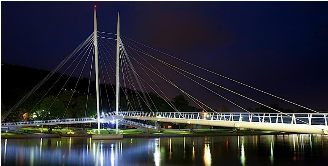
Figur 21: Ypsilon, gang- og sykkelbru i Drammen, Skråstagbru (33)
