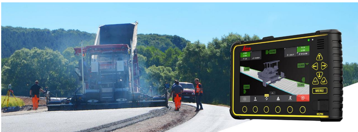
Figur 6. Asfaltutlegger og arbeidere, Leica iCON pave asphalt, 2018, av Leica
