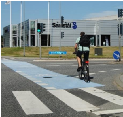
Figur 3.2.5.5: Farget oppmerking av sykkel felt i krysset
