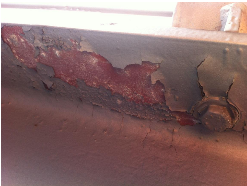
Figur 8. Nedbrytning av belegg i undergurt. Trolig lav filmtykkelse.
