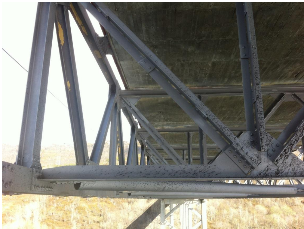
Figur 11. Belegg tilgriset med bitumen ved østre tårn etter asfaltering på brua.
