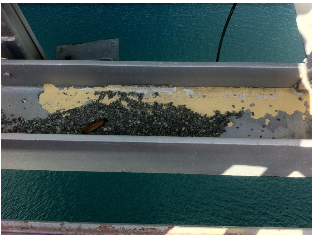
Figur 10. Avflassing av toppstrøk i undergurt.
