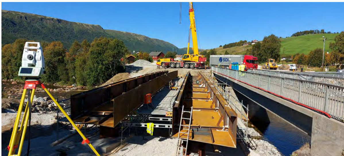
Figur 16.: Montasje av stålbjelker
