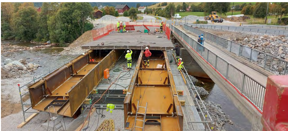
Figur 15.: Montasje av Decksegment
