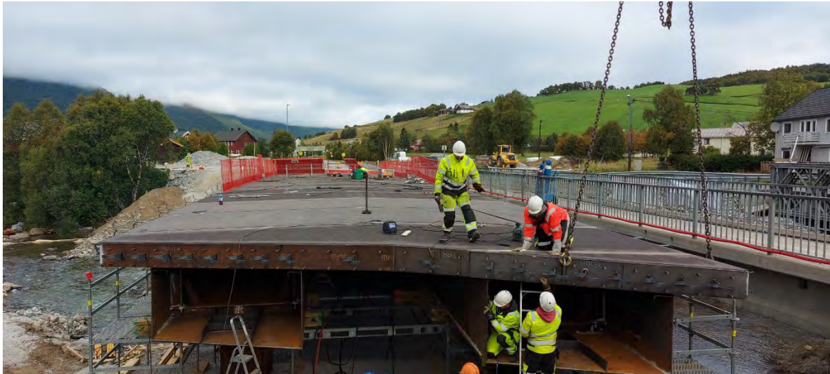
Figur 17.: Montasje av Decksegment
