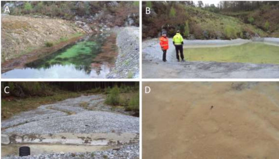
Figur 23: Reinseanlegget for deponi M17. A: Øvre reinsebasseng og B: nedre reinsebasseng. C: Anlagt meander (nedre reinsebasseng i framgrunnen) bekken går i kalkstein. D: Grumsete vatn med levande rumpetroll ved lokalitet M17-3.
