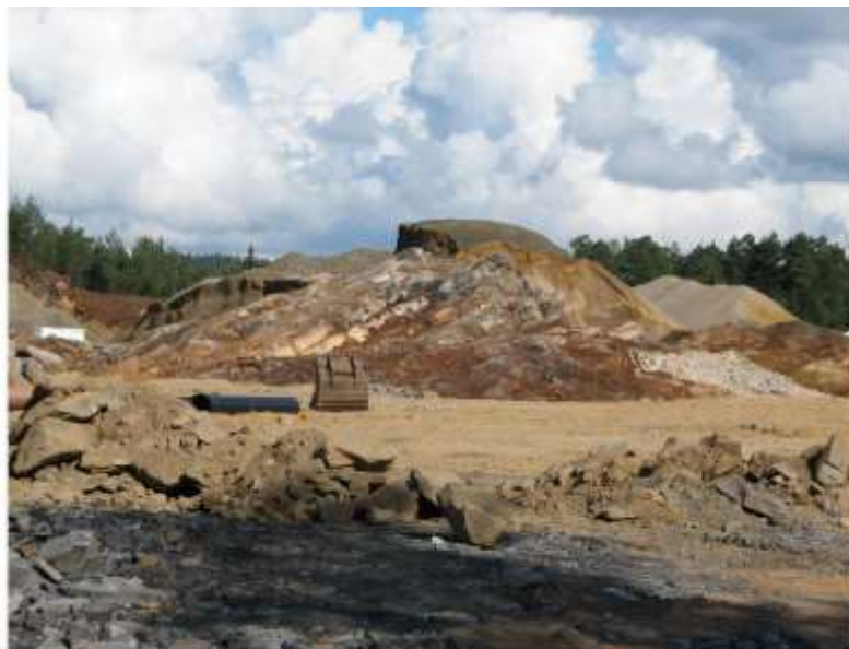
Figur 2: Sprenging for etablering av industriområde på Storemyr, rett nord for Lillesand gav ekstrem grad av fragmentering med masse reaktivt jarosittførande partiklar. Avrenning til Moelva førte til akutt fiskedød. Foto: NIVA 2006.
