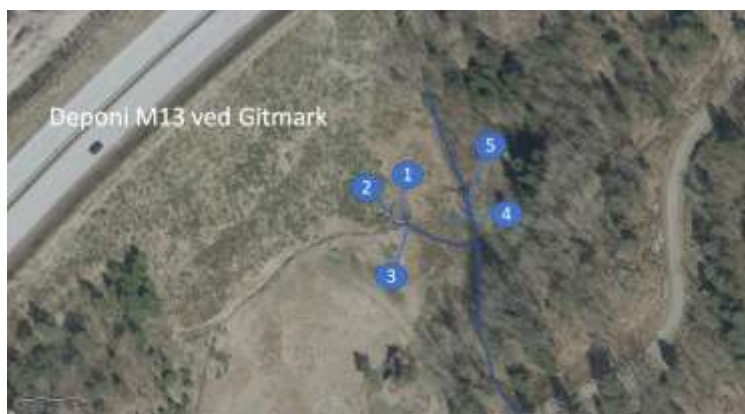
Figur 14: Deponi M13 var reservert for «rein stein eller lavsulfidstein» basert på hydrogenperoksidmetoden, men fekk raskt sur avrenning. Git-1 er vatn som renner rett ut av deponiet. Git-2 er ganske nøytralt ionefattig vatn frå veg frå eit røyr og som blandar seg med Git-1 til vatn Git-3 med aluminiumsutfellingar. Git-4 blei samla frå ein liten dam i vegetert område og Git-5 er frå ein liten bekk. Alt vatn samlar seg nedstrøms i Bådestøbekken og renner ut i indre Kaldvellfjorden ved Kilen.
