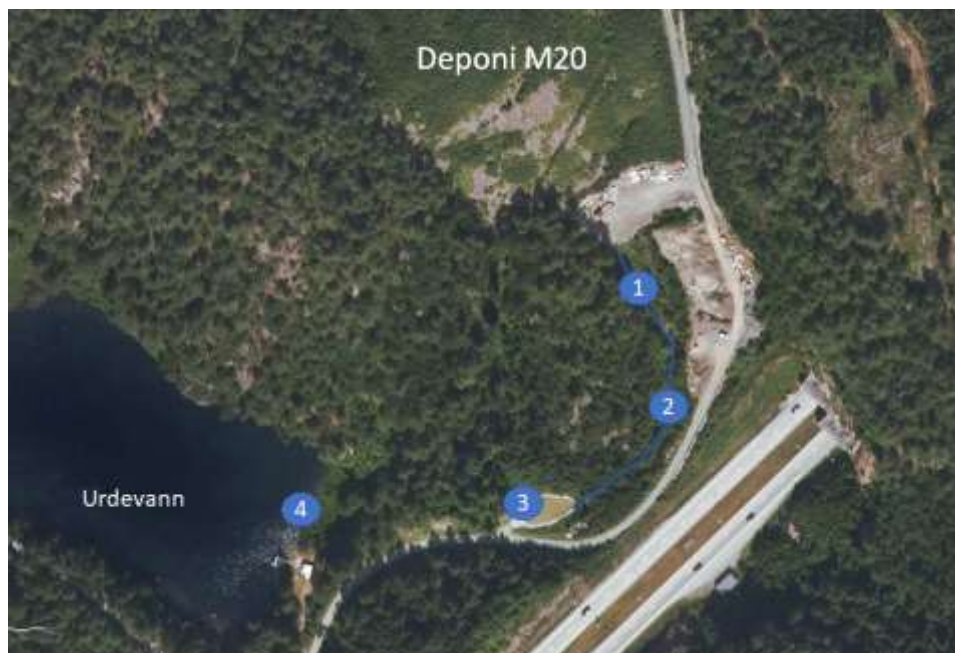
Figur 27: Deponi M20 i Gale-Raundalen med prøvetakingspunkt for vatn og M20-1 til M20-4. Det var kraftig utfelling av Al-rikt materiale mellom deponiet og reinsbassenget (3).
