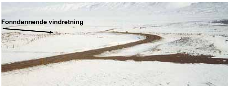
Figur 6-3. Eksempler på veger hvor lokale forhold fører til at det er nødvendig å bruke snøfres over korte strekninger for å holde vegene åpne. (Foto: Harald Norem)
