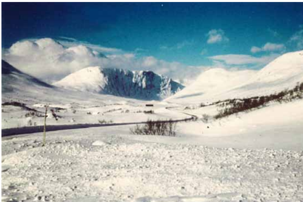
Figur 4-4. Riksveg 15, Strynefjellsvegen, vest for Hamseviki. Vindstyrkene er større på ryggen der bildet er tatt og i utkurven ved brøytestasjonen enn i innkurven hvor det vokser skog. (Foto: Harald Norem)
