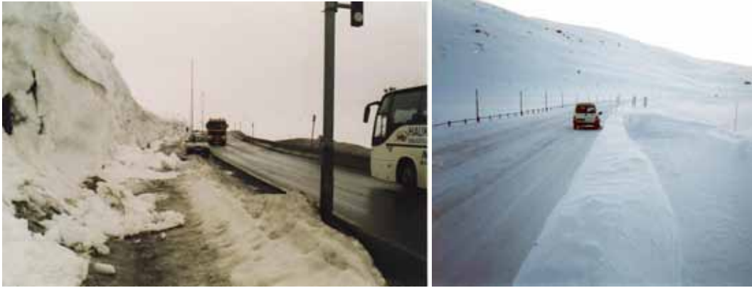
Figur 5-2. Eksempler på fresfelt under vinterforhold. Venstre: Et fresfelt under høy fjellskjæring på Haukeliffjellet. Høyre: Et fresfelt på Strynefjellesvegen, hvor brøytemannpersonalet har valgt å ikke fjerne brøytekant mellom vegen og fresfeltet. (Foto: Skuli Thordarson).
