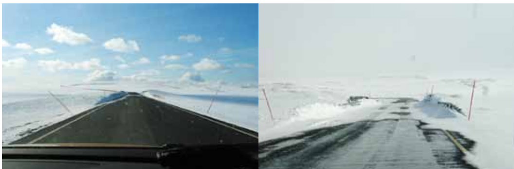
Figur 6-1. Rv. 890 Auster Tana-Gednje hvor vegen krysser Gednjevannet. Mot vannet er det montert rekkverk. På den øvrige strekningen av vegen er det minimalt med behov for brøyting under uvær, mens det på strekningen med rekkverk samler seg betydelige snømengder på vegen. (Foto Yngve Øverli)
