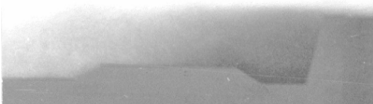
Fjellskjæring, Helling 5:1, 3 m bred grøft
