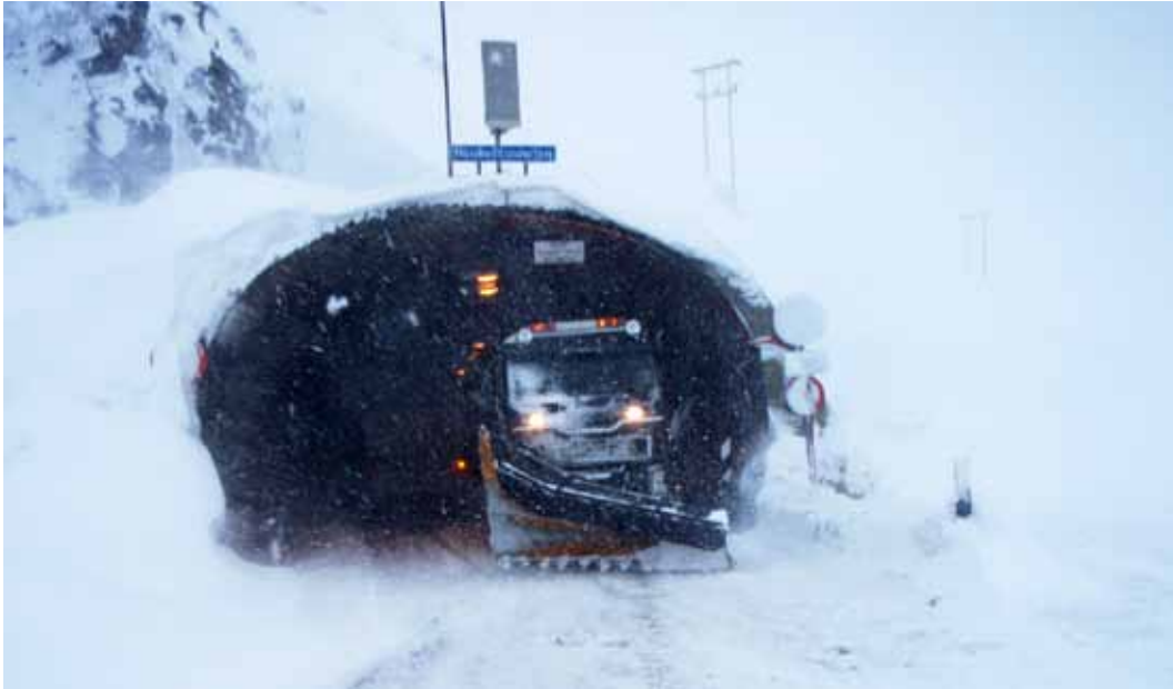
Figur 8-1. På Haukelifjell er det fire tunneler som er tilrettelagt for kolonneoppstilling. Ofte er været dårlig kun på den ene siden av fjellet - da er det effektivt å kunne kjøre kolonner mellom to tunneler kun på den vanskelige siden av fjellet. (Foto: Harald Norem)
