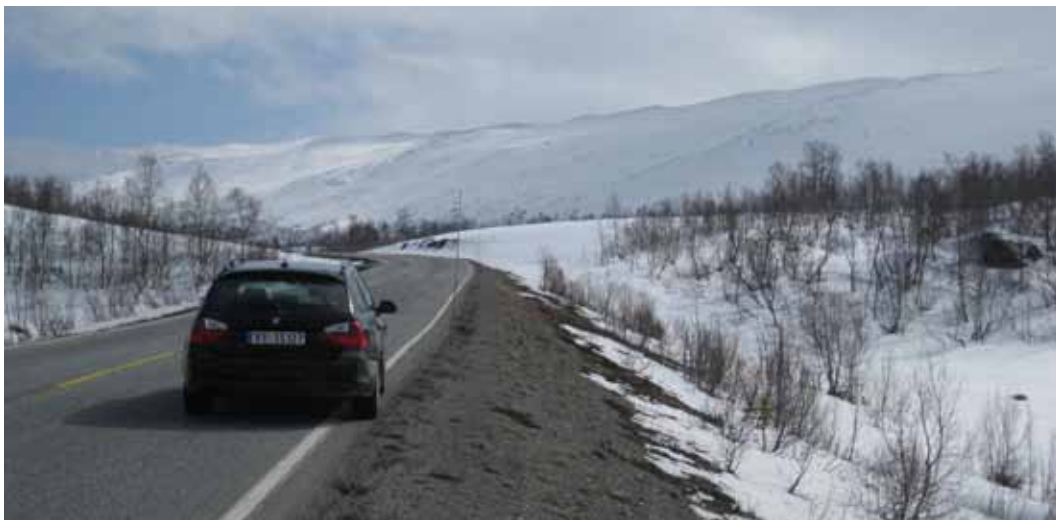
Figur 5-13. Et eksempel på overgangssone mellom skjæring og fylling, der hvor mye snø driver inn på vegen. Bildet er tatt ved Grotli på rv. 15, Strynefjellsvegen, (Foto: Skuli Thordarson).
