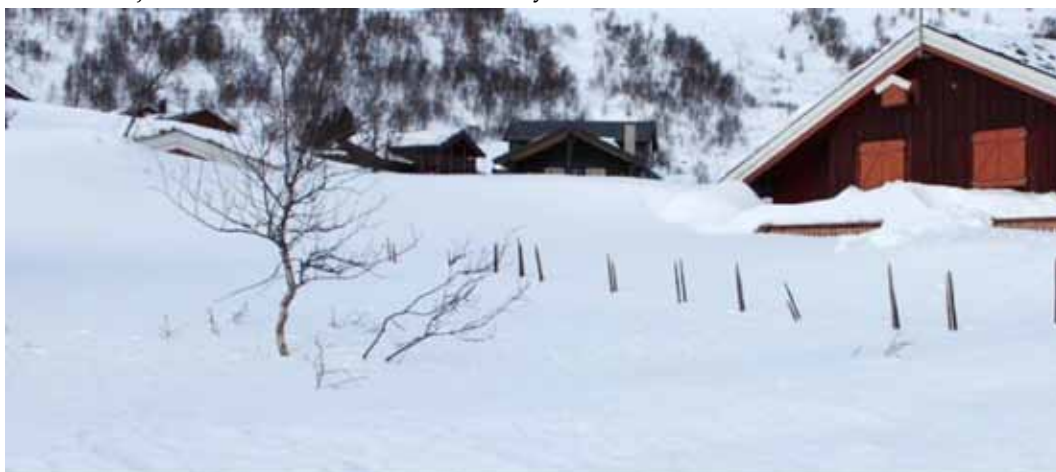
Figur 7-9. Fonndannelse i hyttefelt ved Nystuen på Filefjell. Selv på en relativt snøfattig vinter med forholdsvis lite vind har kombinasjonen av bygninger og rekkverk ført til store fonner tett inn til husene. (Foto: Skuli Thordarson, 17.03.2011)
