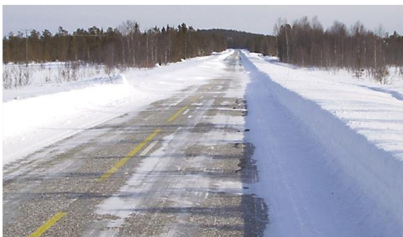
Figur 6-4. Eksempel på veg som passerer et myrområde med drivsnøproblemer og er et område med glissen skog som samler snø på vegen. (Foto: Lars Bergstrøm, Roadex 2001)
