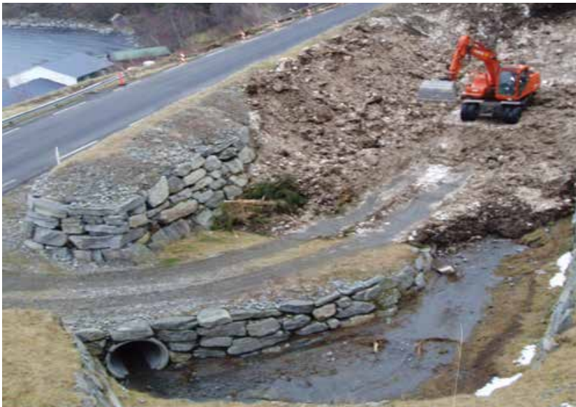
Figur 6.32 Foto av fangvoll og sedimentasjonsbasseng for sikring mot snøskred, sørpeskred og flomskred. Fotoet viser adkomstveg og innløpet for dreneringen. Denne ligger beskyttet og er åpen selv etter at det store skredet har fylt igjen sedimentasjonsbassengget. Alternativ drensveg er i dette tilfellet lagt mellom vollen og veggen. E39 Festøy-Ørsta.
