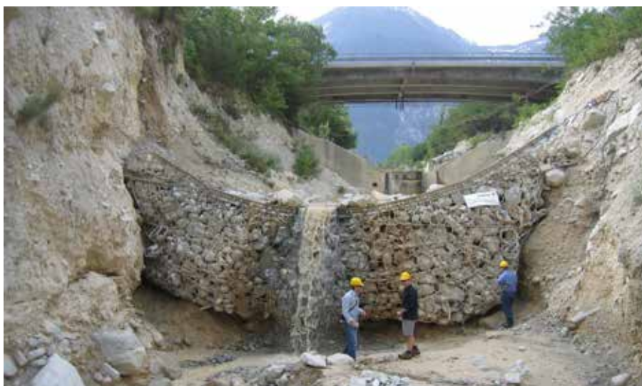
Fig. 6.9 Eksempel på bruk av fangnett for etablering av en lukket kontrolldam. Foto: Geobrugg AG
