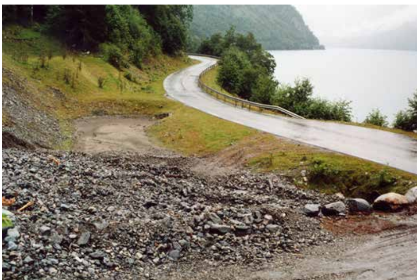
Figur 6.31 Foto av sedimentasjonsbasseng hvor vegen representerer fangvollen og hvor det er bygget alternativ drensveg 30 m til side for hovedløpet. Foto: Harald Norem
