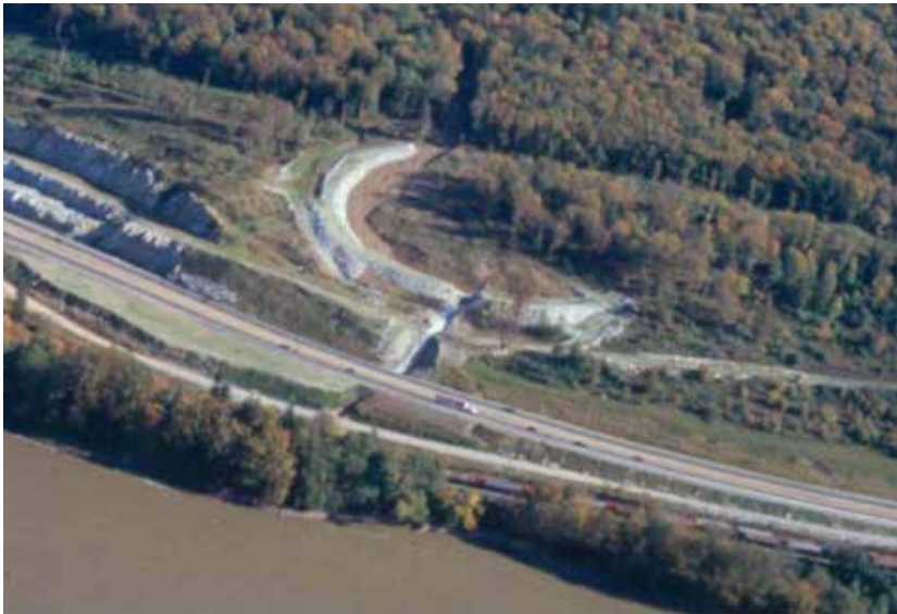
Figur 6.29 Eksempel på en ledevoll/fangvoll og sedimentasjonsbasseng fra Chilliwack, B.C., Canada. Flomvannet og de finere materialene føres fram til kulverten for vegen gjennom en åpen kontrolldam og utsprengt flomløp. http://step.ipgp.fr/images/e/e3/09_02_Debris_Flow_Mitigation.pdf
