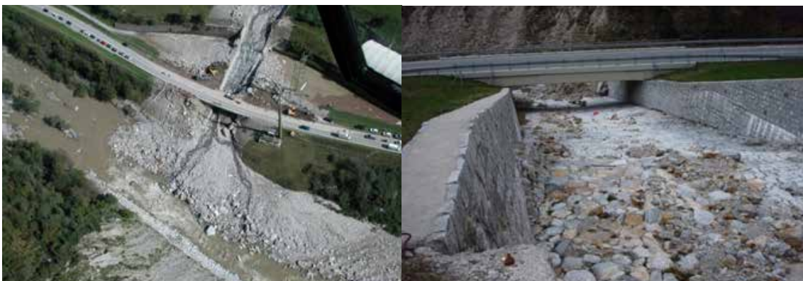
Figur 6.19 Bygging av bru og ledemurer for å styre skredmassene under veien, Ponte Rossa, Biasca, Sveits, Foto: Giorgio Valenti, Canton Ticino (venstre) og Harald Norem (høyre)
