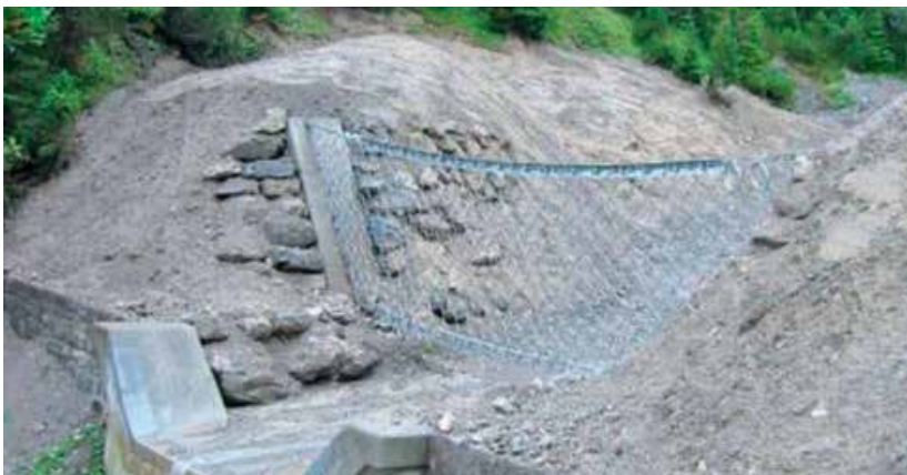
Figur 6.27 Eksempel på bruk av fleksibelt nett i en åpen kontrolldam. (Foto: Geobruigg AG)
