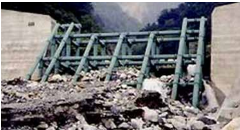
Figur 6.26 Figur av rammekonstruksjon brukt som gitter i en åpen kontrolldam. Fuji River Project. Fujikawa River Basin Sabo Office. http://www.ktr.mlit.go.jp/fujikawa/english/project/index.html
