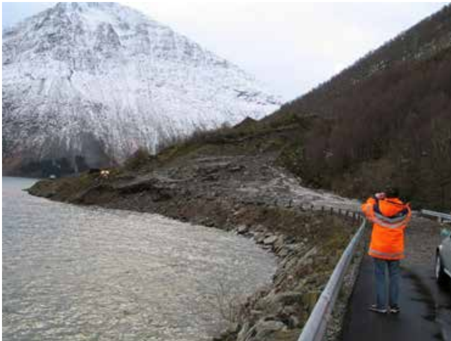
Figur 2.6 Foto fra Fv 40, Møre og Romsdal. Skredet ble utløst i november 2004 som et sørpeskred, og ved vegen besto skredmassene av mer enn 50 % med eroderte jordmasser. Foto Harald Norem
