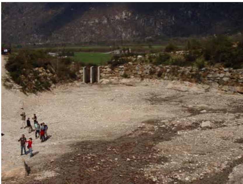
Figur 6.28 Eksempel på kombinasjon av sedimentasjonsbasseng og åpen kontrolldam. Biasca, Sveits. Foto: Harald Norem
