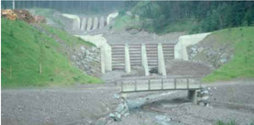
Figur 6.24 Eksempel på to typer åpne kontrolldammer. Lienz, Østerrike. http://step.ipgp.fr/images/e/e3/09_02_Debris_Flow_Mitigation.pdf
