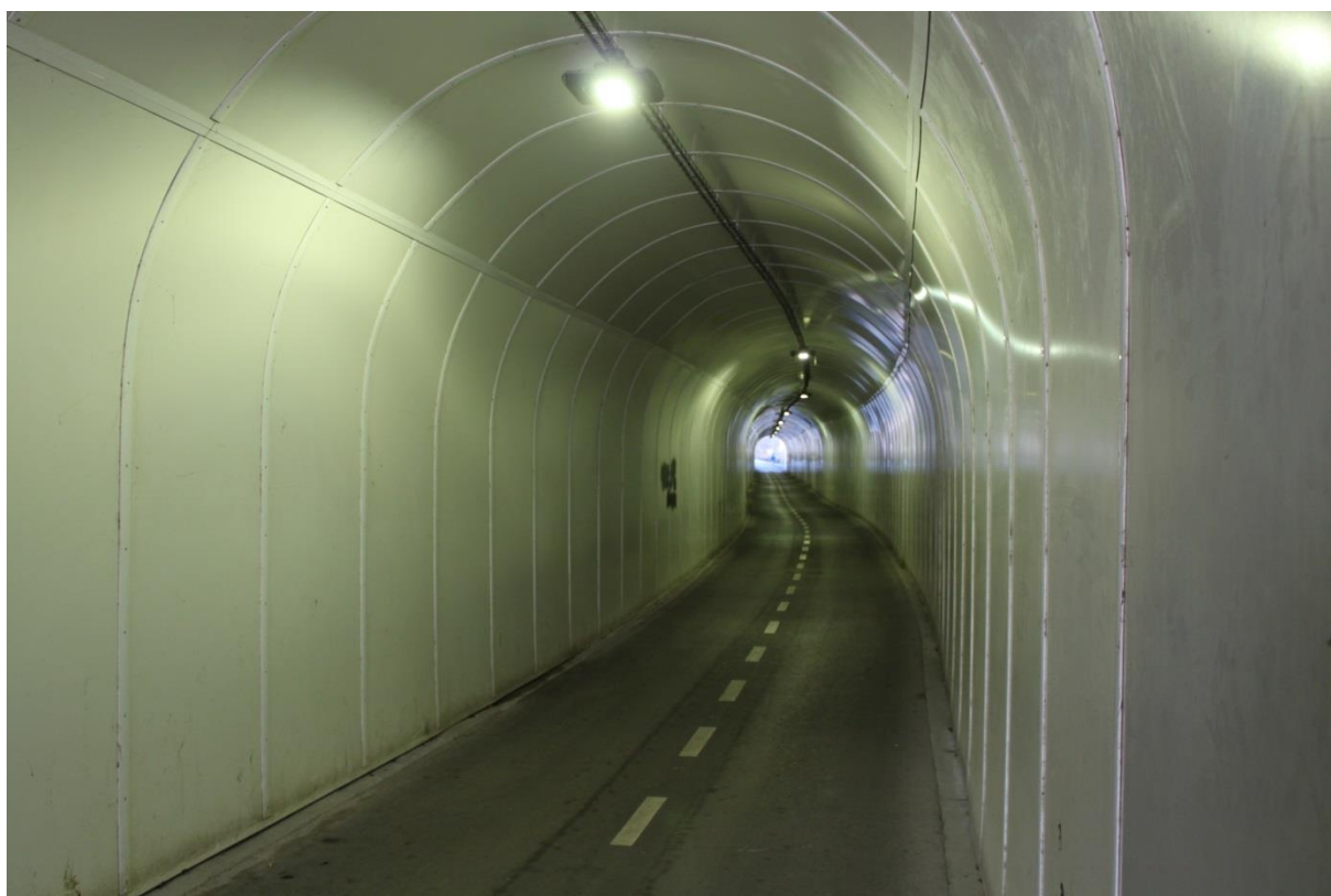
Figur 21: Jernbanetunnel som er bygget om til sykkel tunnel
