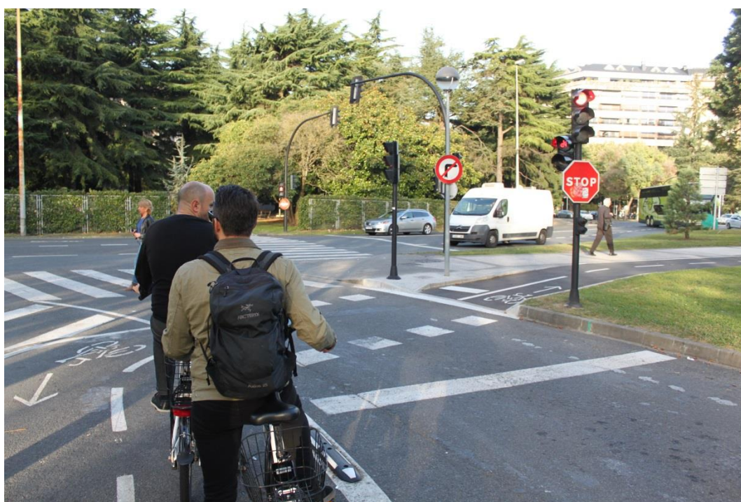
Figur 45: Sykkelveg gjennom rundkjøring med lysregulert kryssing for syklister. Dette er en spesiell løsning der syklende ledes sentralt gjennom rundkjøringen på 2 vegs sykkelveg, adskilt kjørebanelen (sentraløyen er til venstre i bildet).
