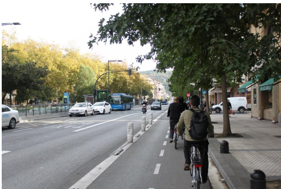
Figur 37: Sidestilt sykkeltilbud adskilt fra kjørebanelen med plastpulleter.
