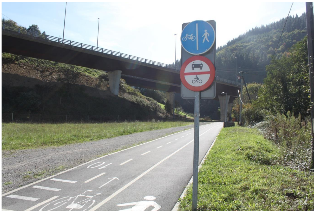
Figur 27: Skilting og oppmerking ned mot kulvert under hovedvegen, med anbefalt hastighet.
