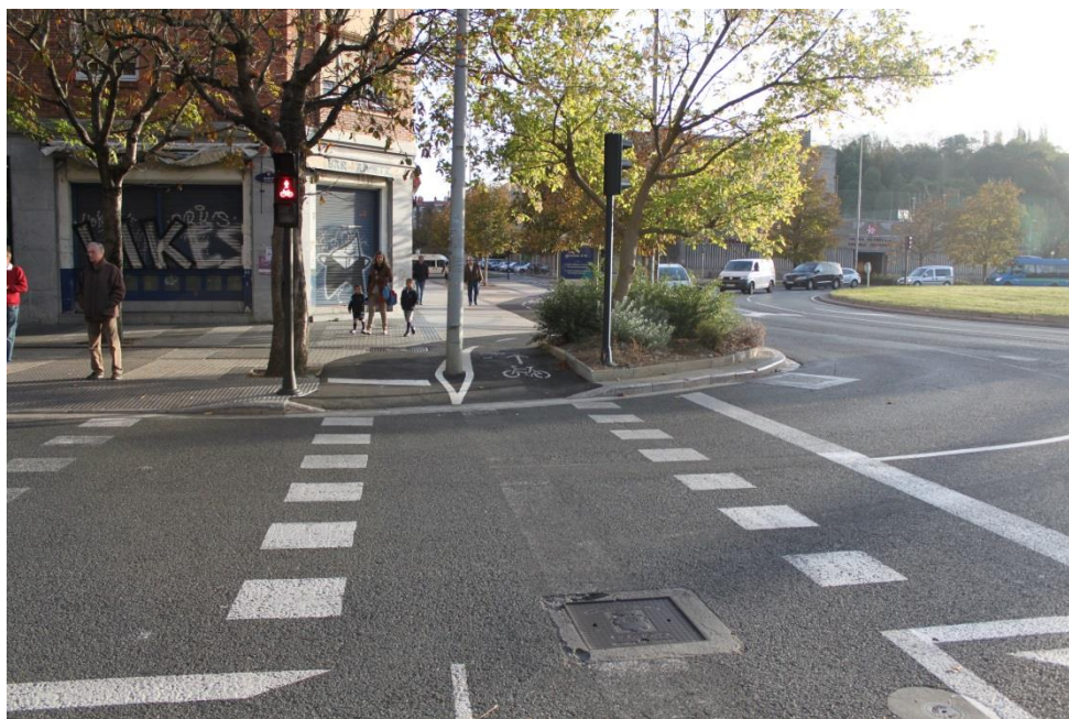
Figur 44: Lysregulert kryssløsning for sykkelveg ved rundkjøring.
