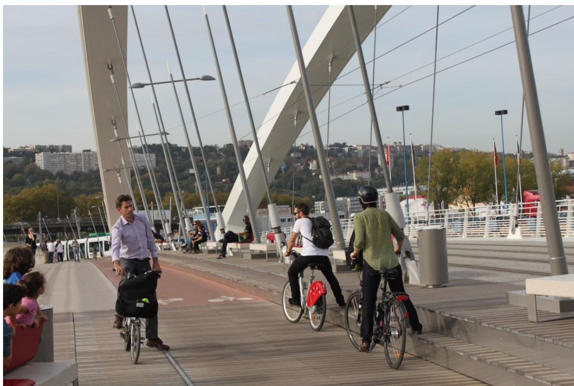
Figur 12: Pont Raymond Barre. Ny bru som er tilrettelagt for tovegssykling. Sykkelvegen er fysisk atskilt med lav kantstein mot gangareal. Trikketraséen er fysisk atskilt fra GS-areal. Brua har også relativt store oppholdsarealer med benker.
