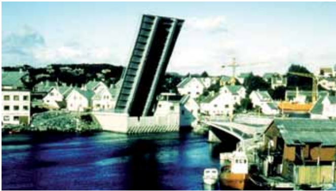
Fig. 4.3.8-4: Klaffebru, enarmet, bjelker. Byggverkstype 851
