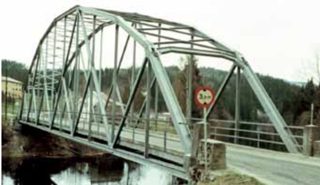
Fig. 4.3.6-5: Fagverksbru, fritt opplagt med buet overgurt. Byggverkstype 621
