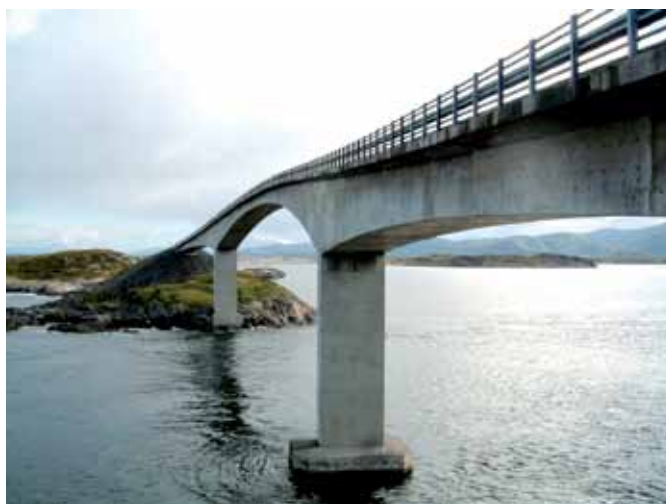
Fig. 4.3.4-7: Kassebru, Fritt frambygg. Byggverkstype 431
