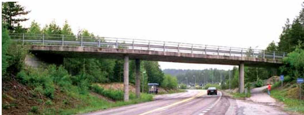
Fig. 4.3.2-2: Platebru, massiv med overliggende kantforsterkning. Byggverkstype 214
