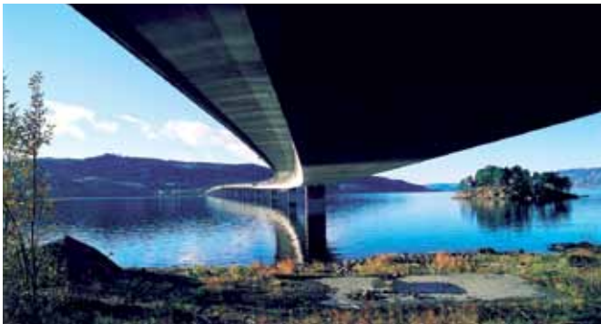
Fig. 4.3.4-4: Kassebru. Byggverkstype 415
