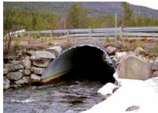
Fig. 4.3.1-6: Hvelv i fylling, korrugert, med bunnplate. Byggverkstype 161
