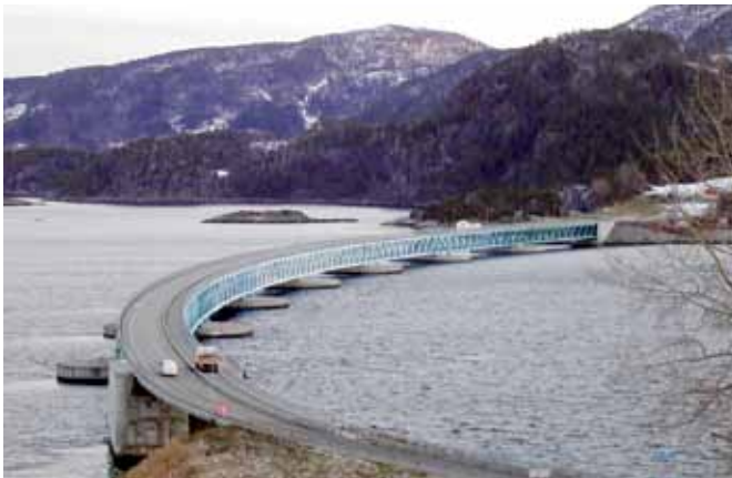
Fig. 4.3.7-7a: Flytebru, adskilte flyteelementer uten forankring. Byggverkstype 766, stålfagverk.
