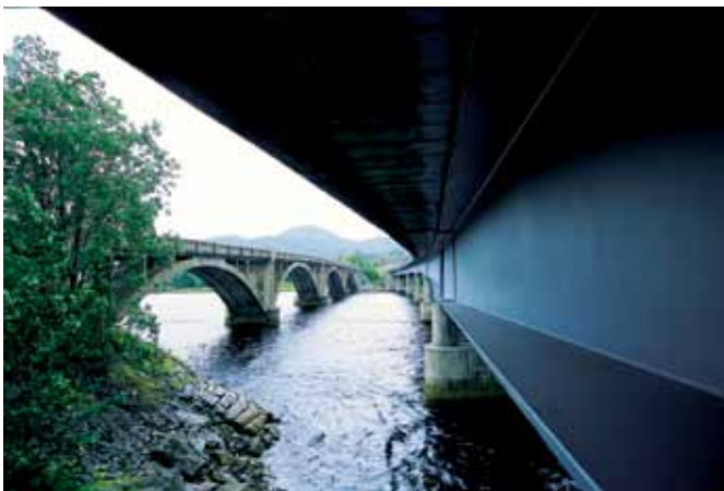
Fig. 4.3.3-5: Bjelkebru, platebærere, konstant høyde. Byggverkstype 372
