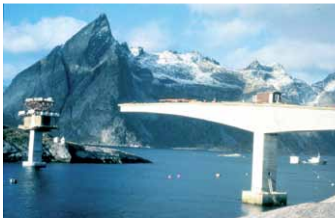
Fig. 4.3.4-6: Kassebru, Fritt frambygg. Byggverkstype 431
