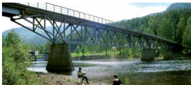
Fig. 4.3.6-3: Parallellfagverksbru, overliggende brudekke, hellende endestaver. Byggverkstype 611
