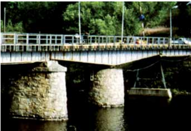
Fig. 4.3.8-6: Svingbru, likearmet, bjelker. Byggverkstype 861
