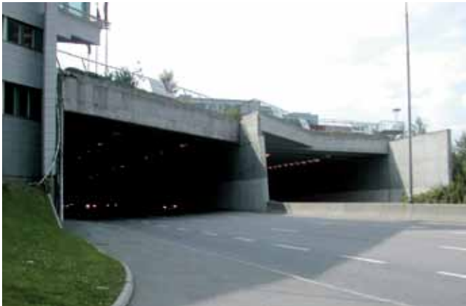
Fig. 4.3.9-4: Veglokk, Byggverkstype 96
