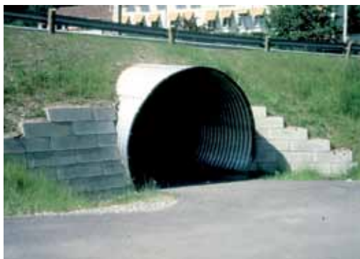
Fig. 4.3.1-5: Rør i fylling, korrugert, sirkulært (med vinger). Byggverkstype 141
