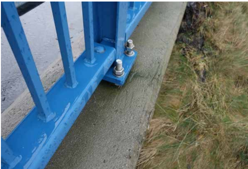
Eksempel V4.3-1 Løse skruer/nagler
