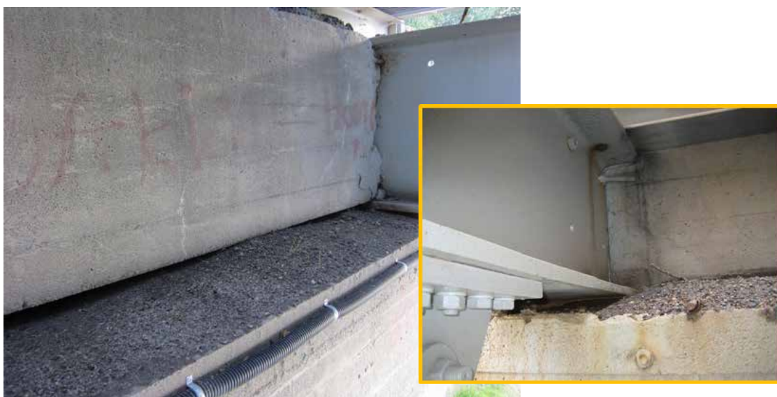
Eksempel V8.1-1 Manglende rengjøring
