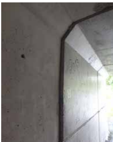
Eksempel V1.2-1 Bevegelse mellom vegg-elementer
