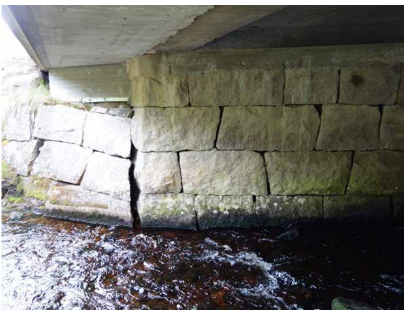
Eksempel V2.2-1 Erosjon
