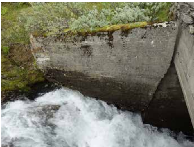
Eksempel V1.2-5 Bevegelse i vinge oppstrøms
