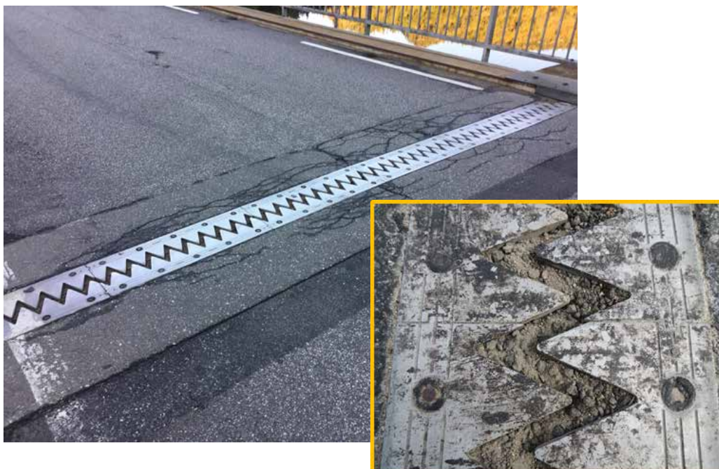
Eksempel V8.1-2 Manglende rengjøring
