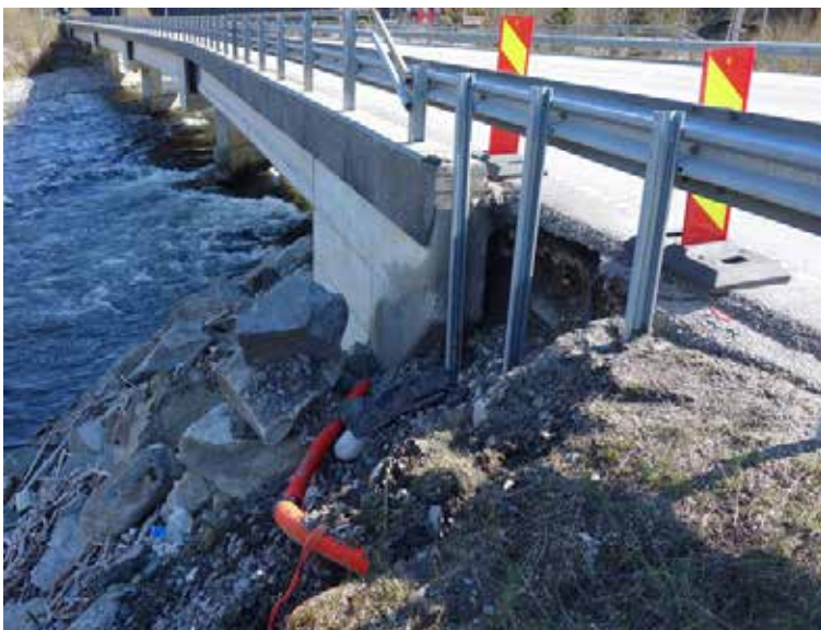
Eksempel V2.2-4 Erosjon
