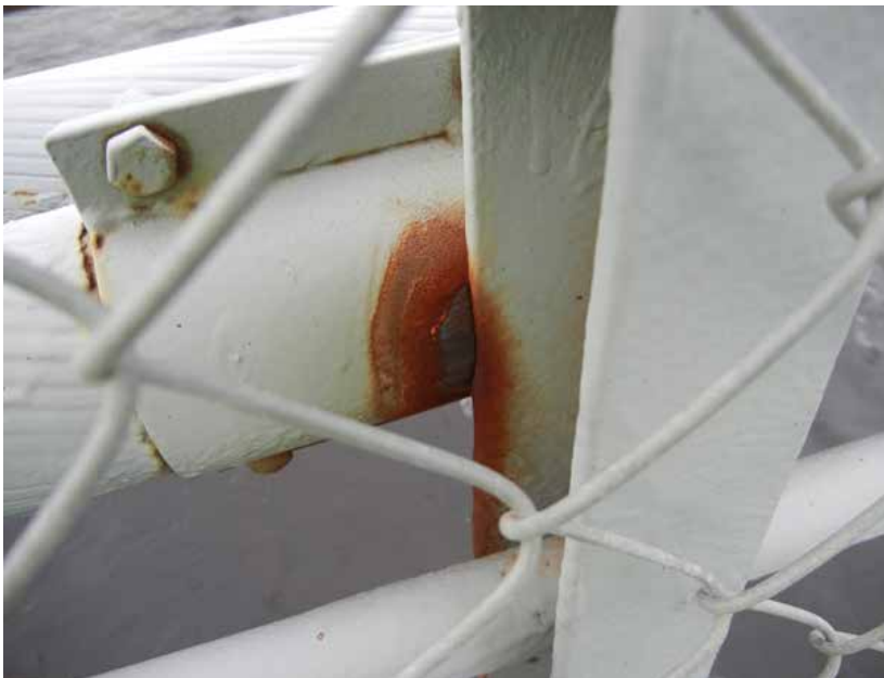
Eksempel V4.5-1 Slitasje/gnisning
