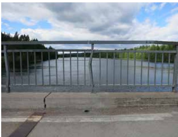
Eksempel V1.3-1 Deformasjon
