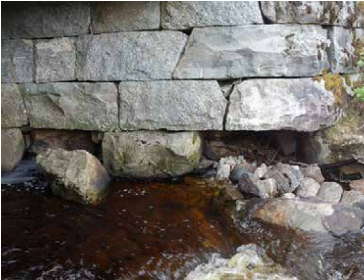
Eksempel V2.2-2 Erosjon
