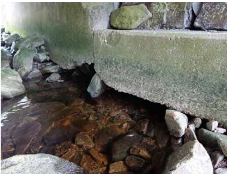
Eksempel V2.2-3 Erosjon
