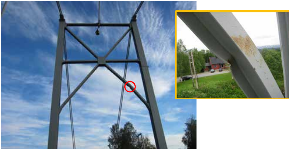
Eksempel V1.3-4 Deformasjon
