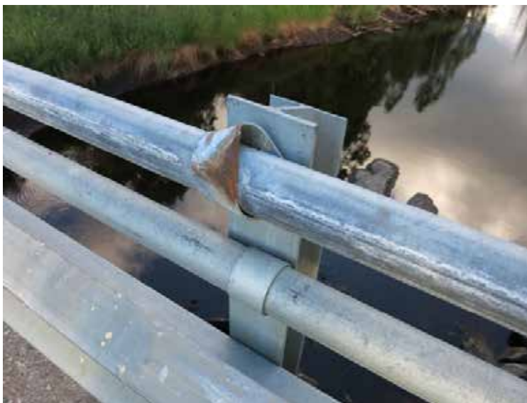
Eksempel V1.3-2 Deformasjon
