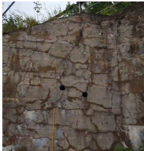
Figur 10 Landkarvinge med riss som skyldes AR (Foto: Audun E. Sanda, Statens vegvesen)
