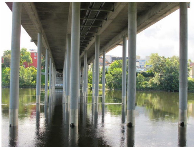
Figur 13 Elgeseter bru – betongplate med fire langsgående underliggende bjelker (Foto: Eva Rodum, Statens vegvesen)
