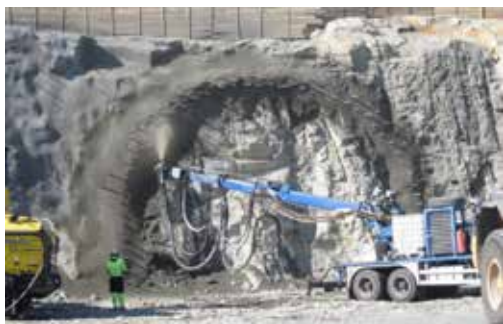
Figur 4.6 To raster med forbolter, 6 m \text{\O} 32 mm, bundet sammen med \text{\O} 16 mm kamstål, innerste rast helt ned mot sålen. Illustrert i skisse til høyre: innerste rast 60-70 cm fra teoretisk sprengningsprofil med innbyrdes bolteavstand c/c 60-70 cm, og en ytre rast 60-70 cm utenfor denne igjen, satt slik at boltene i ytre rast plasseres midt mellom to bolter i indre rast (såkalt W-mønster). Ringveg Vest Bergen, 2. byggetrinn. (Foto: T. Kirkeby)
