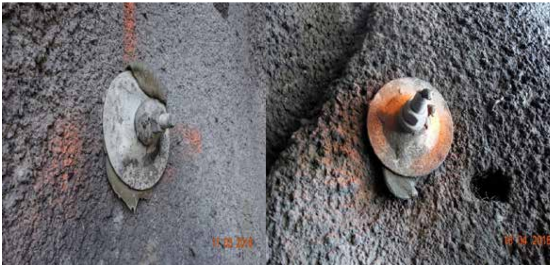
Figur 4.2 Mørtel ut bak plata er en god indikasjon på full oppfylling av bolt og hull (Foto: T. Kirkeby)
