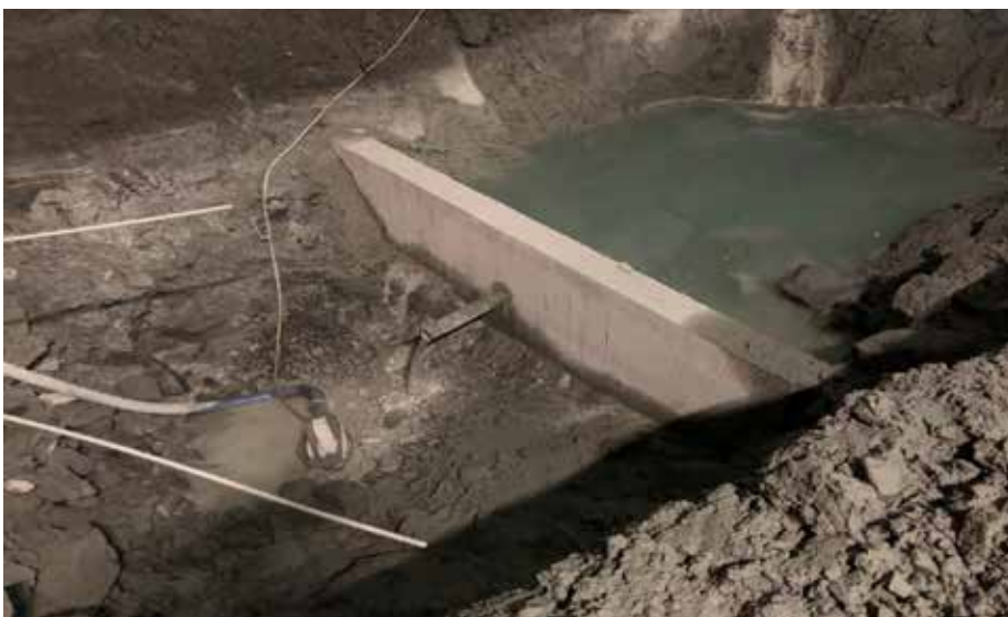
Figur 4.14 Eksempel på operativ måleterskel fra E39 Lyshorntunnelen (Foto: T. Kirkeby)
