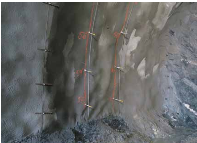
Figur 4.28 Armering (f.eks. \varnothing 10 mm) kan monteres som sprøytemal i riktig avstand fra boltespissen, for å lette arbeidet for sprøyteoperatøren. Lyshorntunnelen. (Foto: J. Volden)
