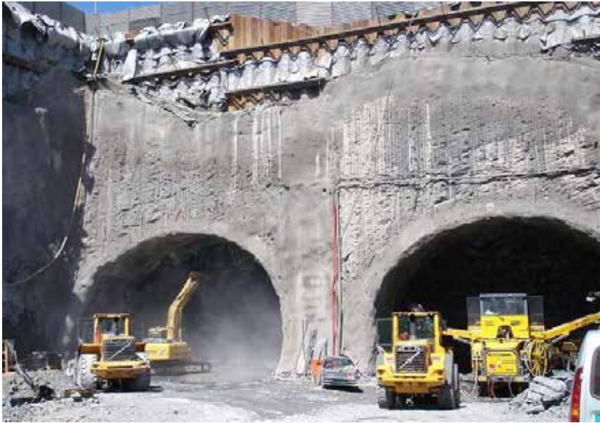
Figur 4.3 Jevn kontur i påhuggsflate. Lørentunnelen (Foto: A. Neby)
