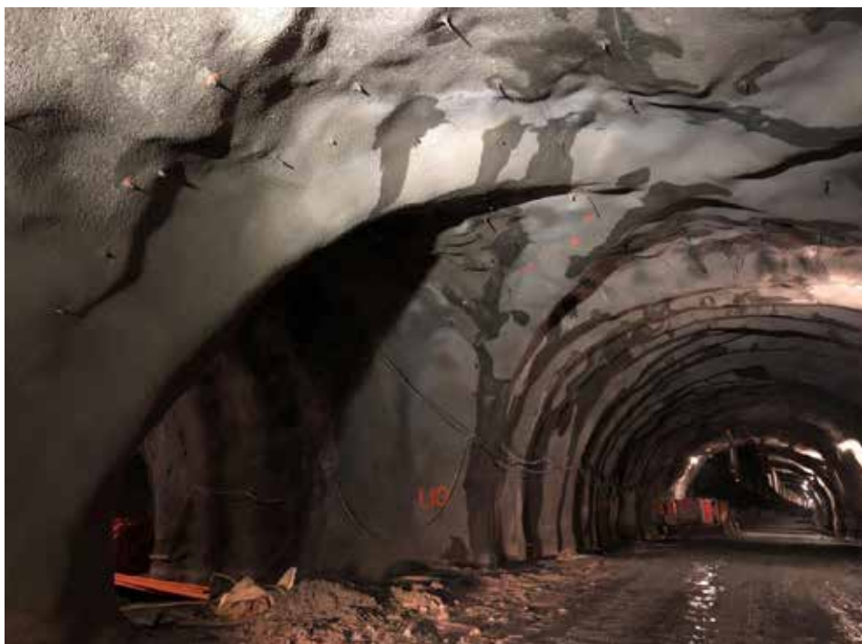
Figur 4.37 Kryssbuer ved tverrforbindelse, fotografert fra pel 5770 i figur 4.36. (Foto: T. Kirkeby).
