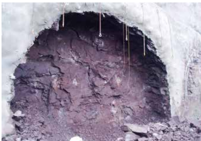
Figur 4.5 Med god forhåndssikring og skånsom sprengning kan påhuggsprofilen stå selv i meget oppsprukket berg. Frodeåstunnelen, Tønsberg. (Foto: T. Kirkeby)
