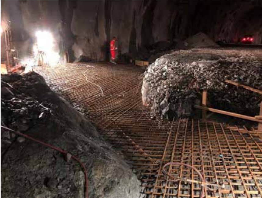
Figur 4.32 Relativt tett armering i buformet sålestøp avsluttet mot berget utenom sonen. Åpen armering i sprøytebetongbue kan skimtes i veggens til venstre. Eksempel fra rv. 580 Søråstunnelen i Bergen 2018. (Foto: T. Kirkeby)
