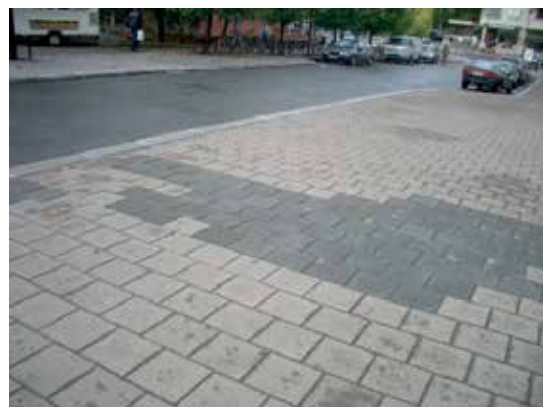
Utbedring av gammelt dekke med nye heller
