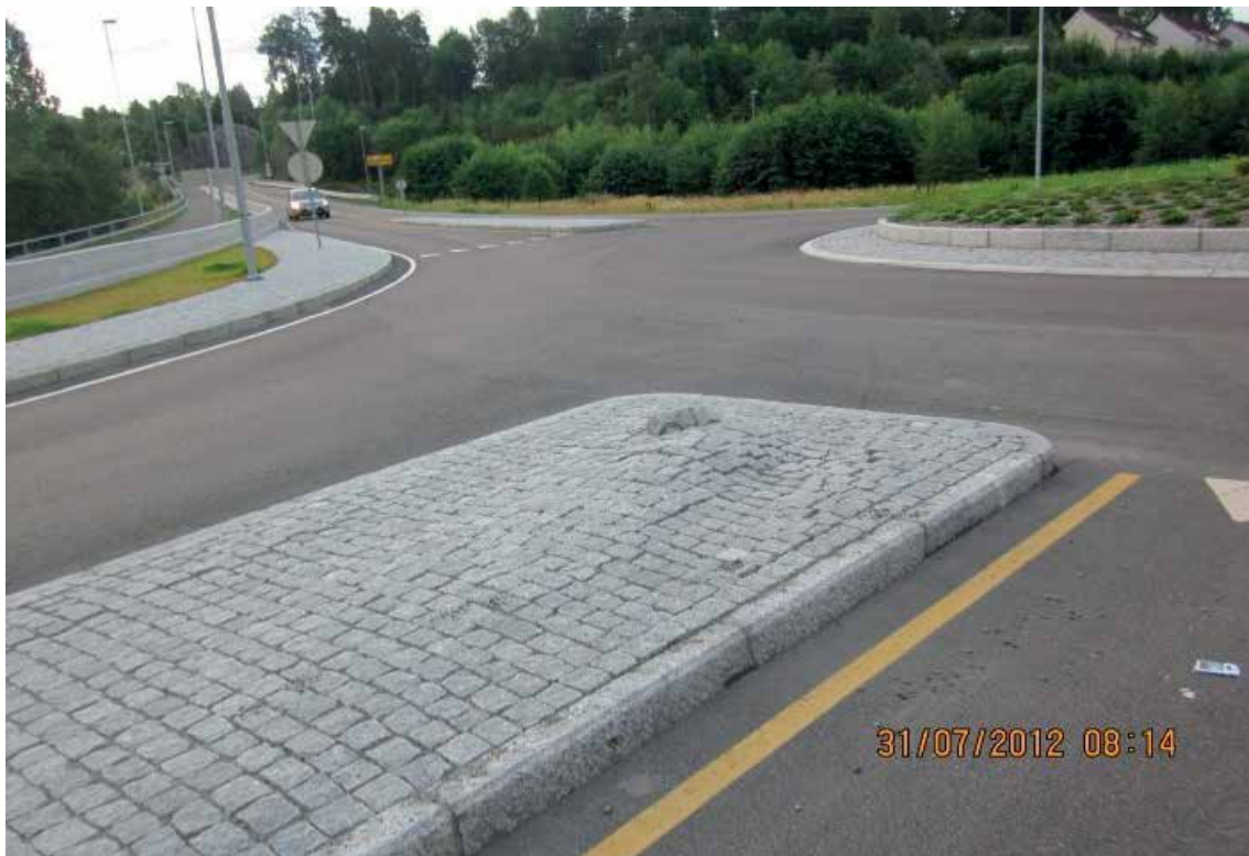
Figur V1.11 Deformasjon i steindekke etter belastning (foto: René Kierstein)
