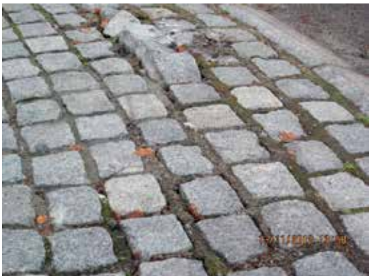
Figur V1.2 Løs stein i overkjørbar del av rundkjøring (foto: René Kierstein)
