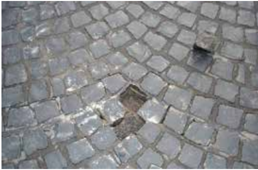
Figur V1.4 Manglende permeabilitet i underliggende bundne lag fører til at stein løsner (foto: René Kierstein)
