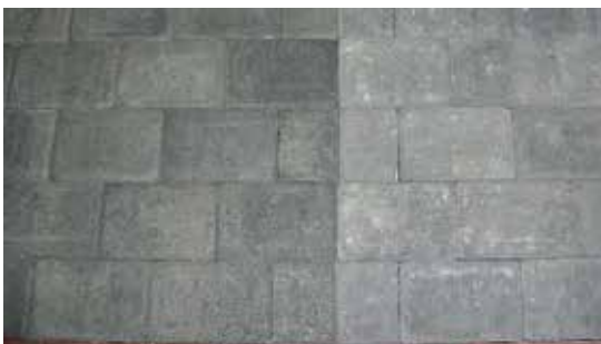
Figur 7.4 Impregnering av belegningsstein, høyre side: uten impregnering (kilde: SL Stenlegging)
