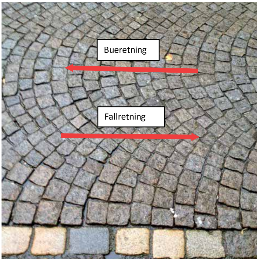
Figur 5.12 Bueretning og fallretning ved buesetting (foto: René Kierstein)
