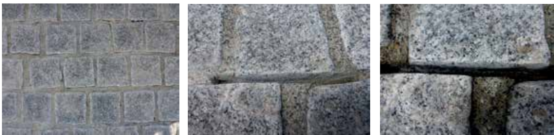
Figur 7.6 Dårlige fuger rehabiliteres (venstre), fugemørtel fjernes (midtre) og fugene spyles og renses (høyre) (foto: Rudi Grimelid)
