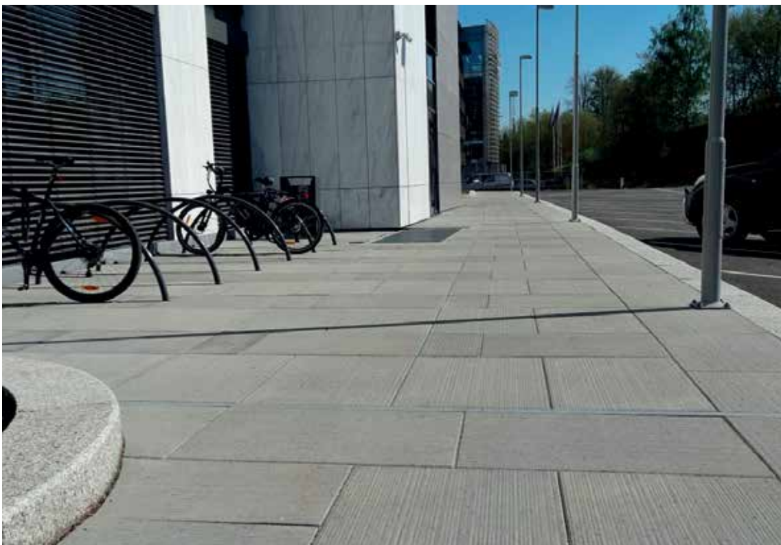
Figur 4.1 Betongheller på gangarealer (foto: René Kierstein)
