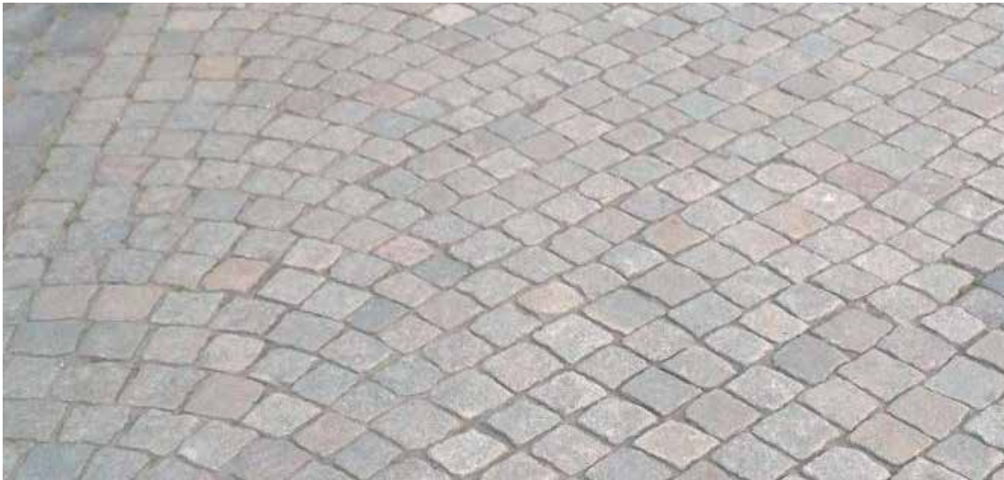
Figur 5.8 Eksempler på diagonalsetting (illustrasjon og foto: René Kierstein)
