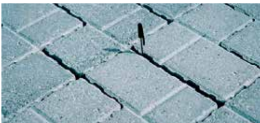
Figur 7.5 Fugesand mangler med risiko for forskyvninger (foto: Ragnar Evensen)
