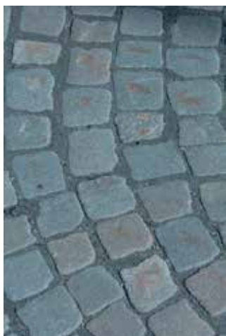
Fuge av sand med finstoff, godt resultat etter 4 år
