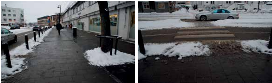
Figur 7.1 Fortau med gatevarme (venstre bilde) og taktile indikatorer krever spesiell oppmerksomhet (høyre bilde) (foto: Tor Erik Saltnes)
