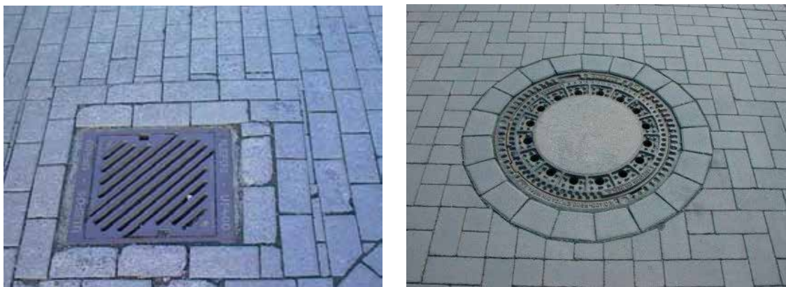
Figur 3.5 Dårlig og god tilpasning til slukramme (foto: Ragnar Evensen, René Kierstein)
