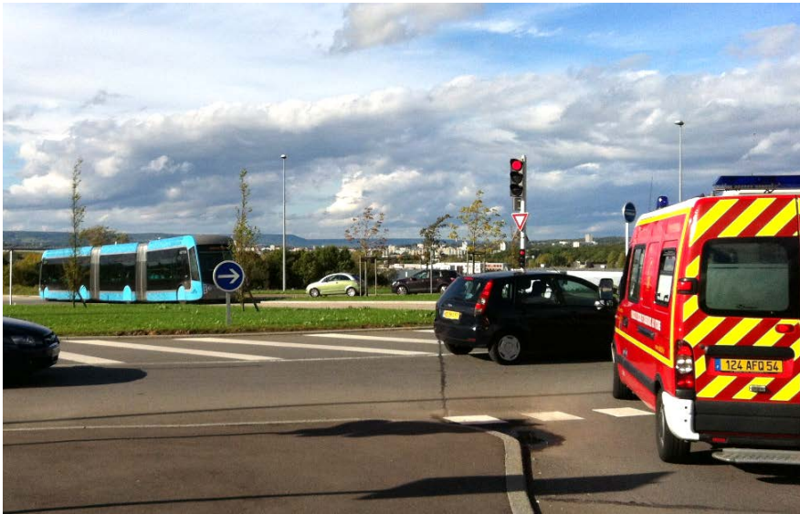
Figur 11 Buss med eget felt gjennom rundkjøring. Biltrafikken stanses med ordinære lyssignal i inne i rundkjøringen
