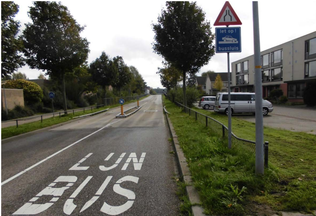
Figur 46 Bussluse for å hindre gjennomkjøring for privatbil
