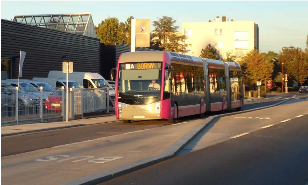
Figur 9 3- feltstrekning der buss har eget felt fram mot kryssene i endene av 3- feltstrekningen
