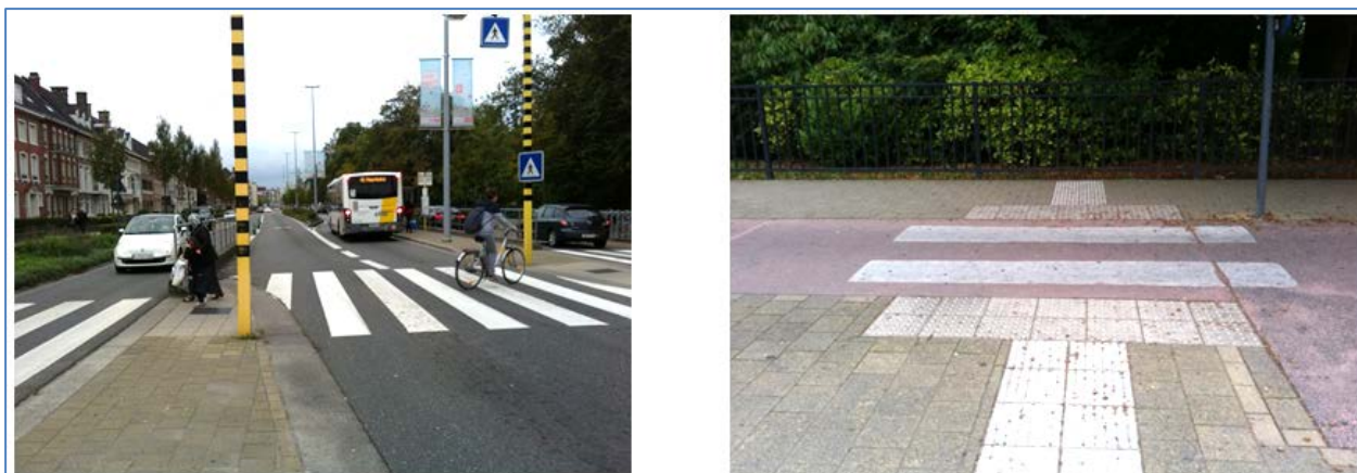
Figur 22 Oppmerket gangfelt over midtstilte kollektivfelt, og detaljutforming av kryssing av sykkelfelt
