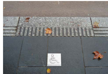
Figur 4 Markering av påstigningspunkt for HC
