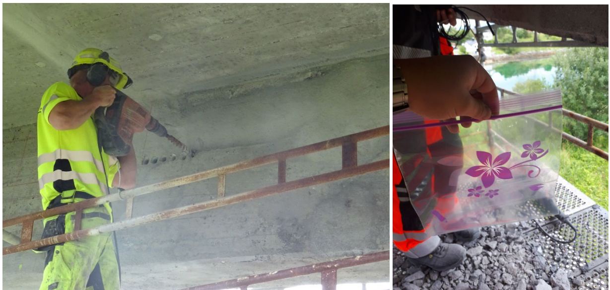
Figur 3.4 Venstre: Eksempel på søm-boring etterfulgt av meisling i områder for uttak. Høyre: Plastpose for lagring av injiseringsmasse eller metallprøver.
