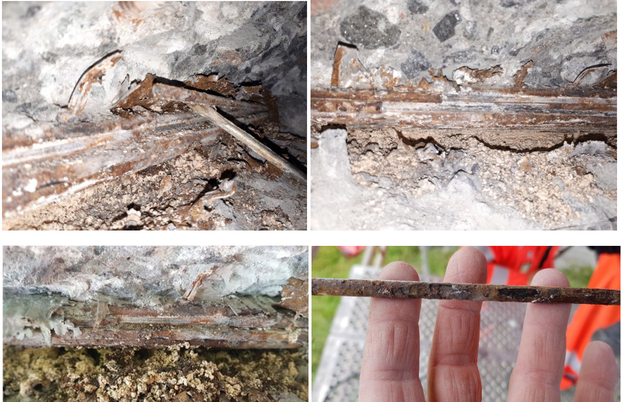
Figur 4-1 Bilder tatt under inspeksjonen 11.-12.08.2020 (tilsvarer bilde 3-3, 3-16, 3-19, 3-20, 3-21, 3-22, 3-25, 3-2, 3-9 i Vedlegg 5).
