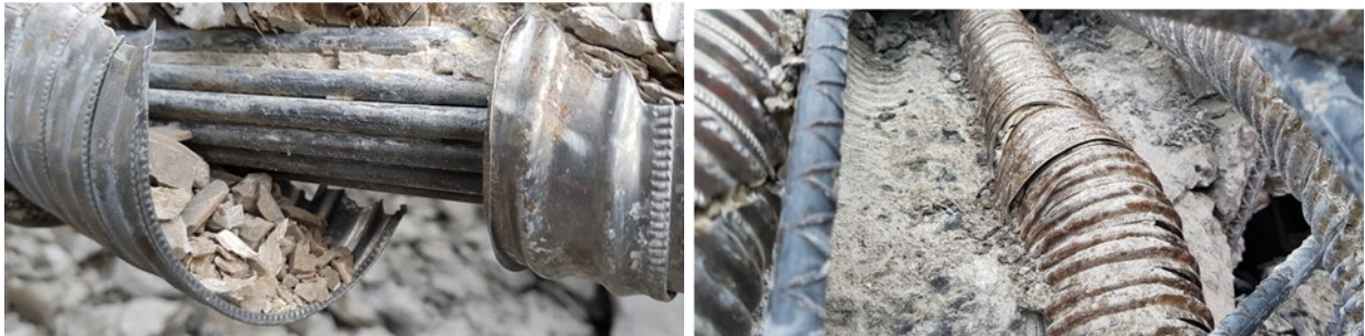
Figur 2.1 Bilde av spenntråder i en kabelkanal fylt med injiseringsmasse (Farriseidet bru, Larvik). 4
