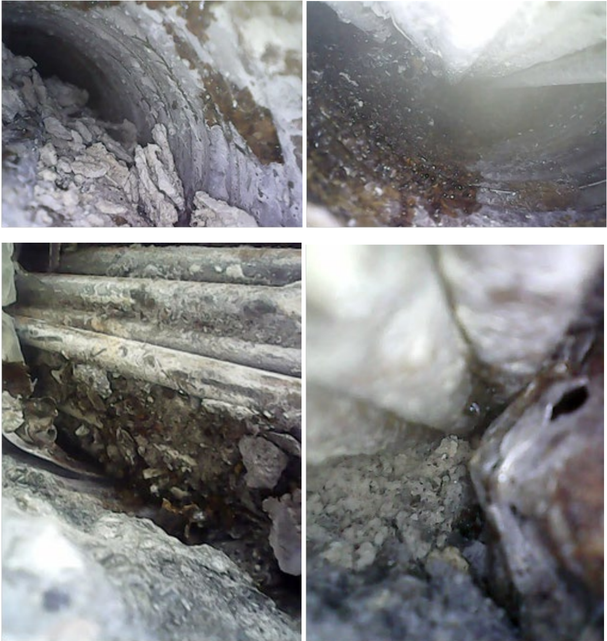
Figur 2-2 Bilder tatt under inspeksjonen 11.-12.08.2020 (tilsvarer bilde 1-6, 1-7, 1-11,1-3 i Vedlegg 5).
