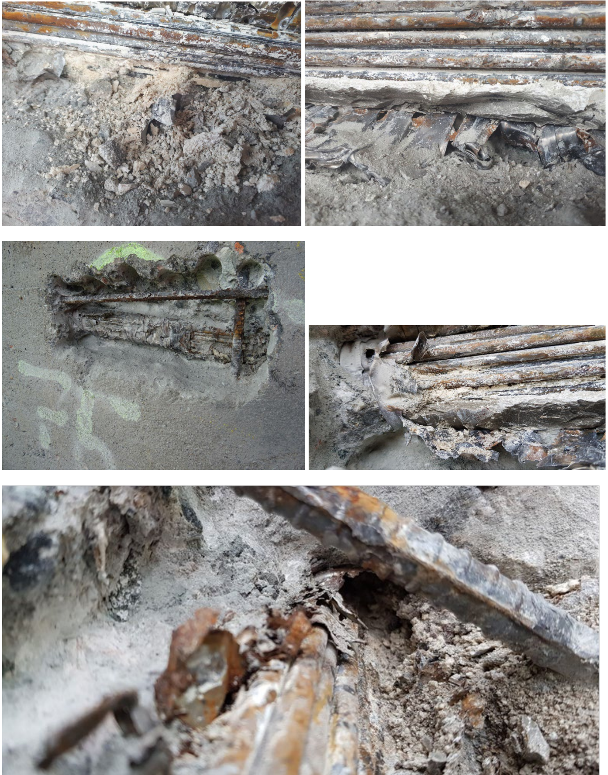
Figur 3-2 Bilder tatt under inspeksjonen 11.-12.08.2020 (tilsvarer bilde 2-11, 2-12, 2-2, 2-5 og 2-6).
