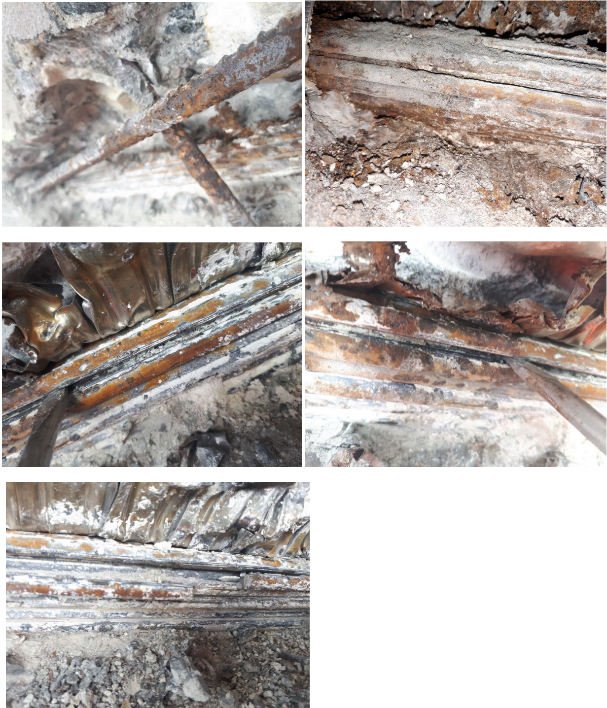
Figur 3-1 Bilder tatt under inspeksjonen 11.-12.08.2020 (tilsvarer bilde 2-14, 2-10, 2-15, 2-16, 2-18 i Vedlegg 5).
