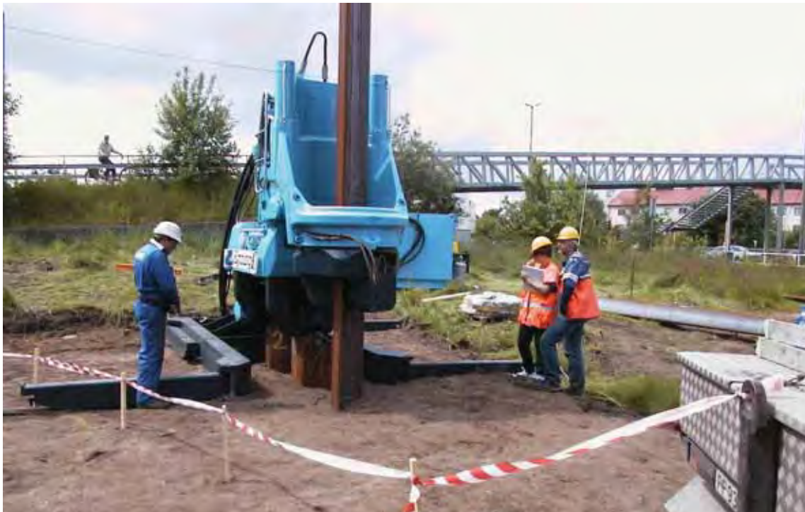
Figur 18.3 Prøvespunting med Silent Piler anlegget E 18 Kristiansand, Oddernestunnelen
