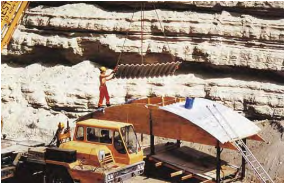
Figur 12. 26 Mal til formontering av plater.
