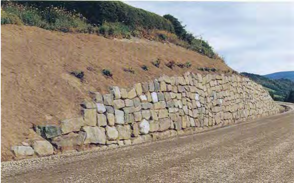
Figur 16.36 Ferdig mur ved Vingrom kirke forblendet med naturstein
