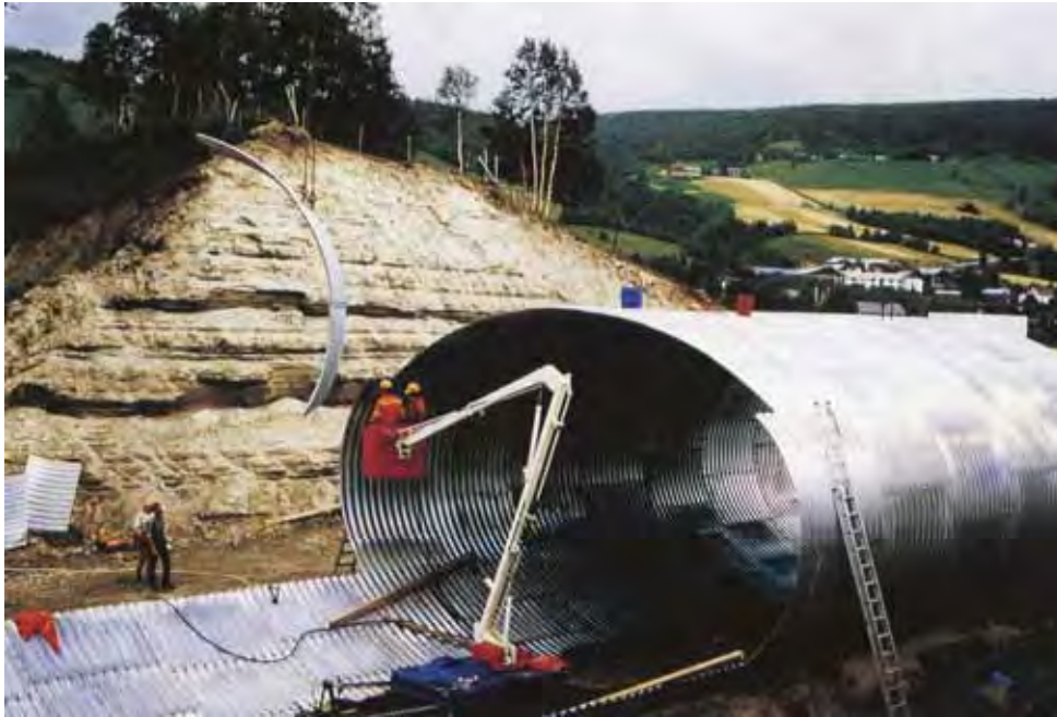
Figur 12. 25 Formonterte plater heises på plass.
