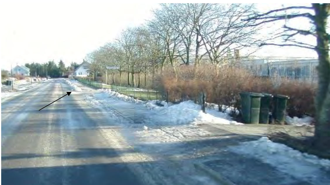
Figur 4-70 Lengst bort i bildet ser vi eksempel på riktig utførelse av brøyting av fortau
