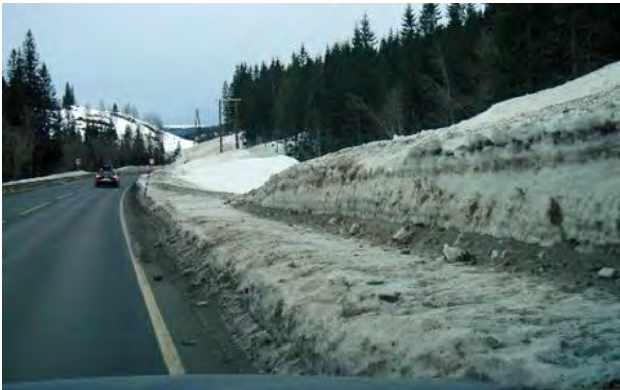
Figur 2-64 Fjerning av høye brøytekanter Foto: Statens vegvesen)
