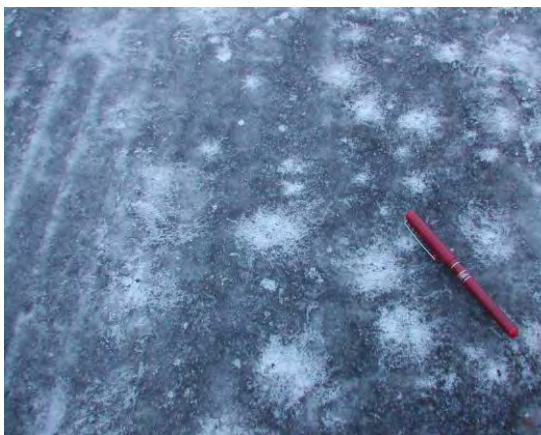
Figur 8-4 De-ising – Salting for å fjerne et is- eller snødekke (Foto: t.v. Torgeir Vaa, t.h. Håkon Aurlien)
