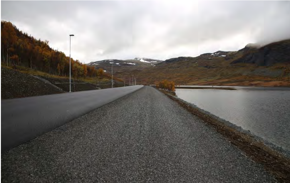
Figur 4-102 Opparbeidet fresegate på fylling på E16 Filefjell (Foto: Åsmund Espe, Statens vegvesen)
