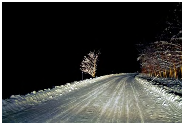
Figur 5-4 Friksjon på snøføre/tørr is, \mu=0,15-0,30 (Foto: Knut Opeide, Statens vegvesen)
