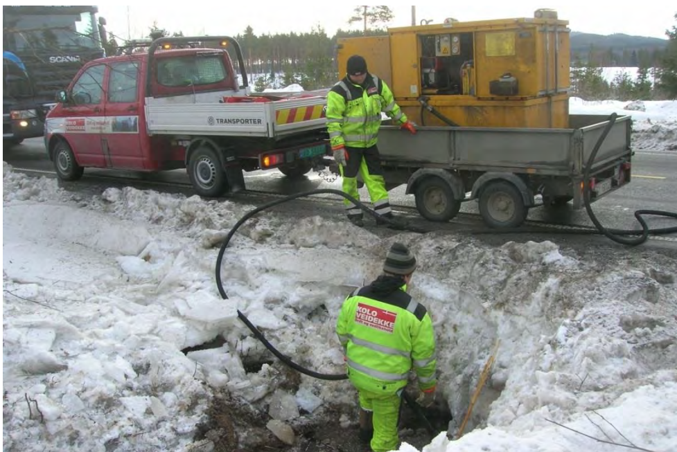
Figur 9-2 Tining av stikkrenne (Foto: Knut Magne Reitan)
