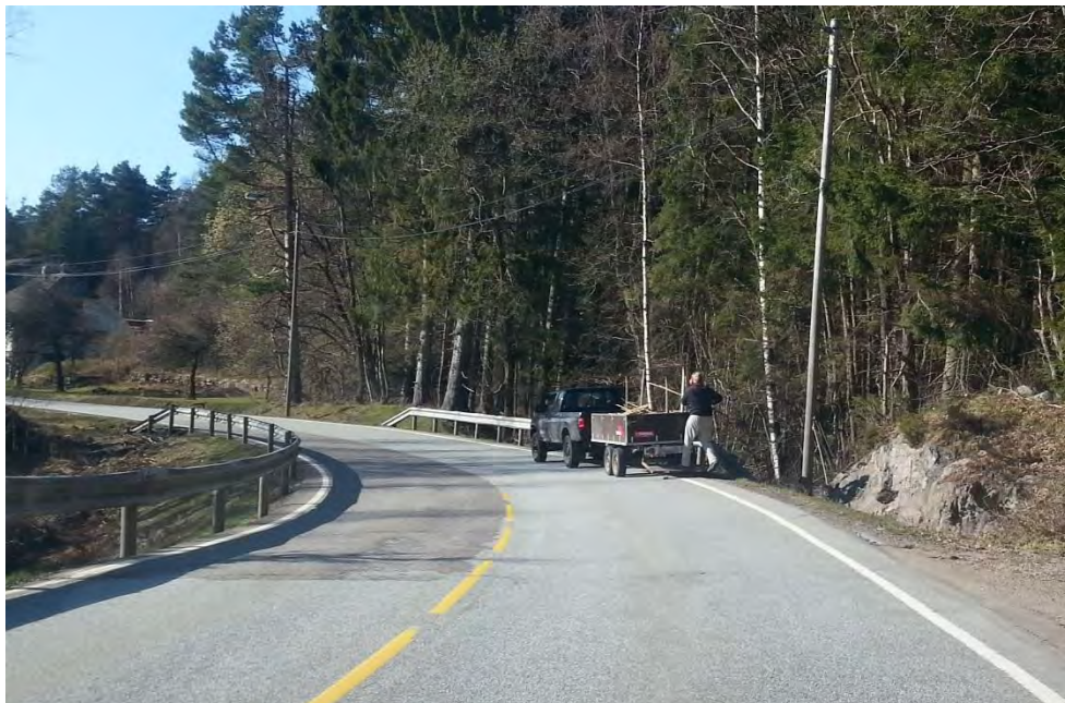
Figur 2-85 Bildet viser opptak av brøytestikker langs en riksveg med fartsgrense 80 km/t. Operatør er noe sparsomt utstyrt med vernetøy. Kjøretøyet er anonymt og kan forårsake farlige trafikksituasjoner. (Foto: Dag Øystein Løyning)
