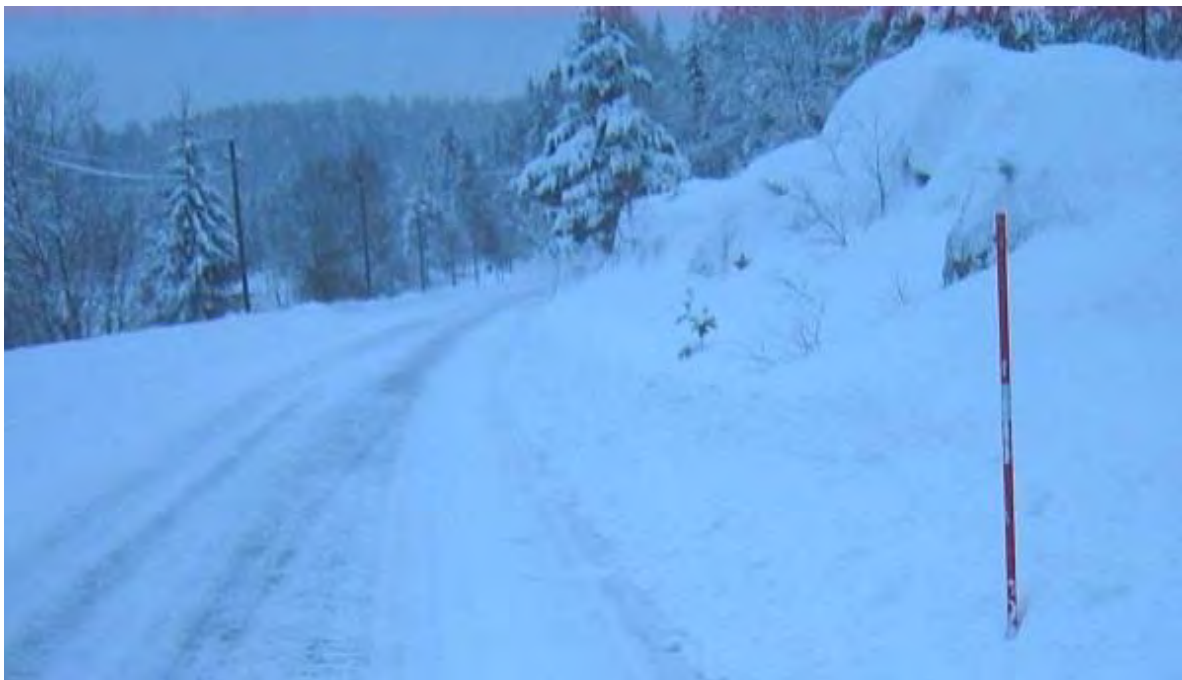
Figur 9-10 Brøyttestikk angir ytterkant for brøyting (Foto: Statens vegvesen)
