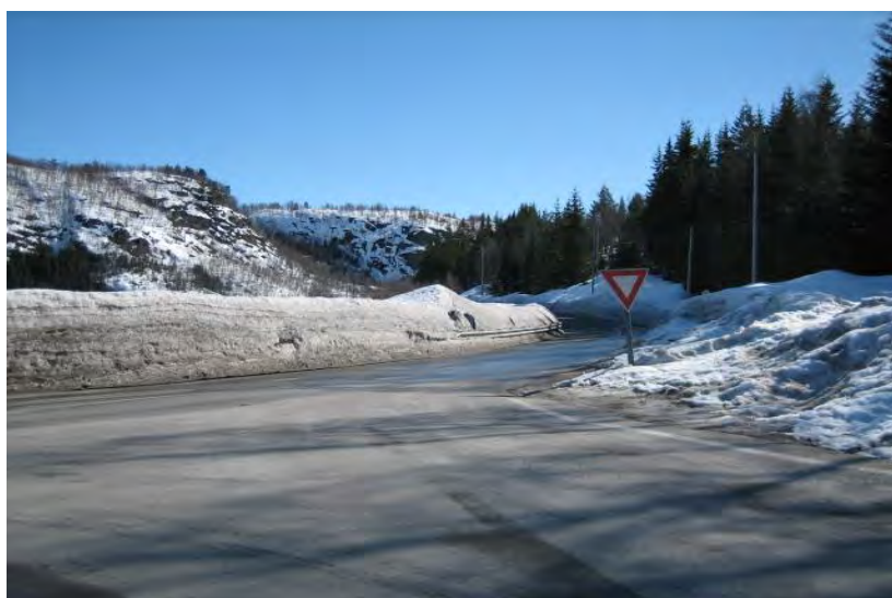
Figur 2-60 Manglende sikt i kryss (Foto: Risa)
