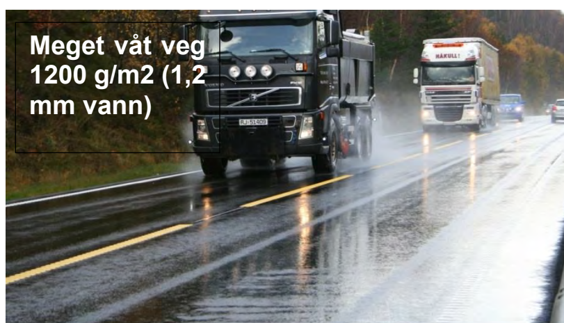
Figur 8-10 Ulike vannmengder på vegen (Foto: Statens vegvesen)
