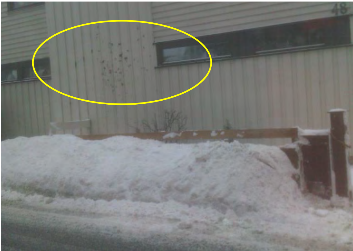
Figur 4-88 Uønsket sprut fra brøyting på fasade (Foto: Rudi Thomassen, NVE)
