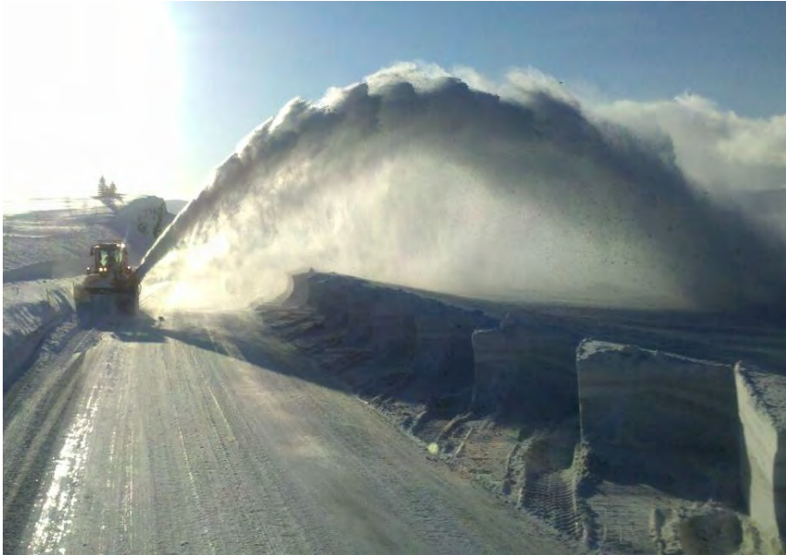
Figur 4-82 Fresing av brøytekanter, Ev6 Gratangsfjellet 2013 (Foto: Jan Lind, Statens vegvesen)
