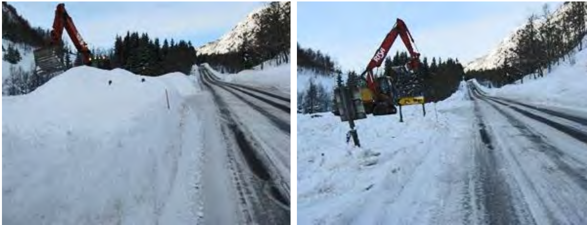
Figur 2-58 Siktrydding med hjulgående gravemaskin (Begge foto: Risa)
