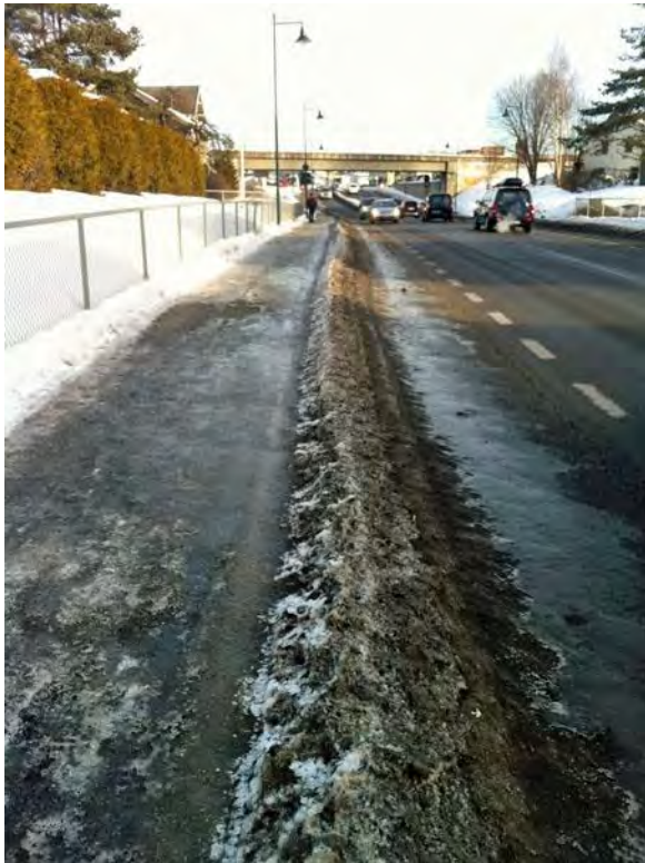
Figur 2-47 Tining og frysing i sykkelfelt
