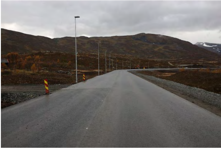
Figur 4-105 Eksempel på ombygd høyfjellsveg med terrengtiltak langs vegen (Foto: Åsmund Espe)
