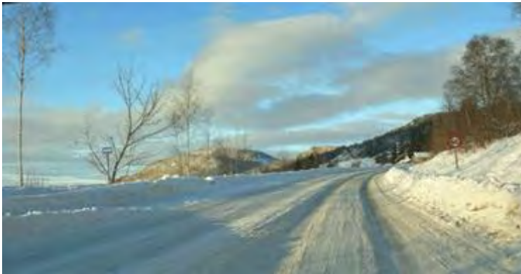
Figur 2-31 Sporete vegbane (Foto: Statens vegvesen)
