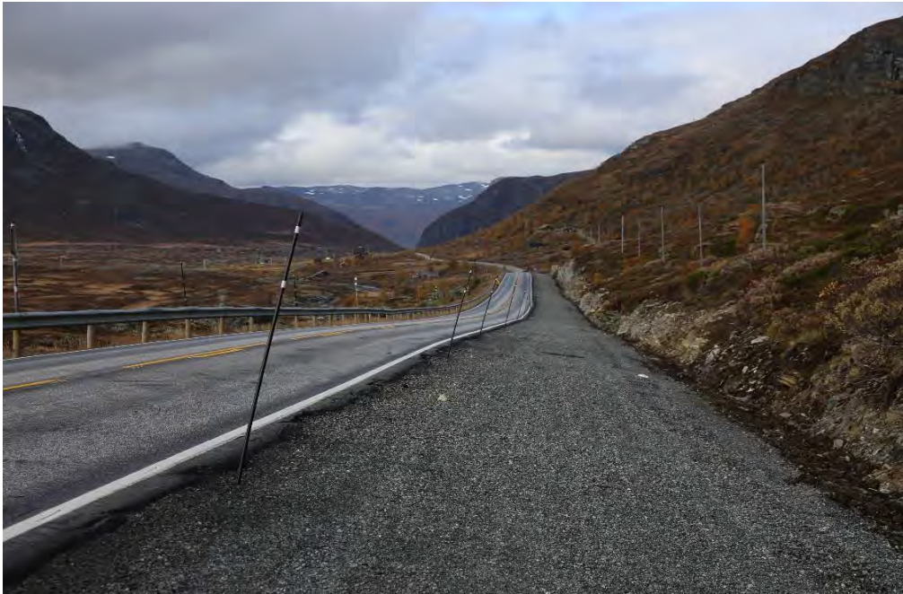
Figur 4-101 Opparbeidet fresegate i skjæring på rv. 52 Hemsedalsfjellet (Foto: Åsmund Espe, Statens vegvesen)
