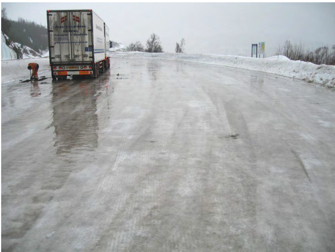
Figur 7-17 Våt is på sideanlegg med behov for tiltak (Foto: Statens vegvesen)
