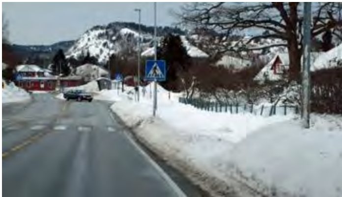
Figur 2-54 Manglende siktrydding til kryssingspunkt over hovedveg (Foto: Pål H. Paulsen)
