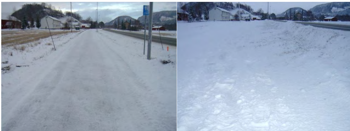
Figur 4-66 Eksempler på godt resultat (til venstre) og dårlig resultat (til høyre) etter brøyting av både hovedveg og g/s-veg
