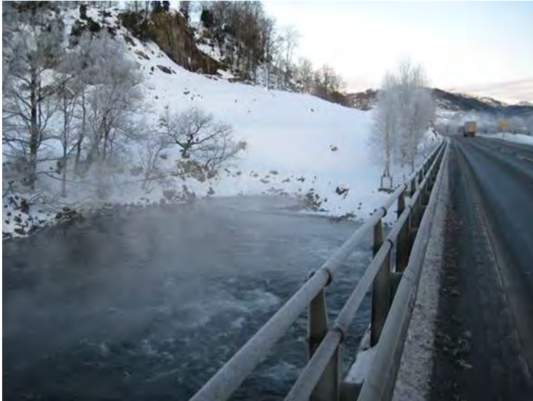
Figur 8-11 Nærhet til åpent vann vil kunne gi økt fare for utfelling av dugg/rim (Foto: Anders Svanekil)
