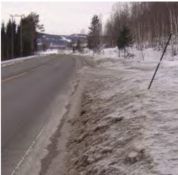
Figur 9-12 Feilaktig plasserte og manglende brøytestikk kan føre til ulykker (Foto: Statens vegvesen)
