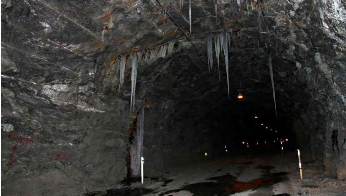
Figur 9-4 Istapper i tunneler, på bruer eller andre områder over trafikkert område skal fjernes innen 12 timer (Foto: Harstad Tidende)
