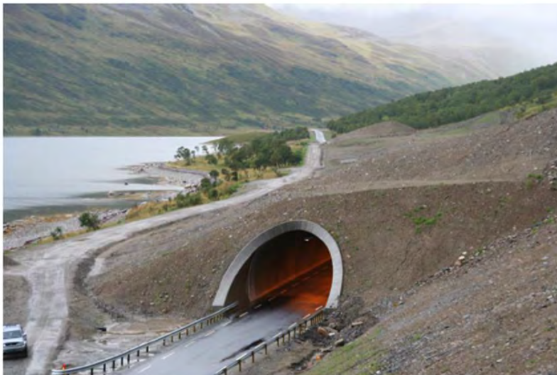
Figur 9-21 Eksempel på skredoverbygg
