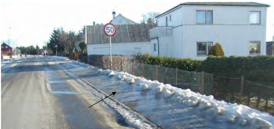
Figur 4-69 Eksempel på uheldig utførelse av brøyting av fortau
