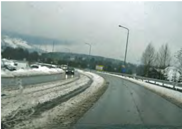
Figur 2-32 Dårlig brøytet forbikjøringsfelt (Foto: Statens vegvesen)
