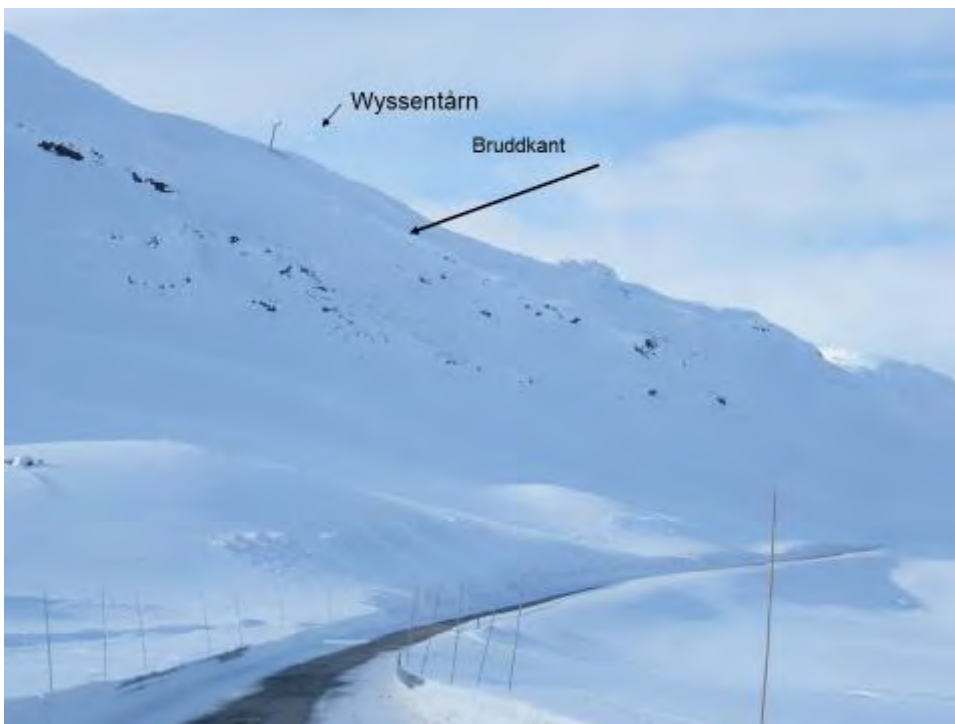
Figur 4-98 Wyssentårn brukt til nedsprengring av snøskred på fv. 53 Årdal-Tyin. Tårnet har flere sprengladninger som kan avfyres trådløst etter behov. (Foto: Njål Farestveit, Statens vegvesen)
