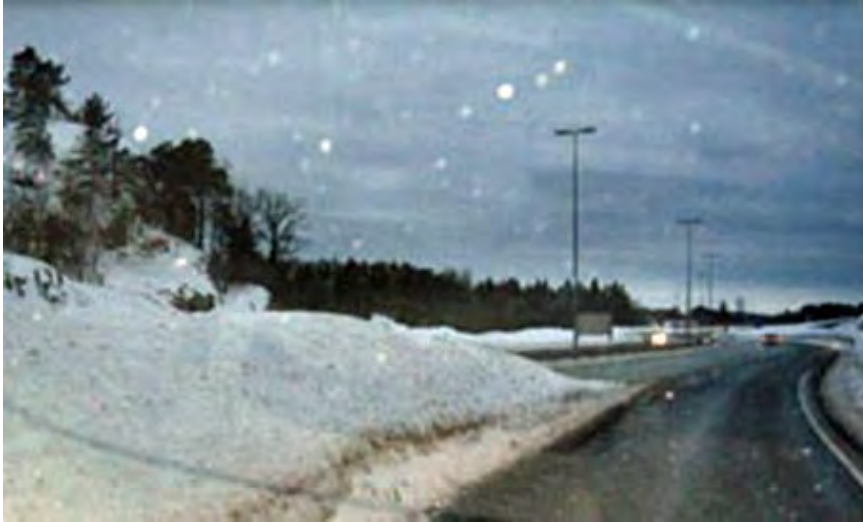
Figur 2-63 Tilstrekkelig sikt fra påkjøringsrampe til motorveg (fartsgrense 100 km/t) (Foto: Arild Nærum)
