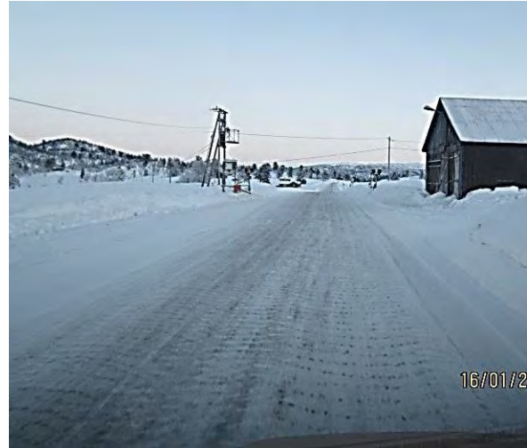
Figur 7-12 Bilde tatt etter 6 døgn på samme veg, friksjon 0,35 i gjennomsnitt. ÅDT ca. 500 (Foto: Stein Åsheim, Statens vegvesen)
