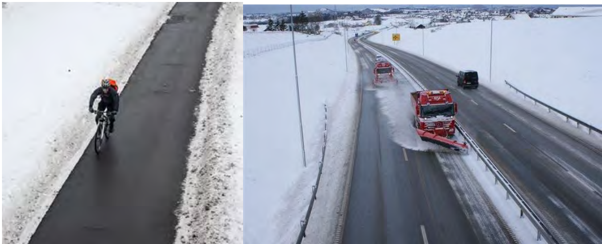
Figur 1-6 Vinterdriftsklasse GsA og DkA: Vegen brøytes og saltes slik at den blir bar kort tid etter snøfall (Foto: Knut Opeide, Statens vegvesen, Risa AS)
