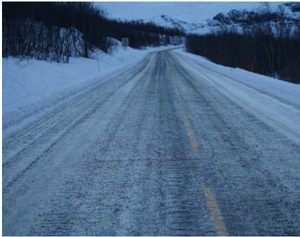
Figur 5-5 Friksjon på veg med isdekke strødd med sand, \mu=0,25-0,35 (Foto: Bård Nonstad, Statens vegvesen)
