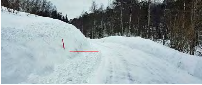
Figur 2-30 Dårlig Brøyting (Foto: Jahn Ivar Systad)
