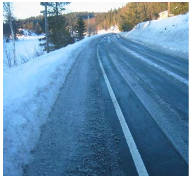
Figur 9-12 Feilaktig plasserte og manglende brøytestikk kan føre til ulykker (Foto: Statens vegvesen)
