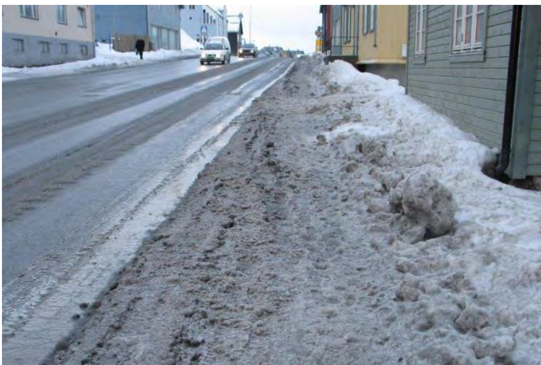
Figur 4-68 Lite attraktivt for gående og syklende (Foto: Jens Eriksen, Statens vegvesen)
