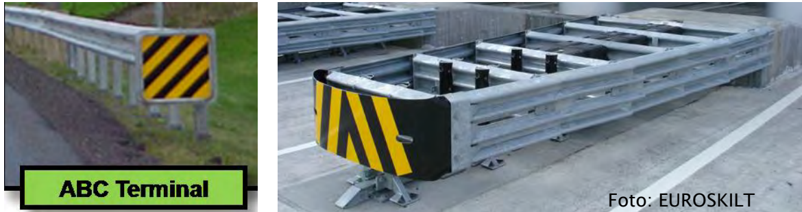
Figur 9-20 Rekkverksender og støtputer
