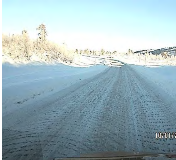
Figur 7-11 Varighet av fastsandmetoden på lavtrafikkert veg og under stabile værforhold. Bilde er tatt rett etter utlegging, friksjon 0,49 i gjennomsnitt. (Foto: Stein Åsheim, Statens vegvesen)
