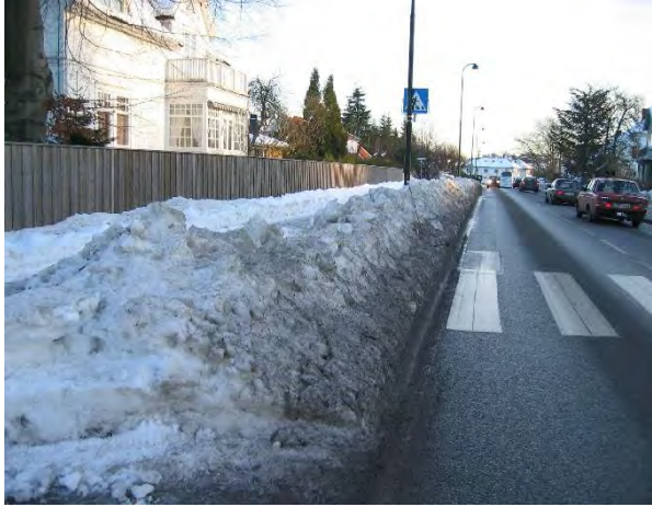
Figur 2-49 Manglende sikt og åpning i brøyttekanten
