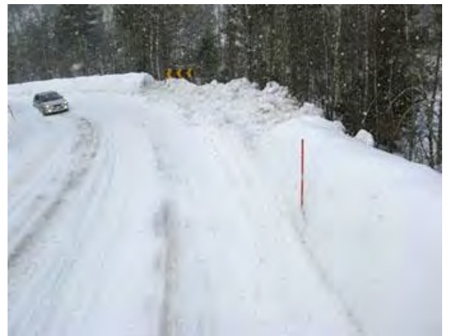
Figur 2-67 Retningsmarkering i kurve før rydding og etter rydding. Husk supplering av brøytstikk (Begge foto: Statens vegvesen)
