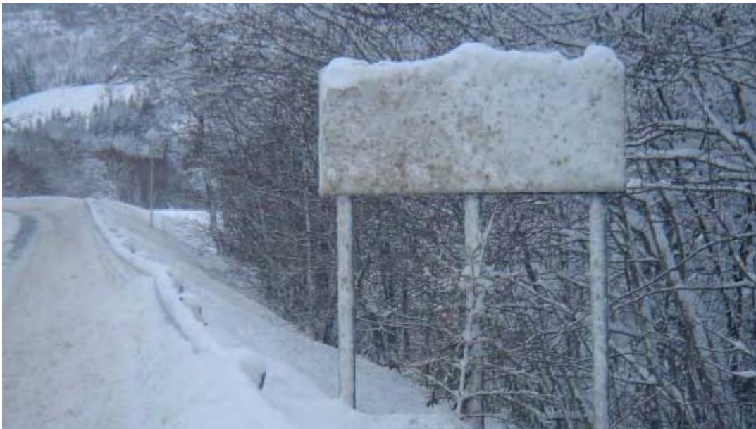
Figur 4-86 Nedsprutet trafikkskilt (Foto: SINTEF). Brøytefart over 40 km/t øker problemet med snø- og slapsesprut som dekker til skilt, og skader skilt, kantstolper, brøytestikk og andre installasjoner langs vegen.
