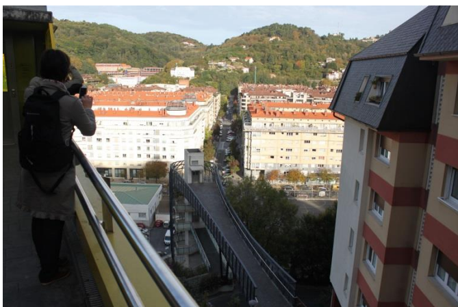
Figur 42: Flere heiser i samme anlegg.
