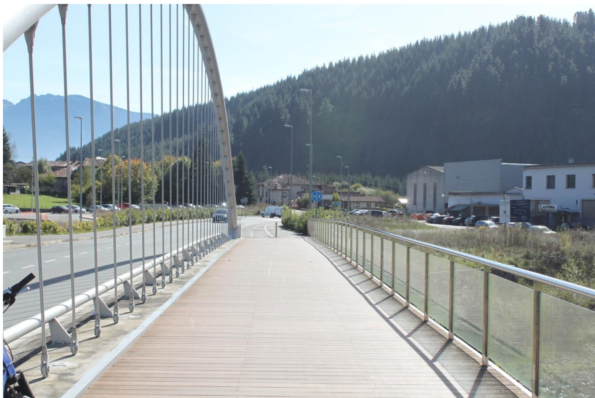
Figur 28: Bru hvor anlegget for gående og syklende er blandet, mens anlegget utenfor brua er separert i sykkelveg og fortau.
