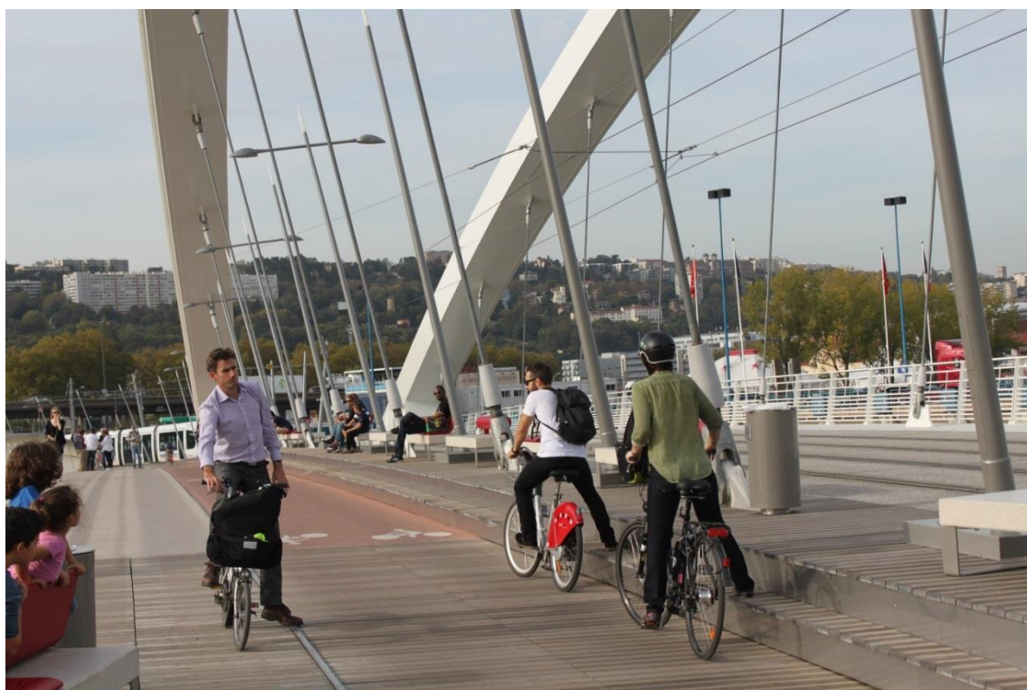
Figur 12: Pont Raymond Barre. Ny bru som er tilrettelagt for tovegssykling. Sykkelvegen er fysisk atskilt med lav kantstein mot gangareal. Trikketraséen er fysisk atskilt fra GS-areal. Brua har også relativt store oppholdsarealer med benker.
