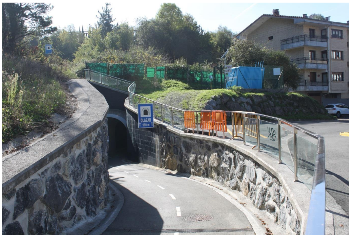
Figur 22: På sørsiden av tunnelen.
