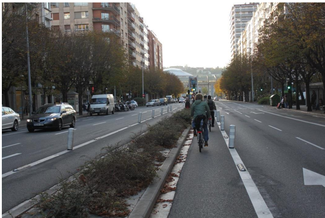
Figur 35: Midtstilt sykkeltilbud med rabatt mellom feltene, adskilt fra øvrige kjørefelt med plastpulleter.
