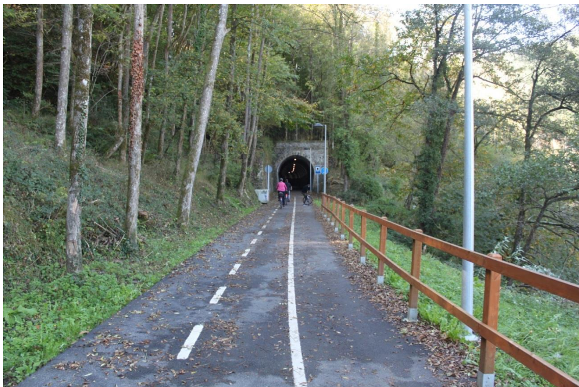
Figur 25: Første sykkel tunnelen på strekningen. Denne tunnelen er 163 meter lang. Sykkelvegen er separert på utsiden av tunnelen, men dette avsluttes inn mot tunnelen hvor det er blandet trafikk.
