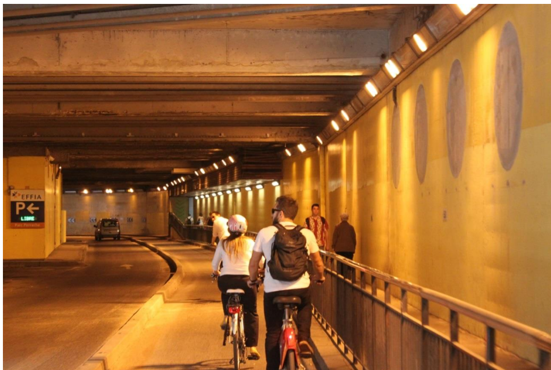
Figur 13: Et kjørefelt er omgjort til tovegs sykkelveg og fortau, fysisk skille mellom trafikantgruppene. Tunnel under Perrach-jernbanestasjonen. Før ombyggingen var denne en hindring for fotgjengere og syklister da motorvegen A7-E15 krysser her. Naturlig nok blir det noe støy fra biltrafikken her, men tunnelen er relativt kort.
