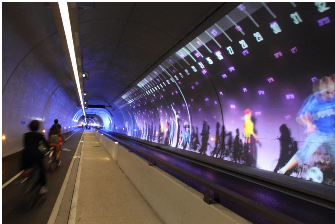
Figur 14: Tunnel de la Croix-Rousse. Eget tunnellop for syklende, gående og kollektiv. Åpnet desember 2013 og kan bygges om for å tilrettelegge for trikk.
