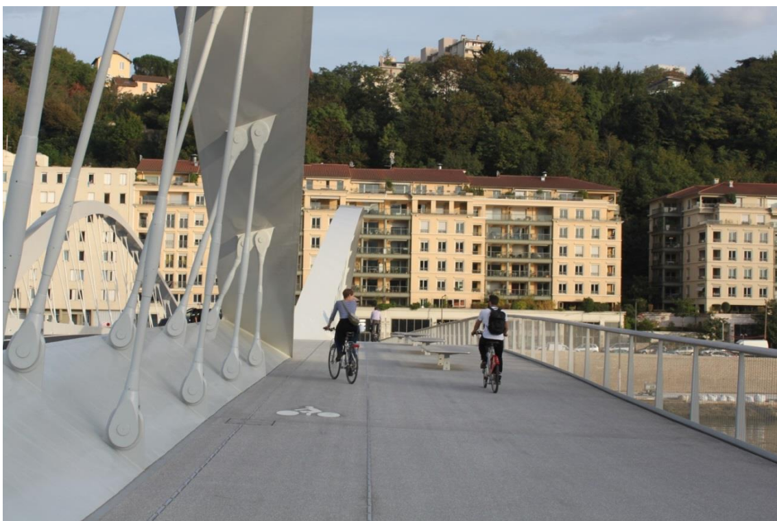
Figur 16: Pont Schumann med benker på midten av brua.
