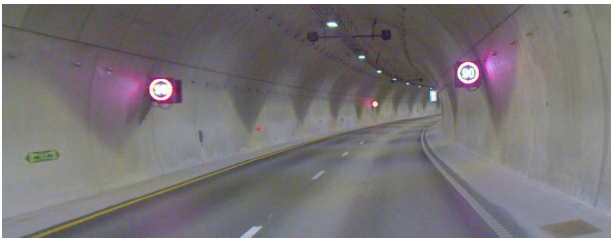
Figur 2: Tunnel i retning Drammen med VMS fartsgrense (foto: Statens vegvesen vegbilder)
