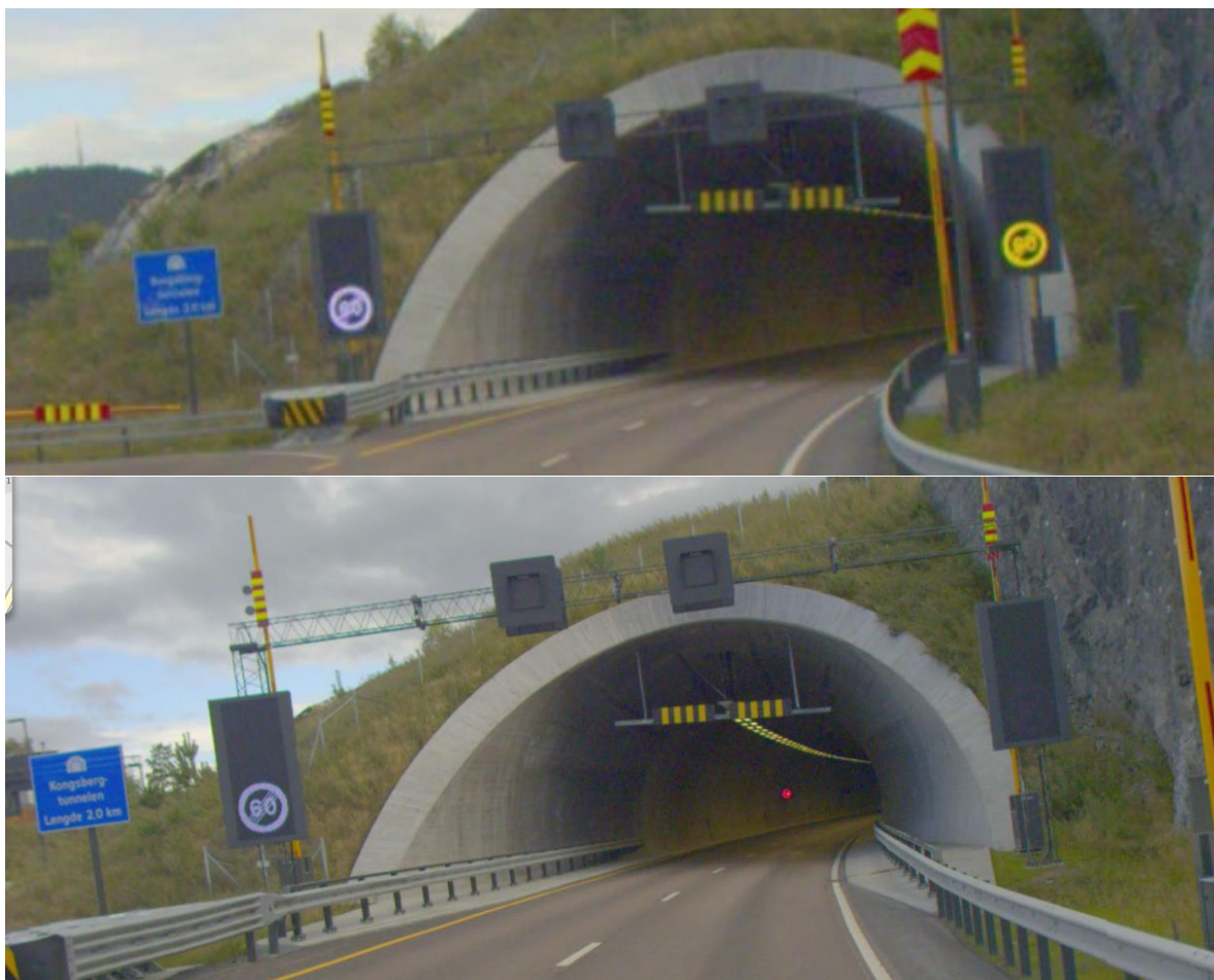
Figur 5: To utsnitt med VMS med implisitt fartsgrense ved Kongsbergtunnelen (foto: Statens vegvesen vegbilder)
