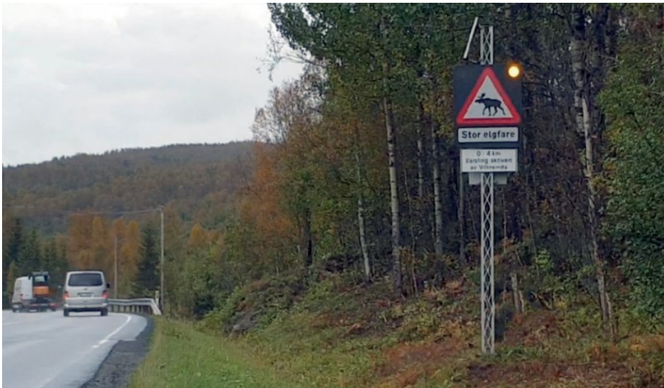
Figur 18 Bilde som viser at det gule varselblink er aktivert. Foto SafeZone AS (som i dag heter Amparo Solutions AS)
