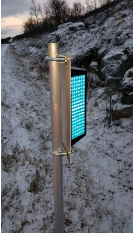
Figur 10 Typen blå refleks som ble brukt på Fv863. Foto Henrik Wildenschild, Statens vegvesen
