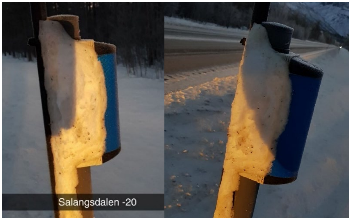
Figur 11 Bilde av blå reflekser hvor det har satt seg snø på stolpe og refleks. Det er tatt i minus 20 grader celsius på E6 i Bardu kommune. Foto Henrik Wildenschild, Statens vegvesen
