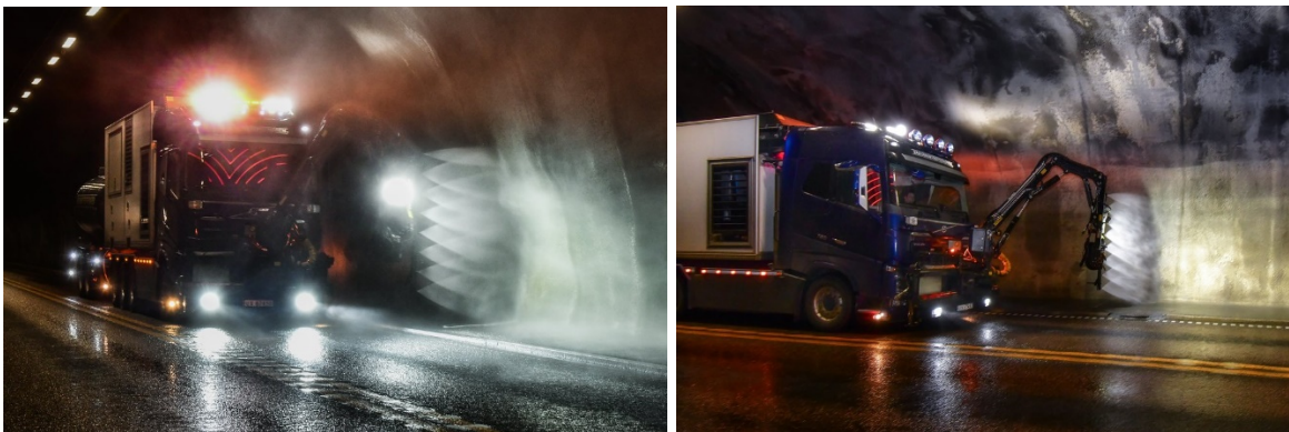
Figur 13: Høytrykksspyling av tunnelvegg (Foto: Knut Opeide)
