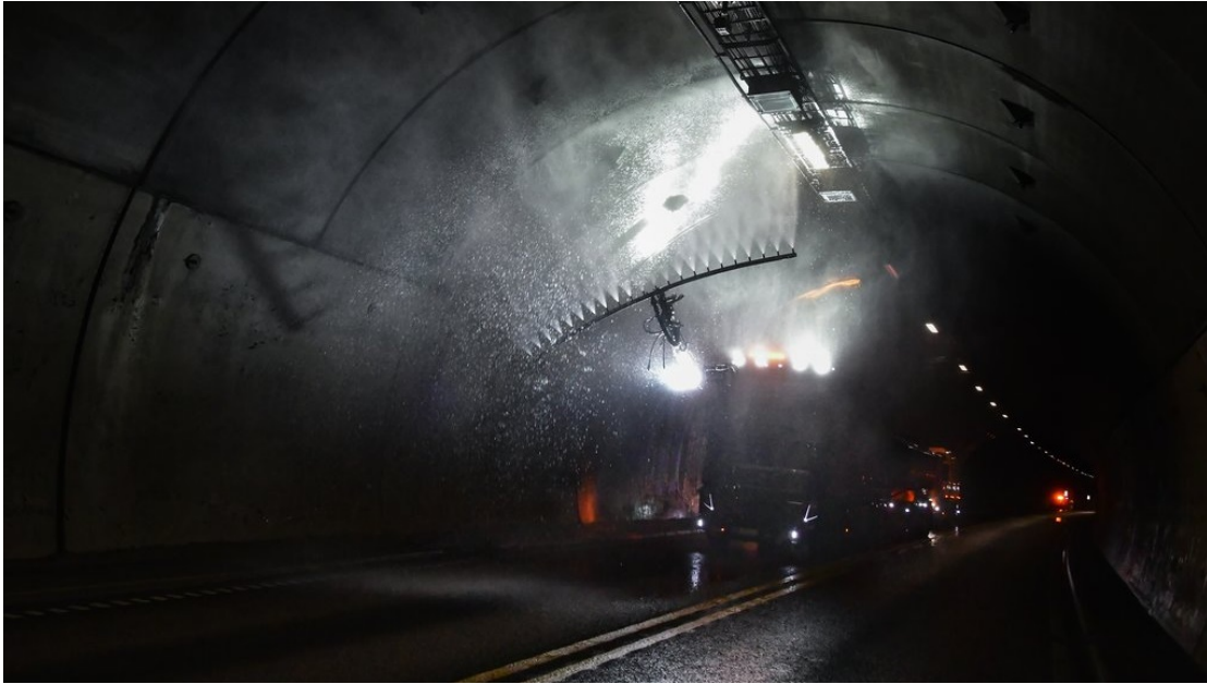
Figur 12: Høytrykksspyling av tak (Foto Knut Opeide)
