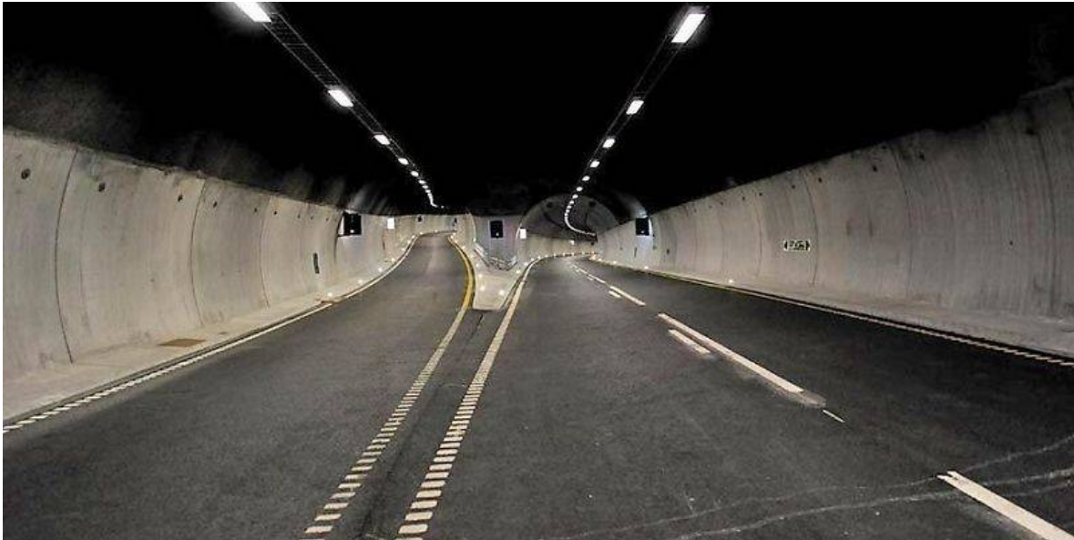
Figur 7: Strindheimtunnelen (Foto: Statens vegvesen)
