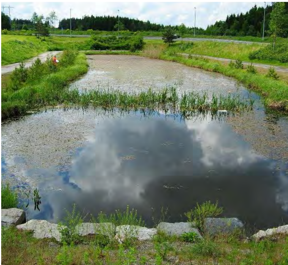
Figur 4.14: Åpen, naturbasert renseløsning . Statens vegvesen, 2015.
