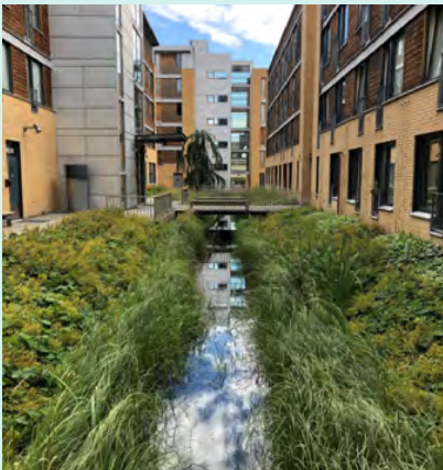
Figur 4.10: Overvannsdam med permanent vannspeil . Sina Killi, 2021.
