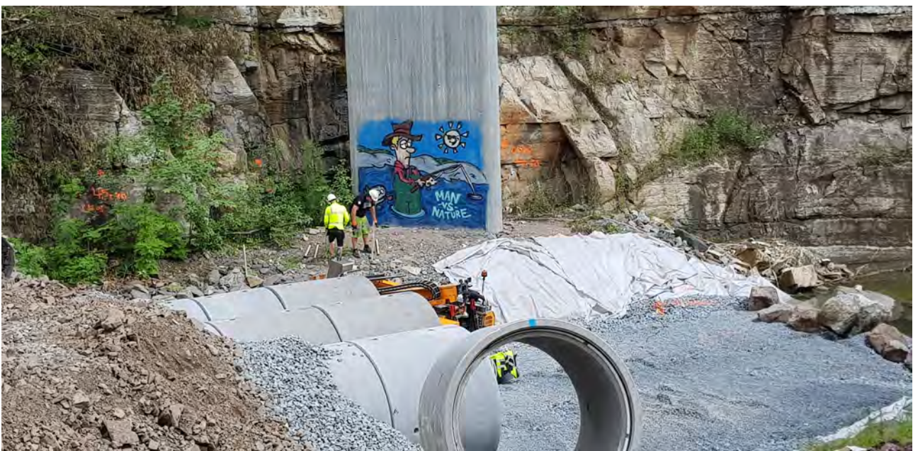
Figur 6.11: Foto fra anleggsarbeid ved Isielva, Sandvika. Sverre Landmark, 2021.
