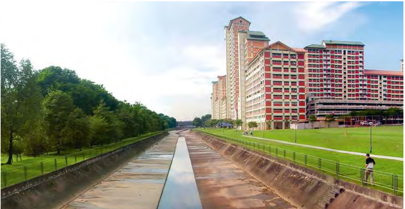
Figur 5.1: Bishan-Ang Mo Kio Park . Rambøll, u.å. Bildet viser den gamle betongdreneringskanelen før restaureringen.
