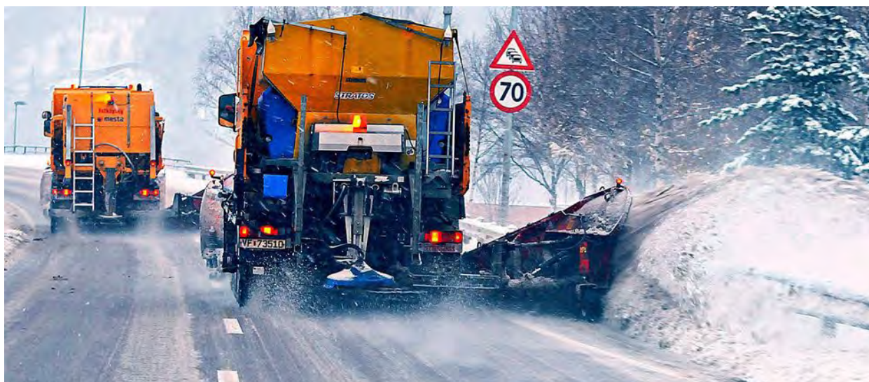
Figur 4.15: Salting av veg . Knut Opeide (Statens vegvesen), u.å.
