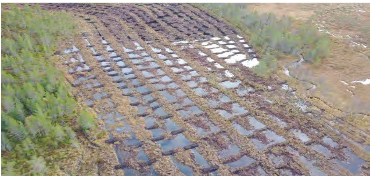
Figur 4.6: Igjenfylling av grøfter i Aspåsmyran naturreservat. Statsforvalteren i Møre og Romsdal, 2019.
