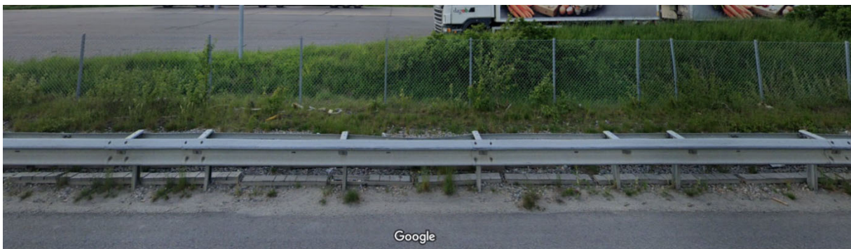
Figur 2 – Bilde av feltstasjonen fra veggside, fra avstand (øverst) og nærbilde (nederst). De store prøvestykkene er skjult av autovernet. Kilde: www.google.se/maps
