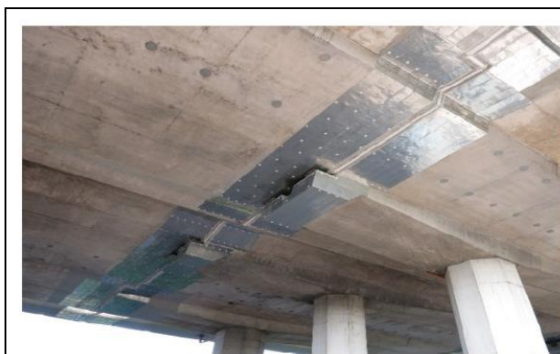
Figur 32. Monterade zinkplattor på betongen.
