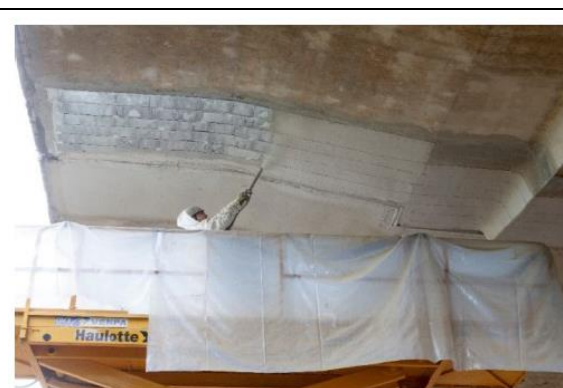
Figur 33. Plattorna täcktes med ett bruk.
