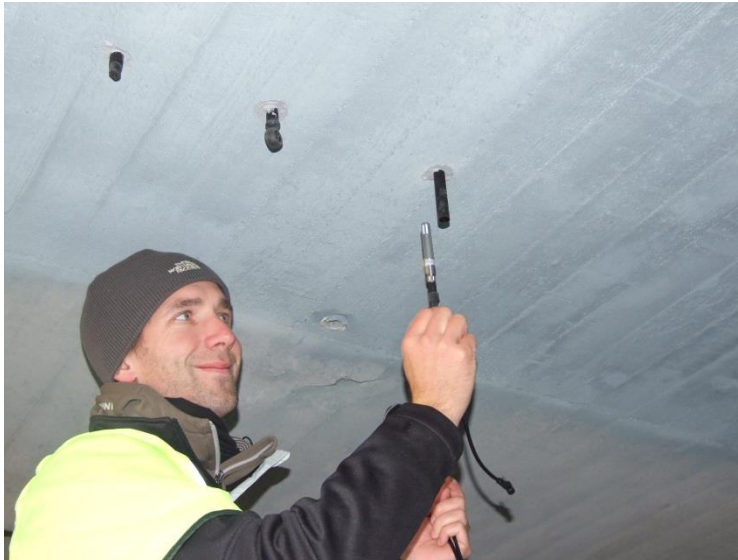
Figur 44B. Inmontering av temperatur- och fuktgivare i förborrade hål, undersida broåda, Göteborg.
