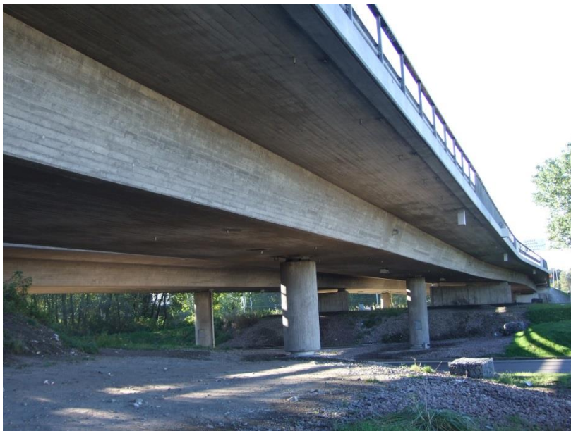
Figur 41B. Vägbro nr 14-884-3, Hjalmar Brantings väg.
