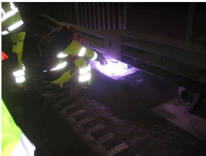
Figur 48B. Ljusbågssprutning av kantbalk till stödmur vid Essingeleden Stockholm.
