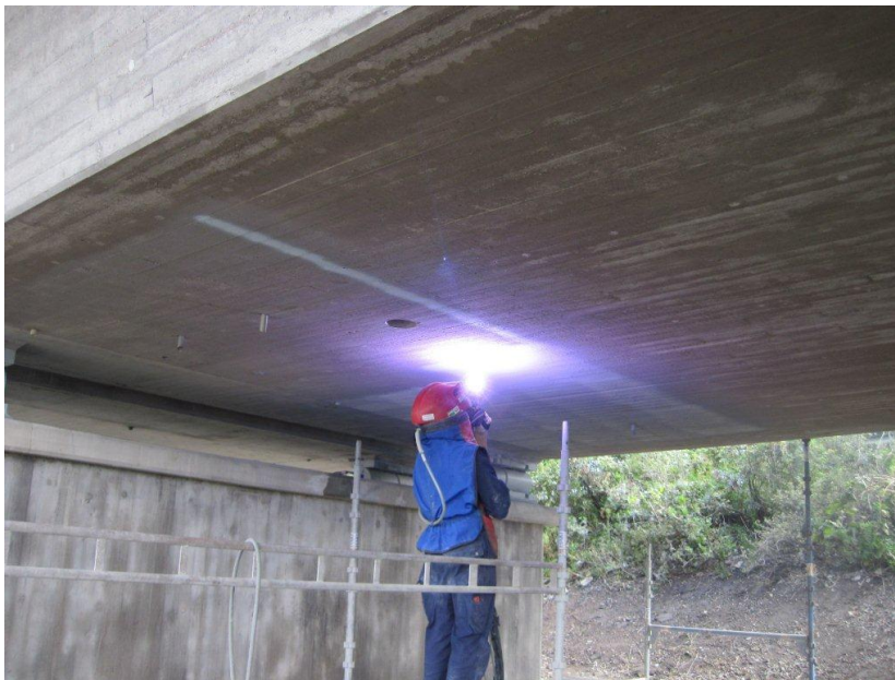
Figur 47B. Termisk ljusbågssprutning av zink på undersida brolåda för vägbro 14-884-3 i Göteborg
