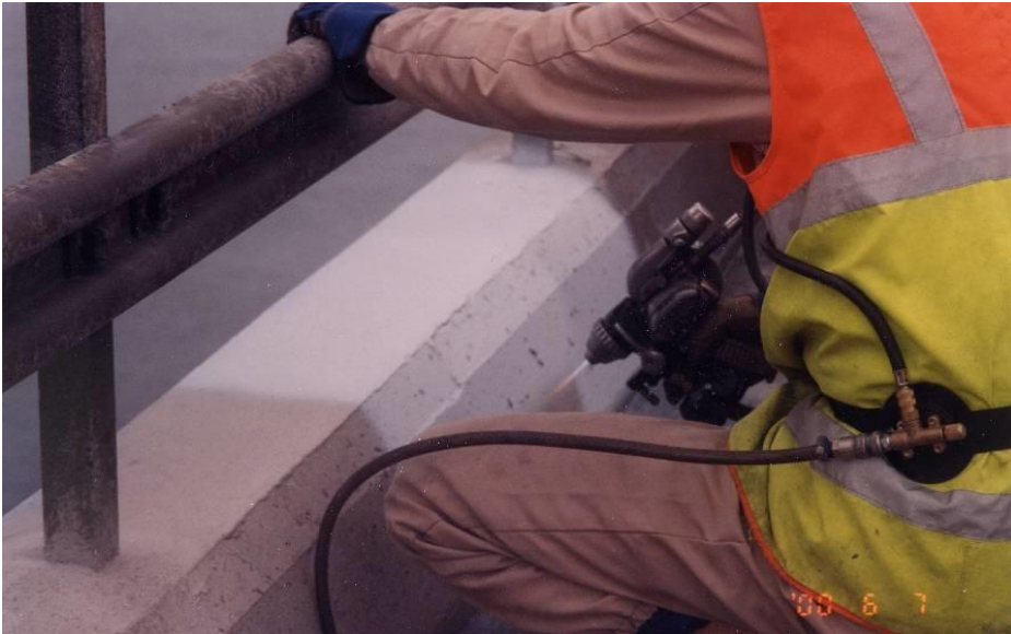
Figur 17B. Termisk sprutning av kantbalken med flamsprutningsteknik, Ölandsbron.
