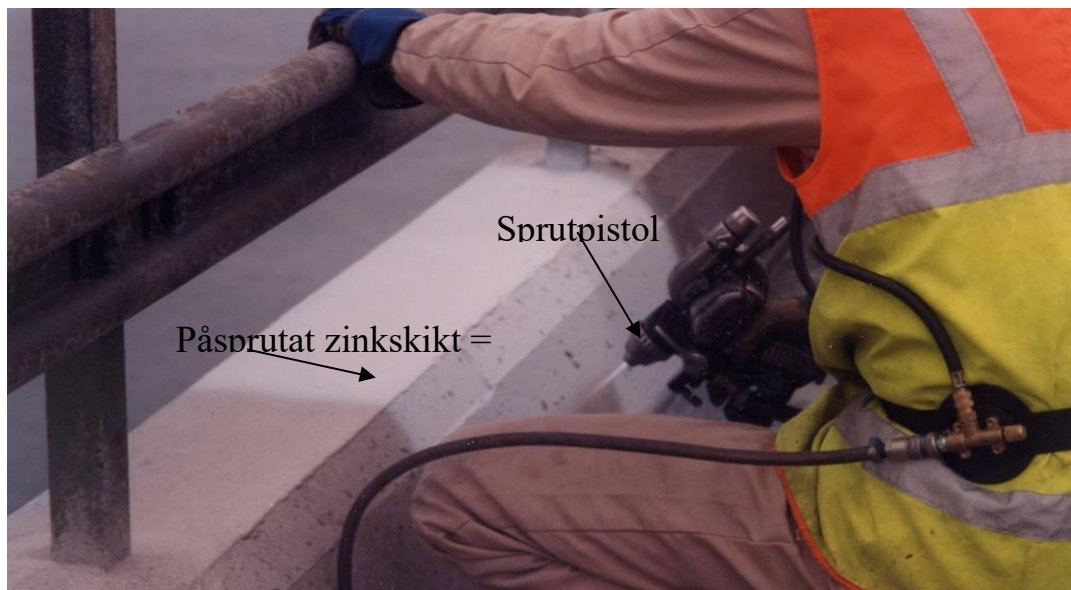
Figur 3B. Termisk påsprutning genom flamsprutningsteknik av zink på kantbalk vid Ölandsbron [5].
