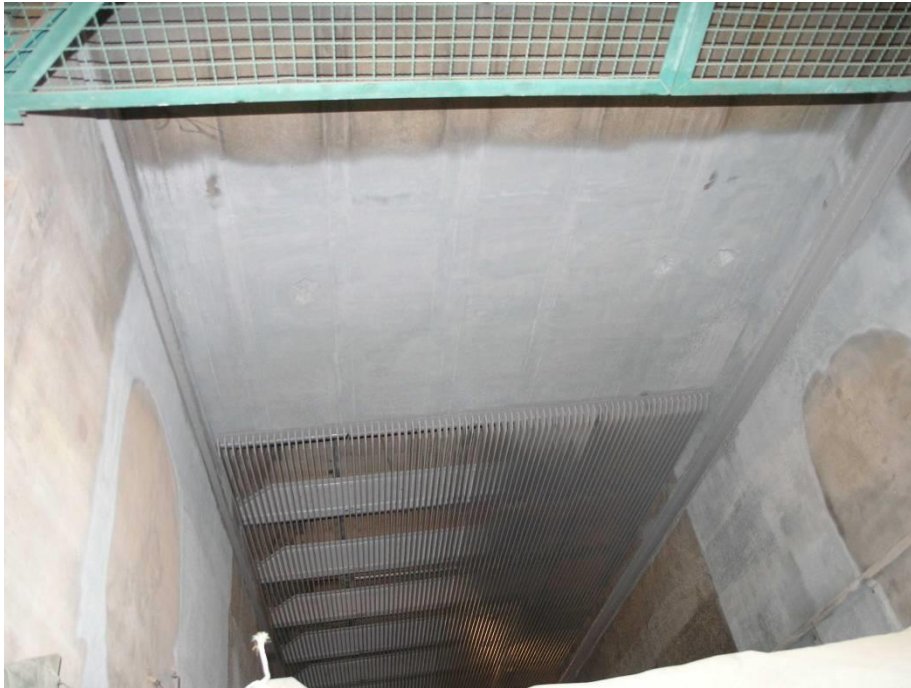
Figur 18B. Termiskt sprutad vägg vid silgata, Forsmark.
