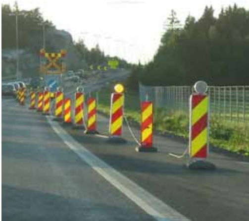
Figur 27 Eksempel på gult blinksignal som ledelys
