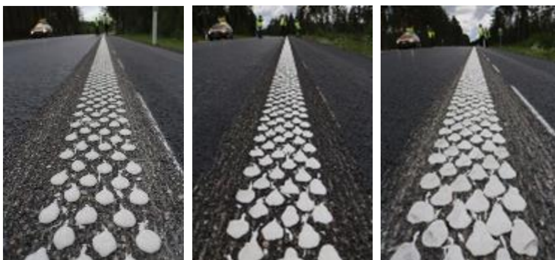
Figur 2: Kantlinje fra Eurostar (dråpeflex) med henholdsvis 3,8 – 4,7 – 6,3 kg/m 2 (Foto: Bjørn Nossen)
