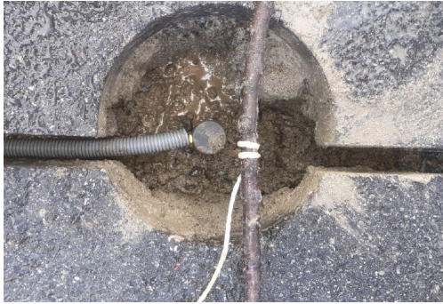
Figur 10: Installasjon i veg
