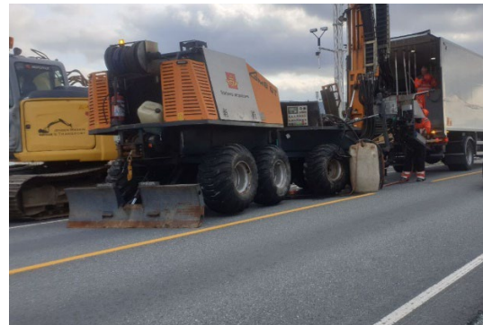
Figur 9: Skovelboring med borrygg
