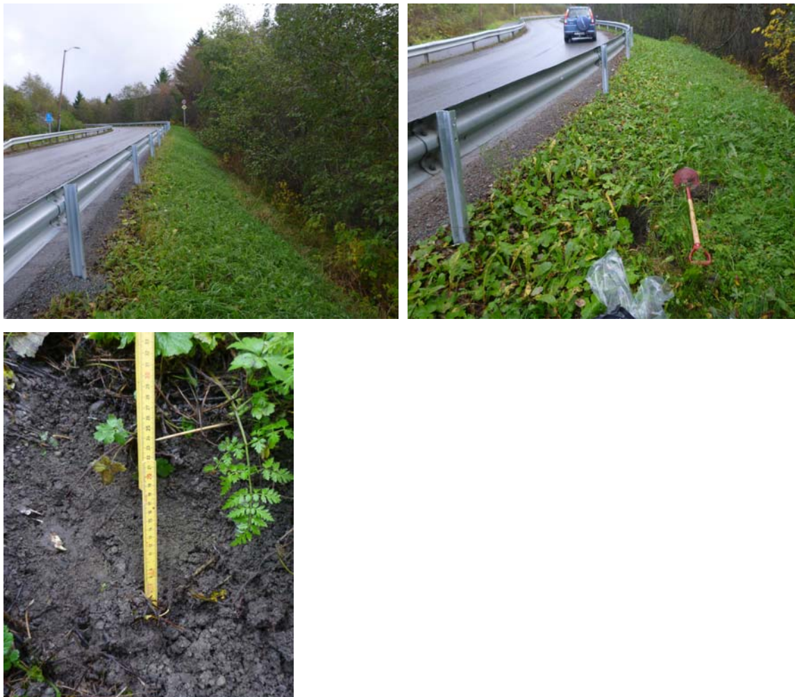
Figur 16: Foto 2.2 Løvsetvegen – silt/leire grunn
