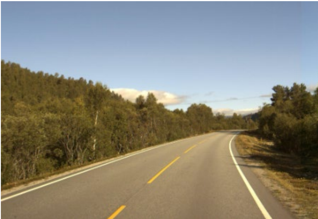
Figur 5: Tradisjonell midtlinje uten nedfresing på Fv27 nord for Nordre Enden (Foto: Vegbilder, Statens vegvesen)
