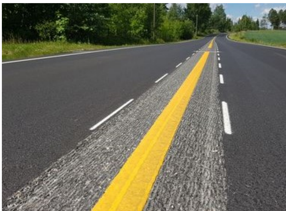
Figur 2: Eksempel på plan nedfresing av midtlinje (Foto: Terje Giæver)
