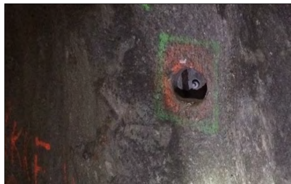
Figur 1.4.10-4: Nærbilde av prismefeste, uten prisme montert
