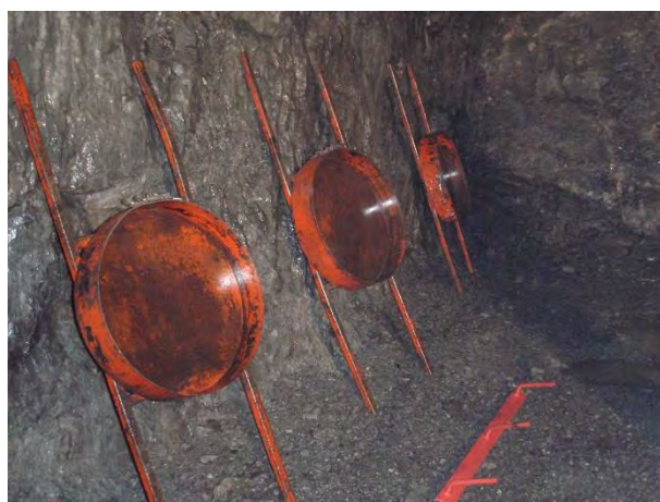
Figur 3.1.9-1: Former stilt opp og klare for sprøyting
