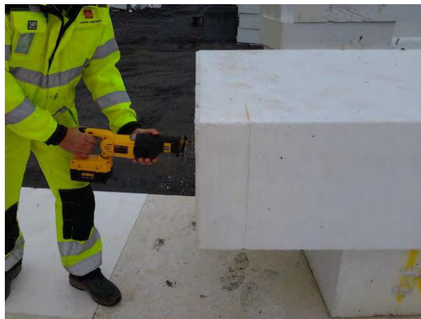
Figur 1.5.2-3: Eksempel på utskjæring av firkantprisme med bajonettsag fra blokkhjørne
