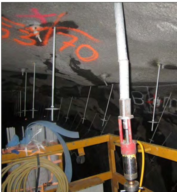
Figur 1.4.12-3: Lange distanserør for trekking av festebolter for vann-/frosstsikring (foto: Statens vegvesen)
