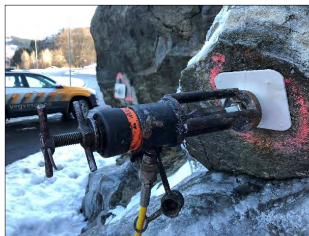
Figur 1.4.12-1: Prøvetrekking med manuell, trykk-luftdrevet jekk (foto: Statens vegvesen)
