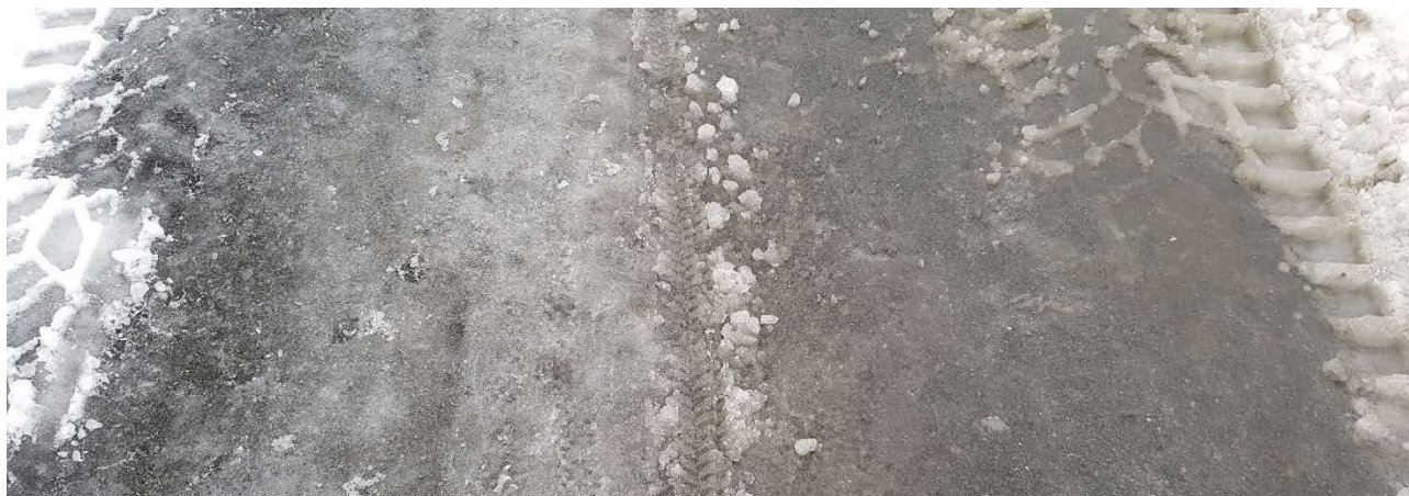
Figur 16: GsB Jonsvannsveien observasjon 1.
