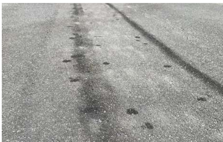
Figur 15: Bakkemerker av vannspyling etter feiing (Foto: I. Roche Cerasi).
