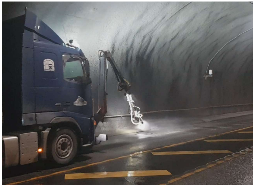
Figur 30 Vasking av bankett.
