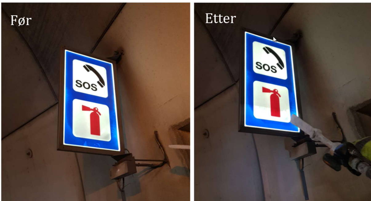
Figur 13 Effekten av tørris på nødlys/skilt
