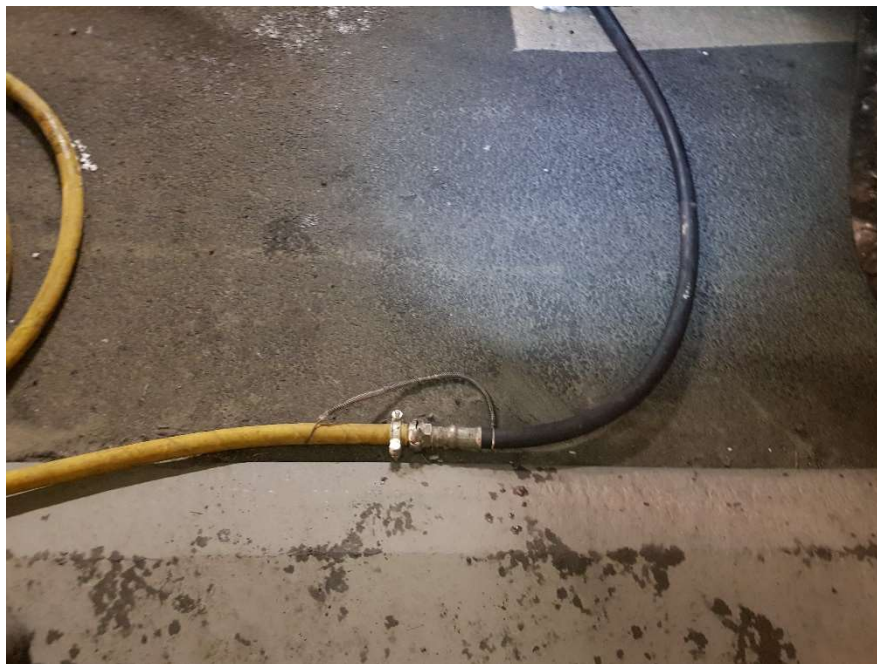
Figur 9 Slange fra kompressors (gul) koblet til spylerslange (svart)
