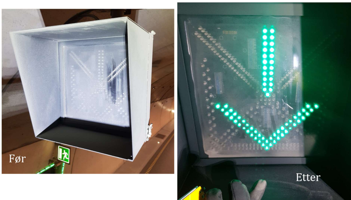
Figur 15 Effekten av tørris på lys skilt
