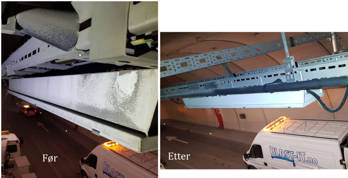
Figur 14 Effekten av tørris på armatur
