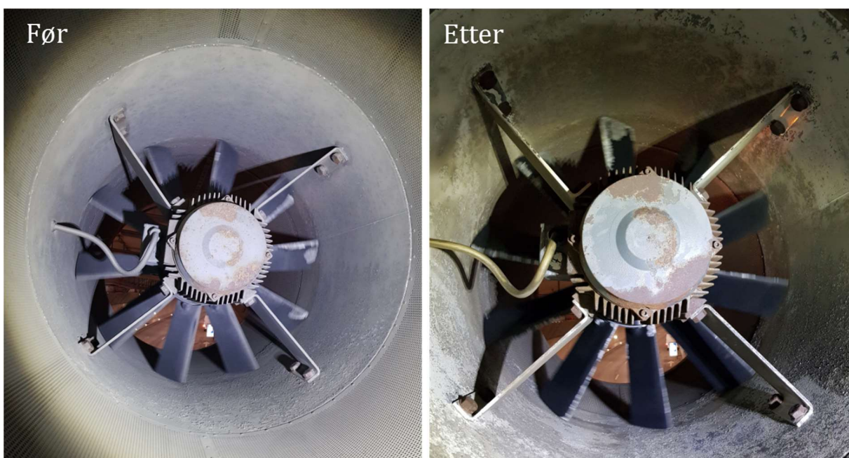
Figur 18 Effekten av tørris på vifte
