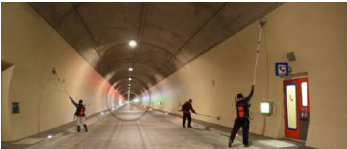
Figur 34 Pålegging av Nanopool.
