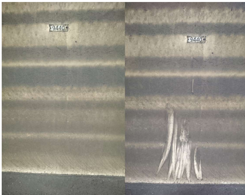
Figur 21 Resultat av useriøs entreprenør og dårlig/mangelfull beskrivelse i kontrakt
