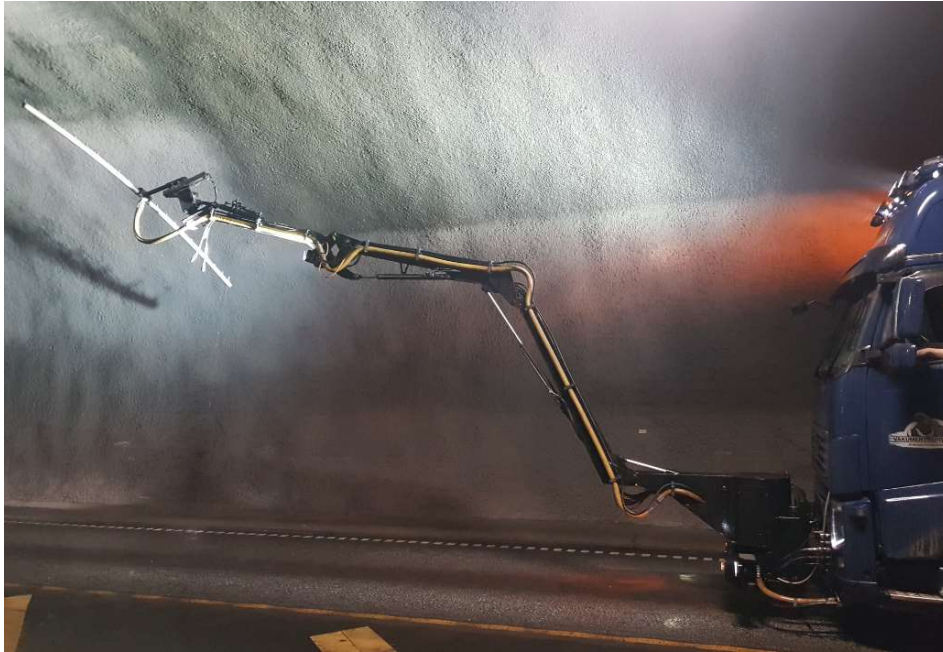
Figur 29 Vaskearm for rengjøring av tak og vegger. Det var behov for flere drag for å dekke hele tunnelhvelvet.
