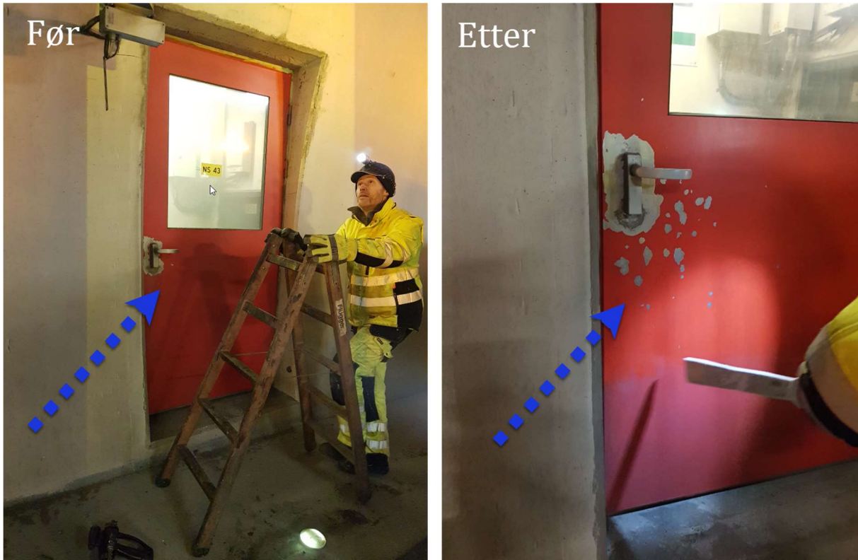
Figur 12 Effekten av tørris på nødkiosksdør (til høyre). Legg merk til avflaking pga. for mye trykk og mulig dårlig maling.
