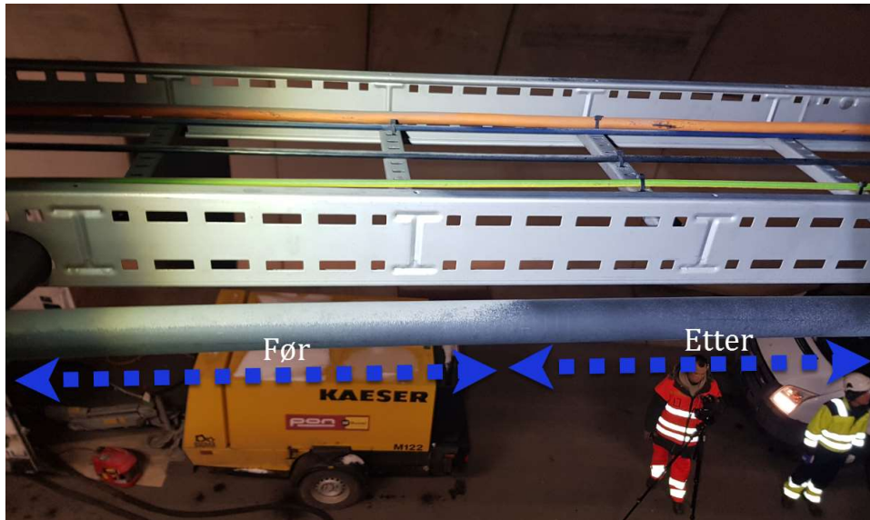
Figur 16 Effekten av tørris på plastrør
