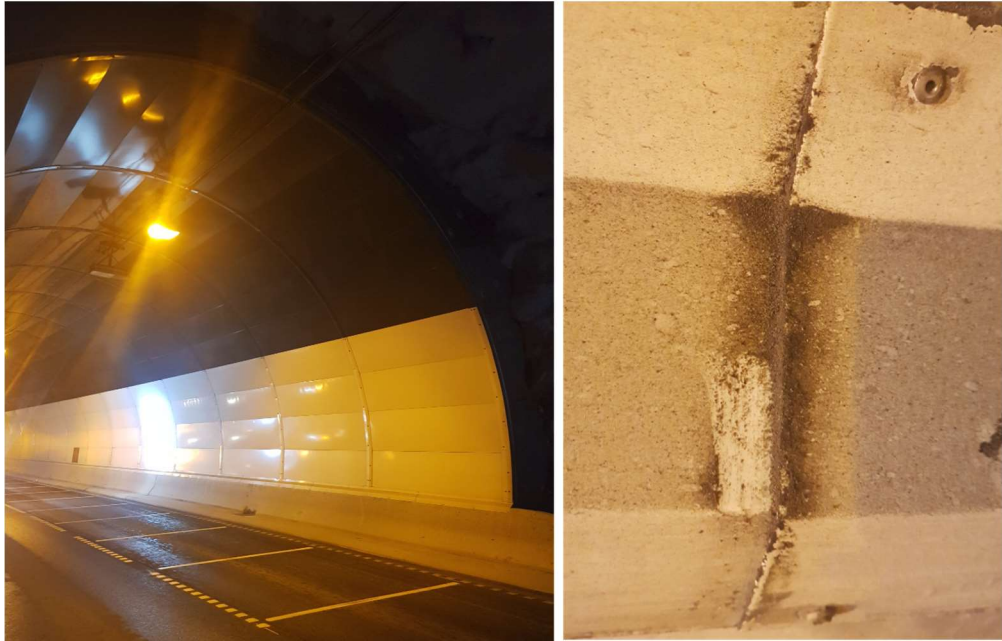
Figur 25 Stålplater i Stordalstunnelen.
